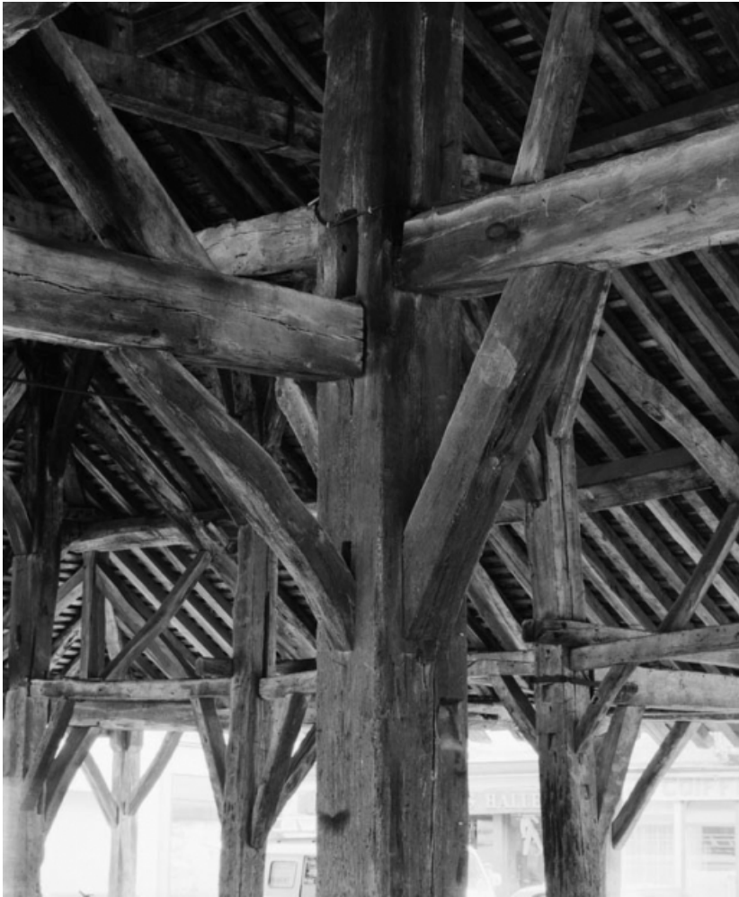
Détail d'un poteau central.
