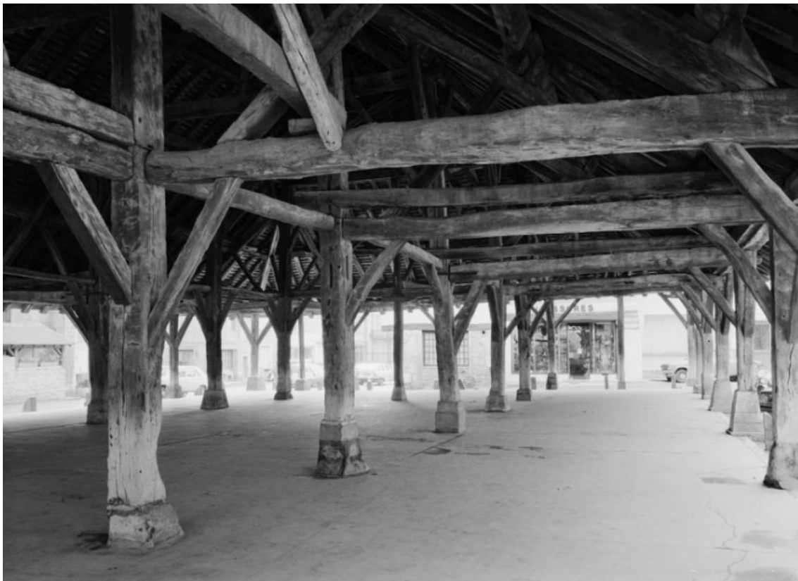
Vue intérieure (partie nord).
