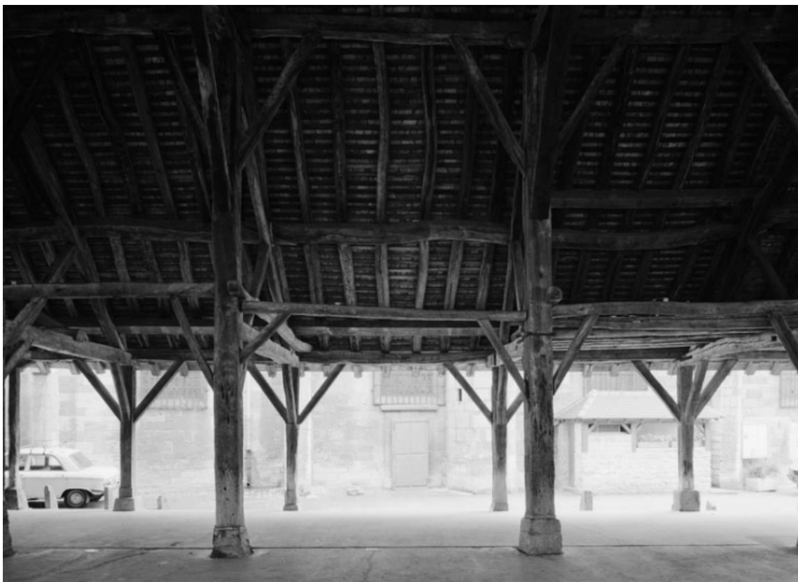
Vue intérieure longitudinale.
