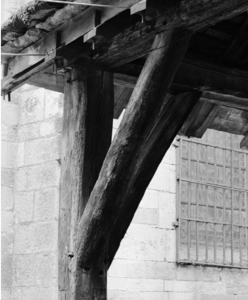
Détail : poteau cornier de l'angle sud-est. 21, Nolay Halles
