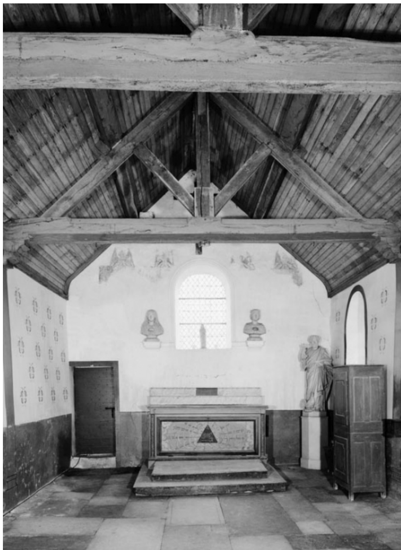
Intérieur : vue depuis l'entrée.
