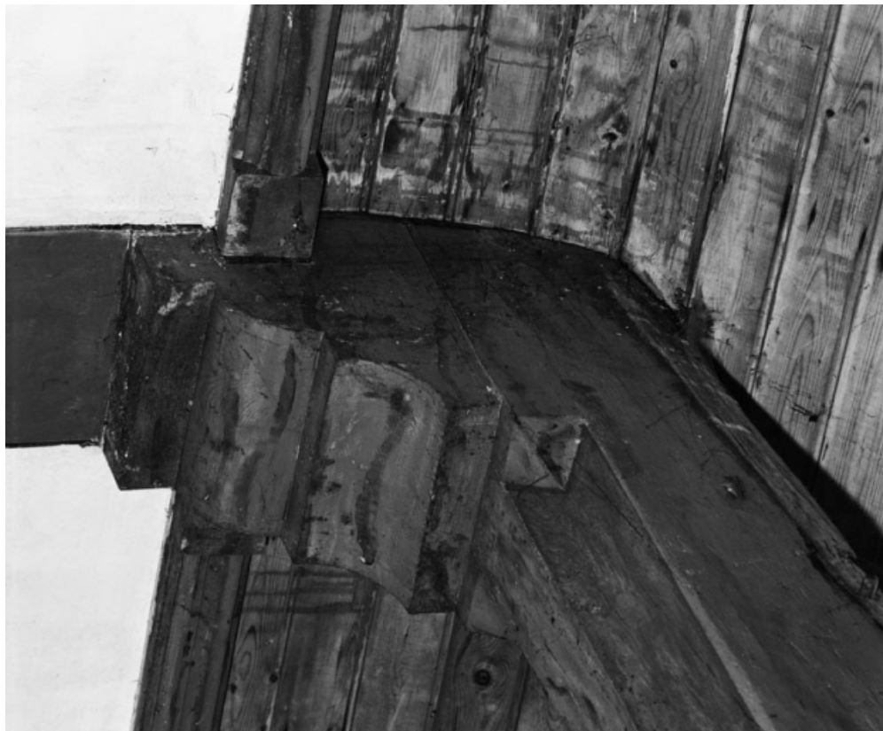
Détail d'un corbeau de la charpente.
