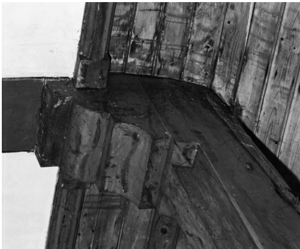
Détail d'un corbeau de la charpente.
