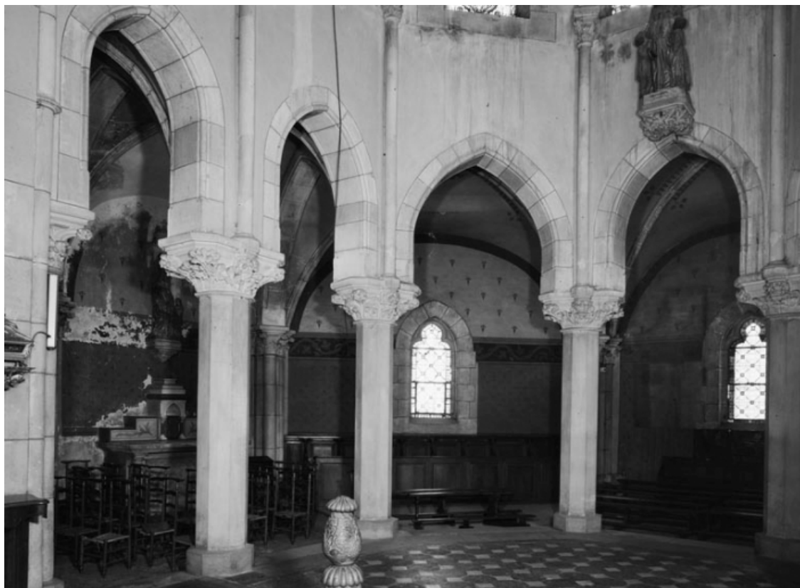
Vue du rond-point du choeur.
