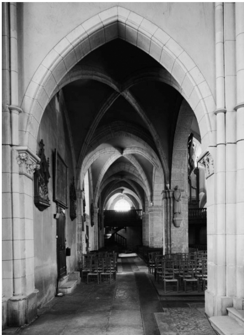
Bas-côté droit, vu depuis le transept. 21, Nolay
