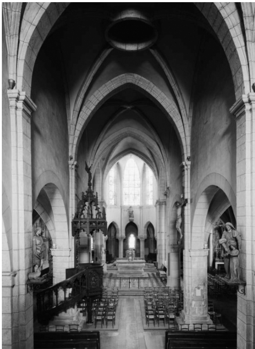
Nef, vue depuis l'entrée.
