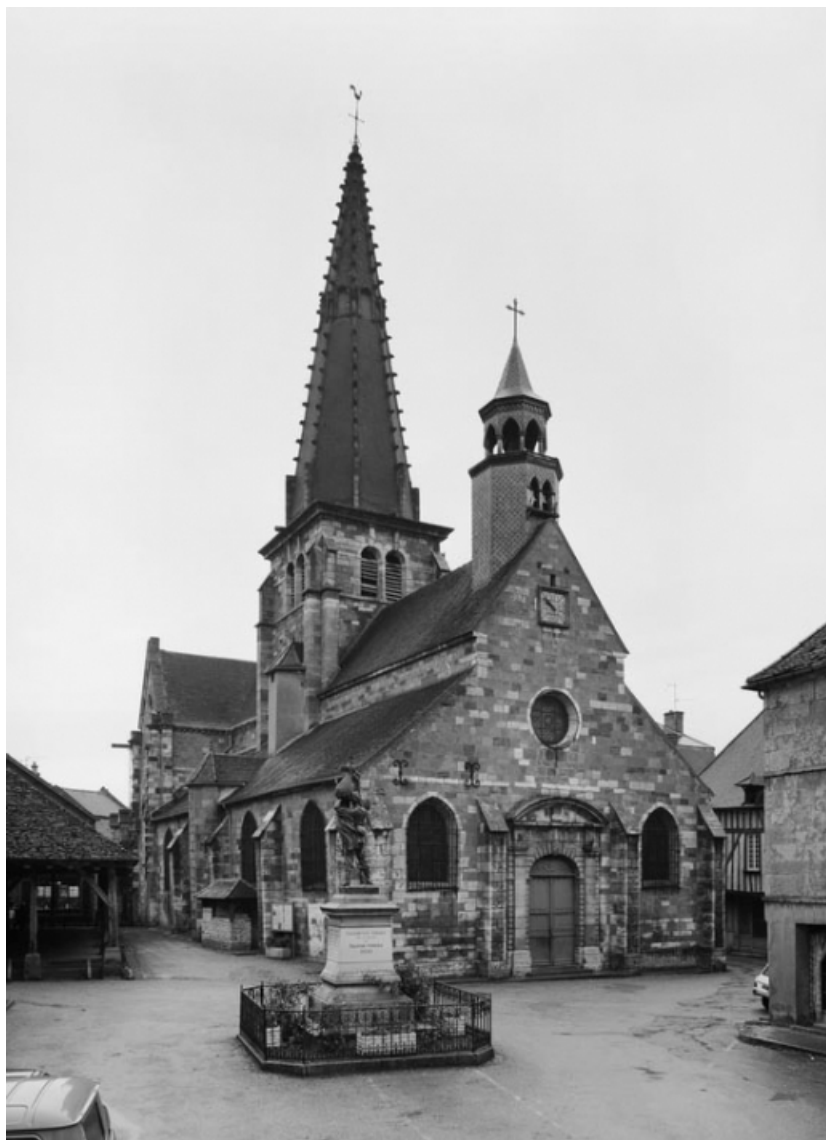
Vue d'ensemble, de 3/4 gauche.
