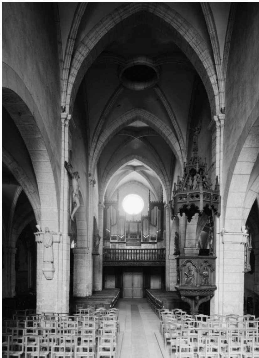
Nef, vue depuis le chœur.
