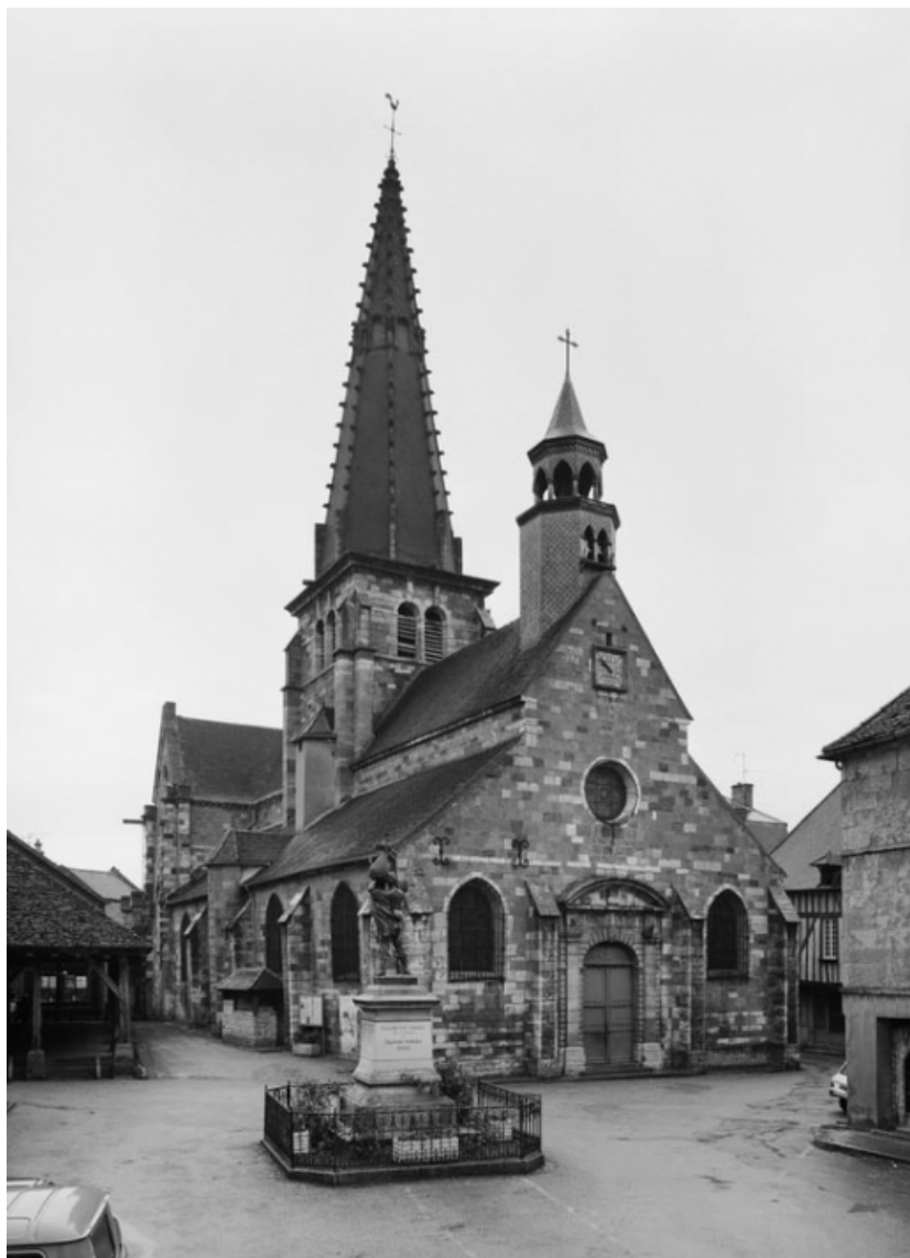
Vue d'ensemble, de 3/4 gauche.
