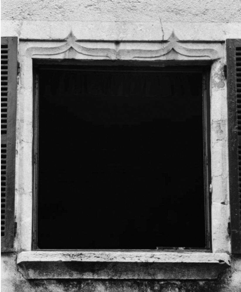
Détail d'une fenêtre.
