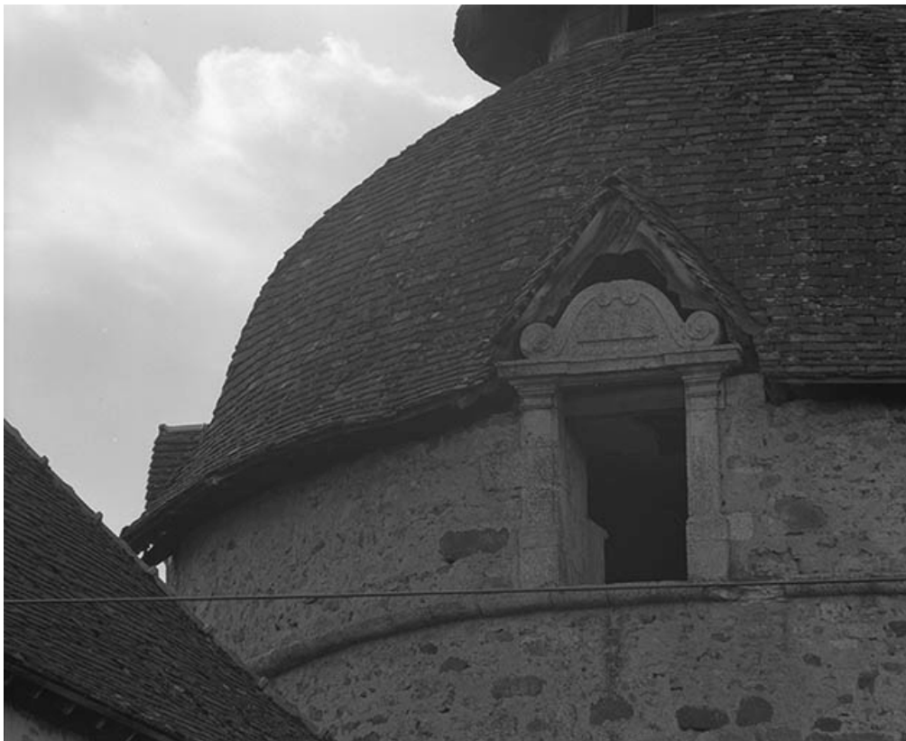
Tour d'angle, détail d'une lucarne. 21, Molinot
