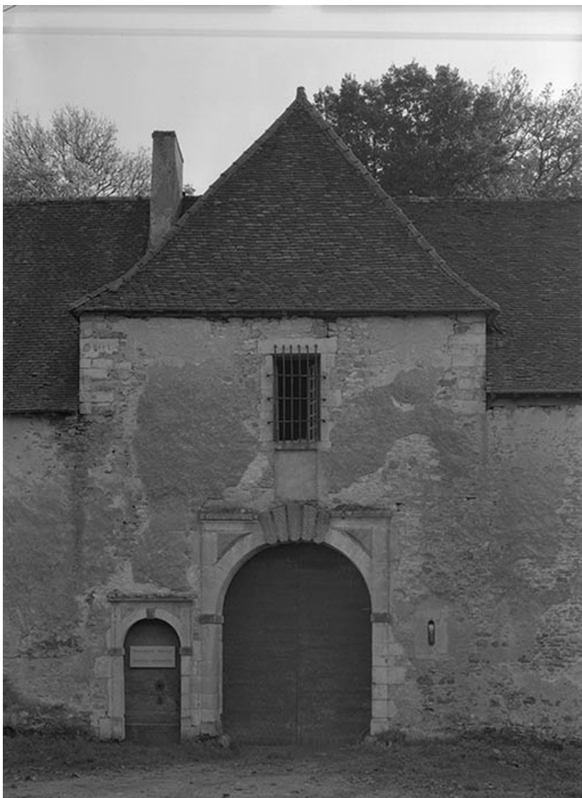
Communs : corps de passage.
