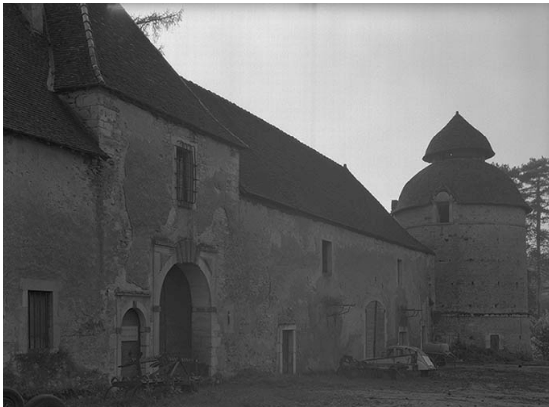
Communs (partie droite) et tour d'angle. 21, Molinot
