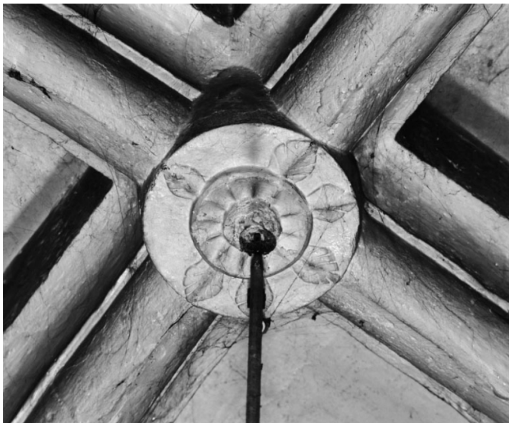
Chapelle droite : clef de voûte. 21, Molinot
