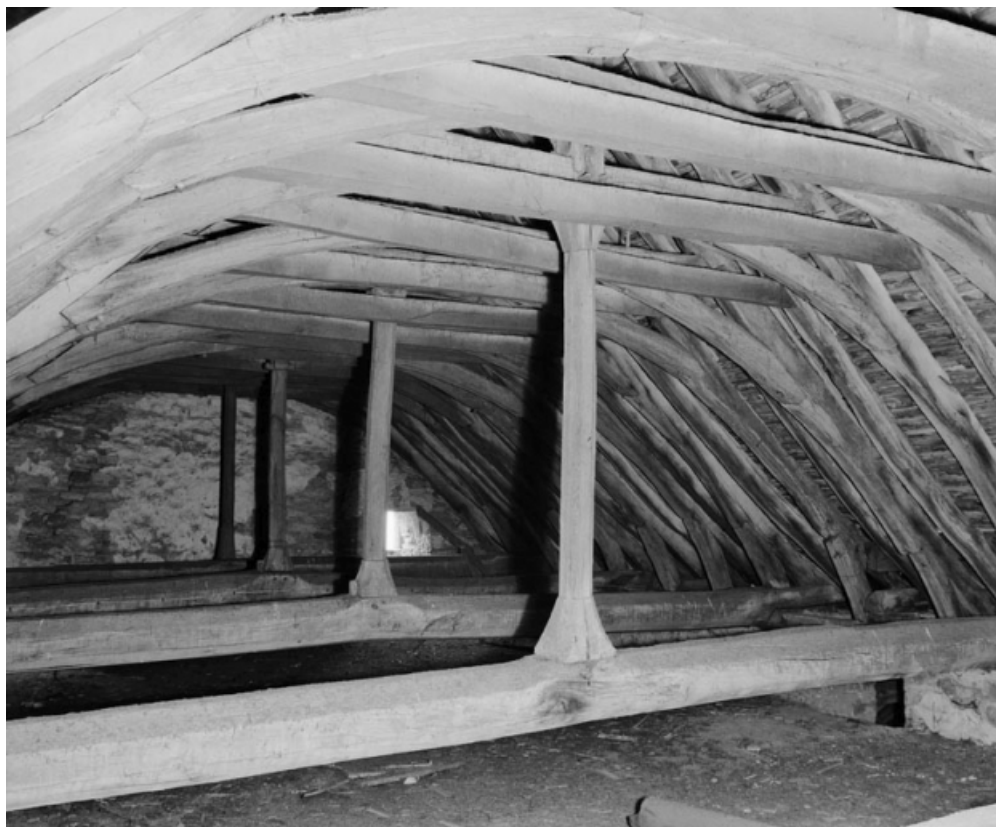
Charpente de la nef.
