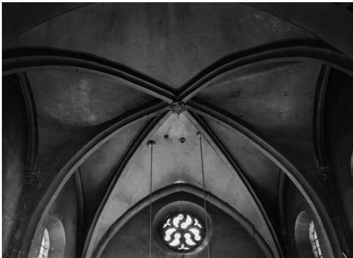
Nef : voûte de la 1ère travée.
