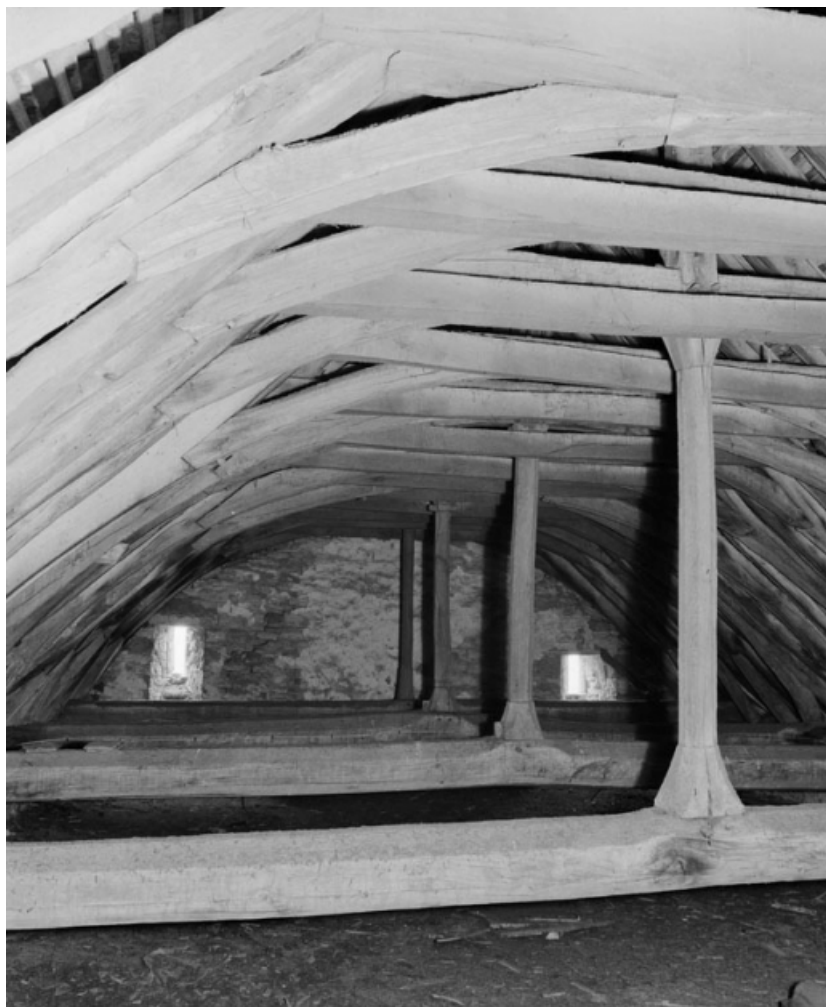
Charpente de la nef.
