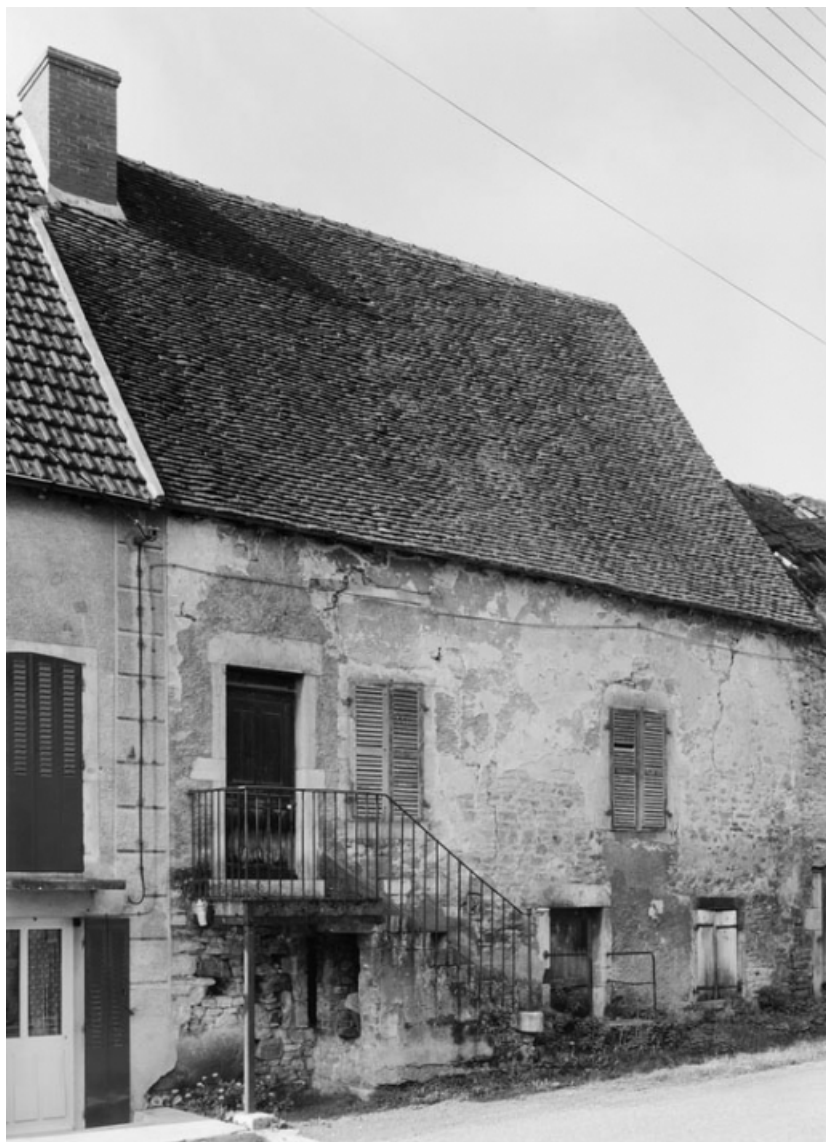
Vue générale de la maison sise parcelle 246, section AB du cadastre de 1958. 21, Molinot
