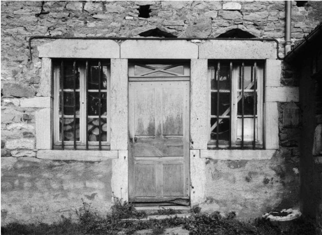
Détail de la porte et des fenêtres de la façade postérieure de la maison sise parcelle 237, section AB du cadastre de 1958. 21, Molinot
