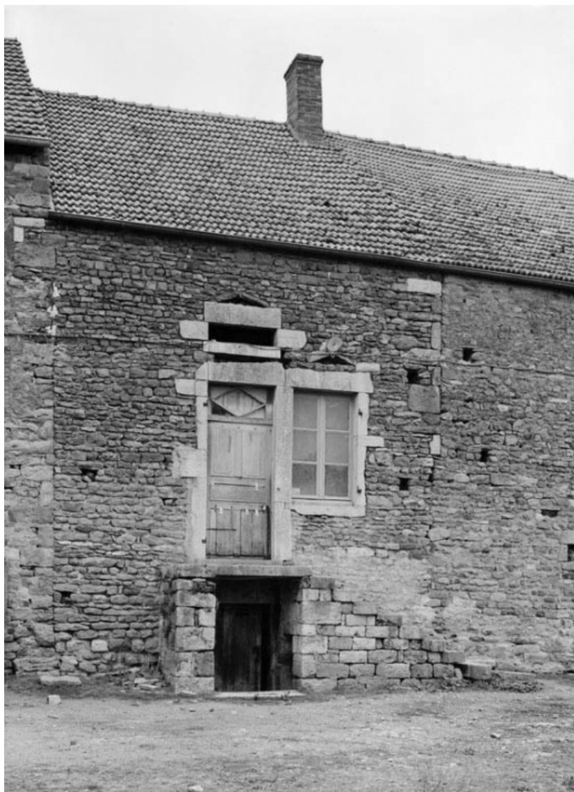
Façade de la maison sise parcelle 376, section A3 sur le cadastre de 1934. 21, Jours-en-Vaux
