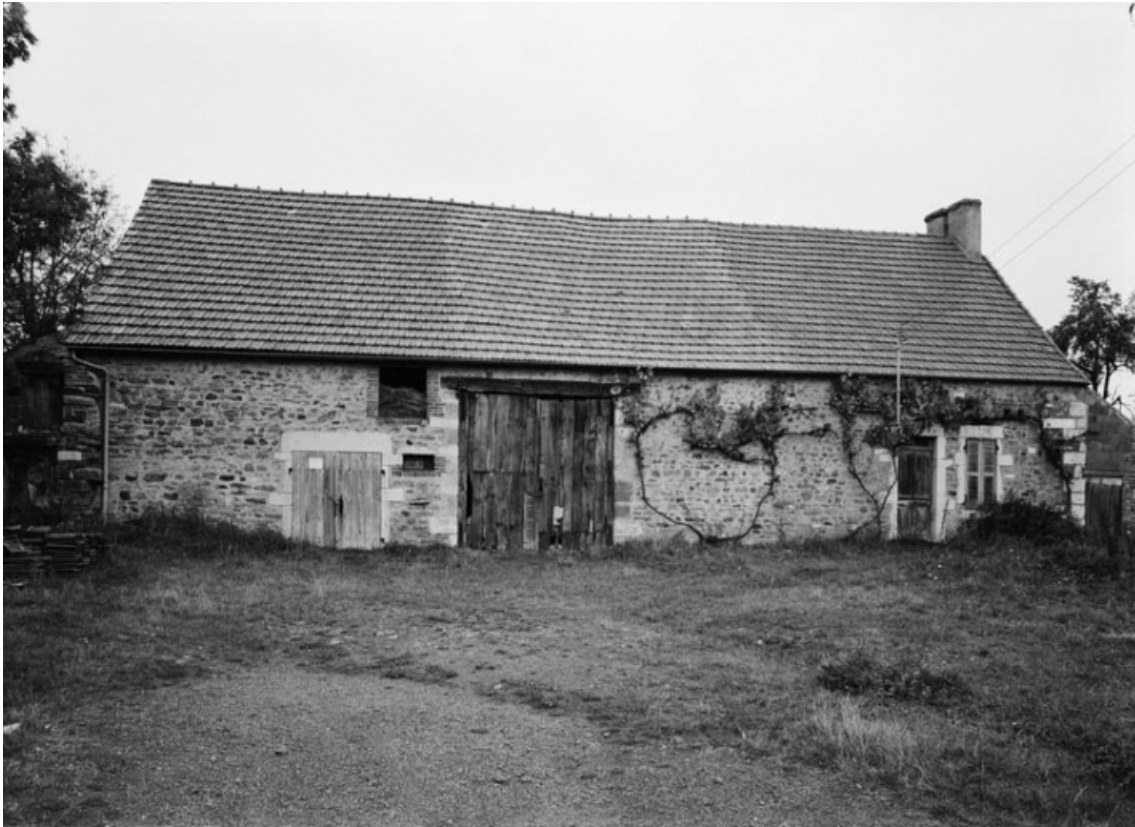
Vue d'ensemble de la ferme sise parcelle 211, section C3 sur le cadastre de 1934. 21, Jours-en-Vaux
