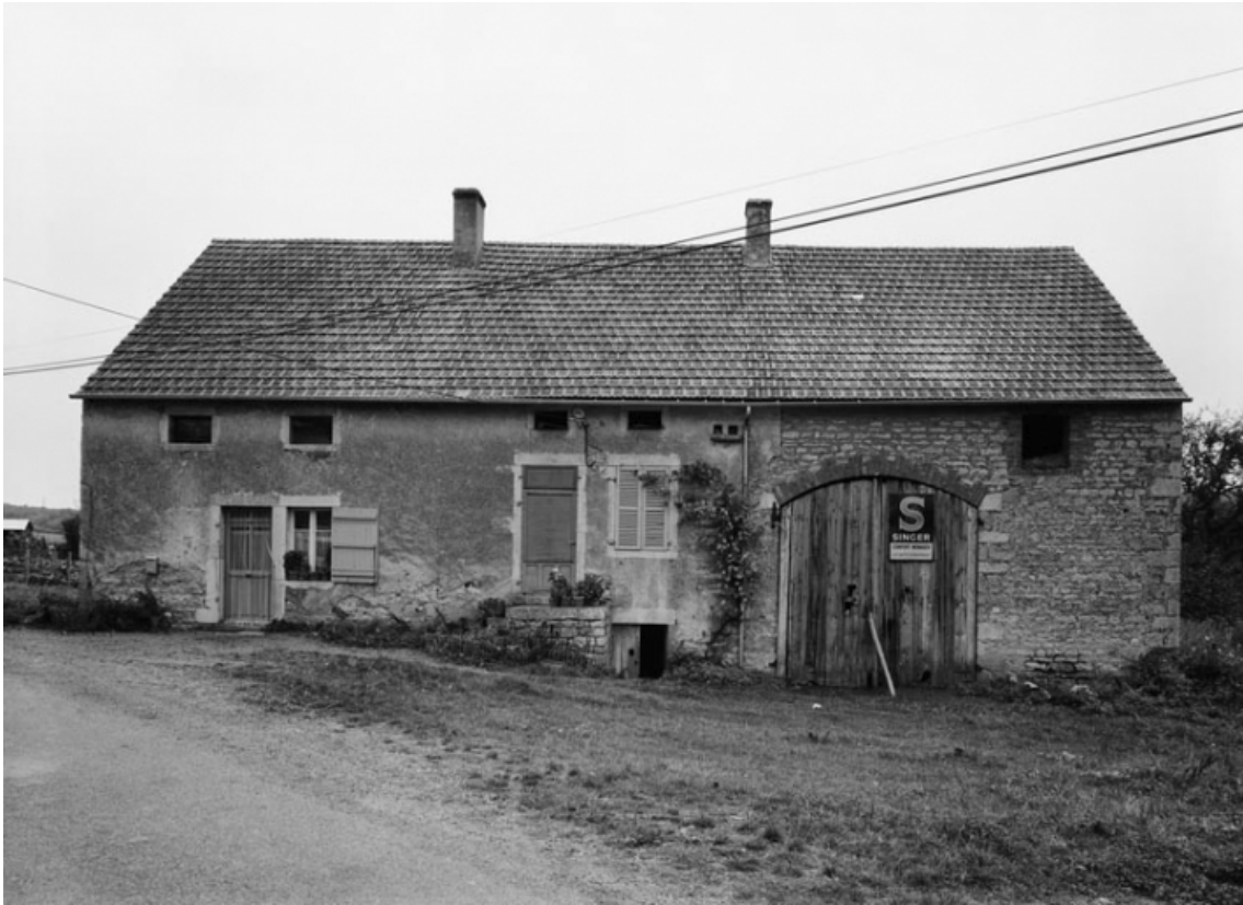
Vue d'ensemble de la ferme sise parcelle 257, section C3 sur le cadastre de 1934. 21, Jours-en-Vaux
