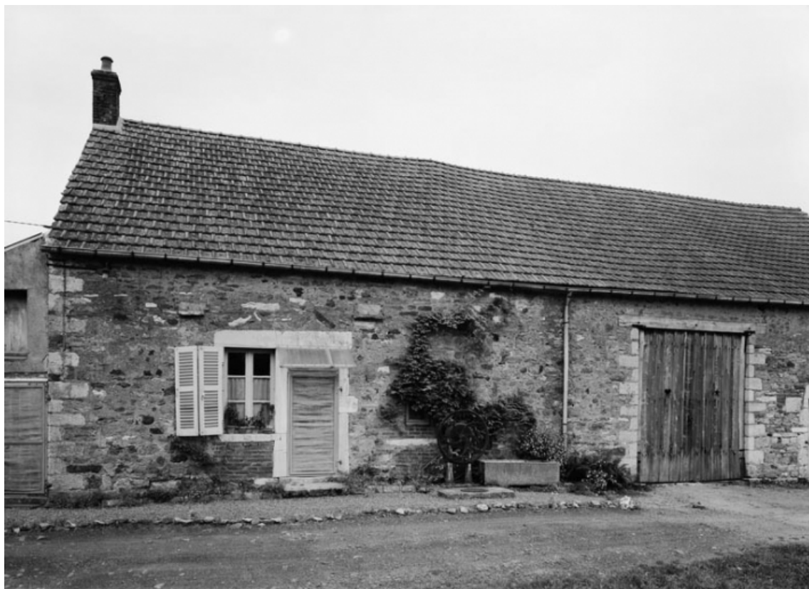
Vue d'ensemble de la ferme sise parcelle 293, section C3 sur le cadastre de 1934. 21, Jours-en-Vaux
