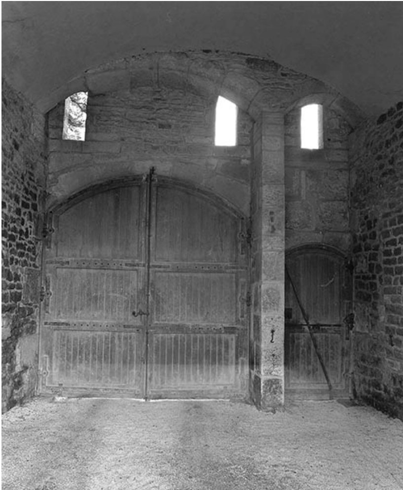
Tour-porche : intérieur du porche.
