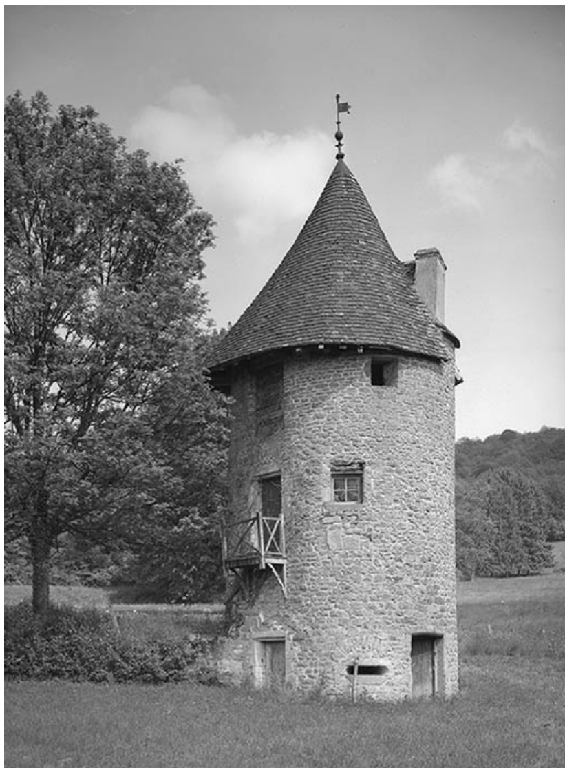
Tour sud-est, vue depuis la cour.
