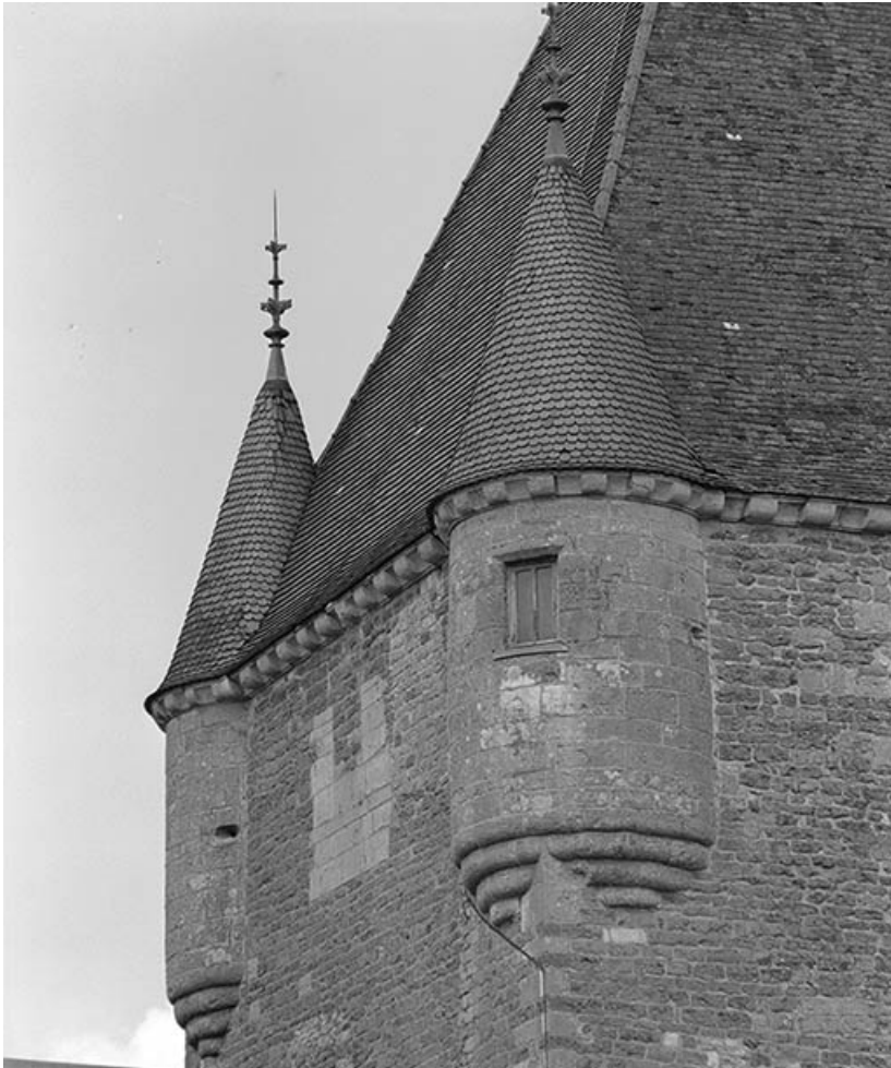
Détail des tourelles en surplomb du donjon.
