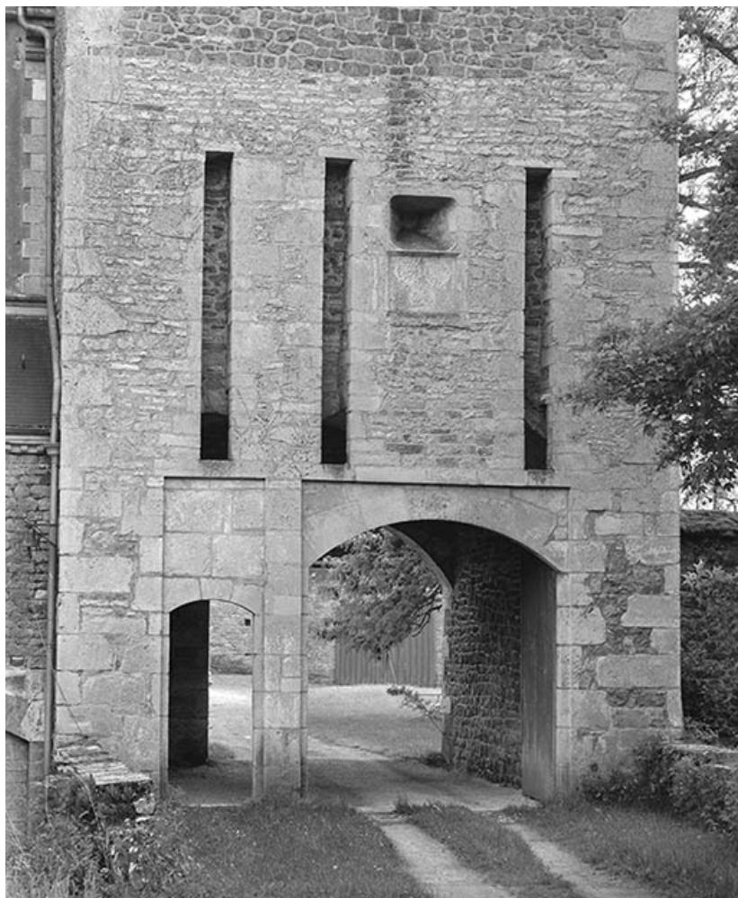
Façade de la tour-porche : détail des portes et des rainures des ponts-levis. 21, Ivry-en-Montagne R.D. 17 d, lieudit : Coraboeuf
