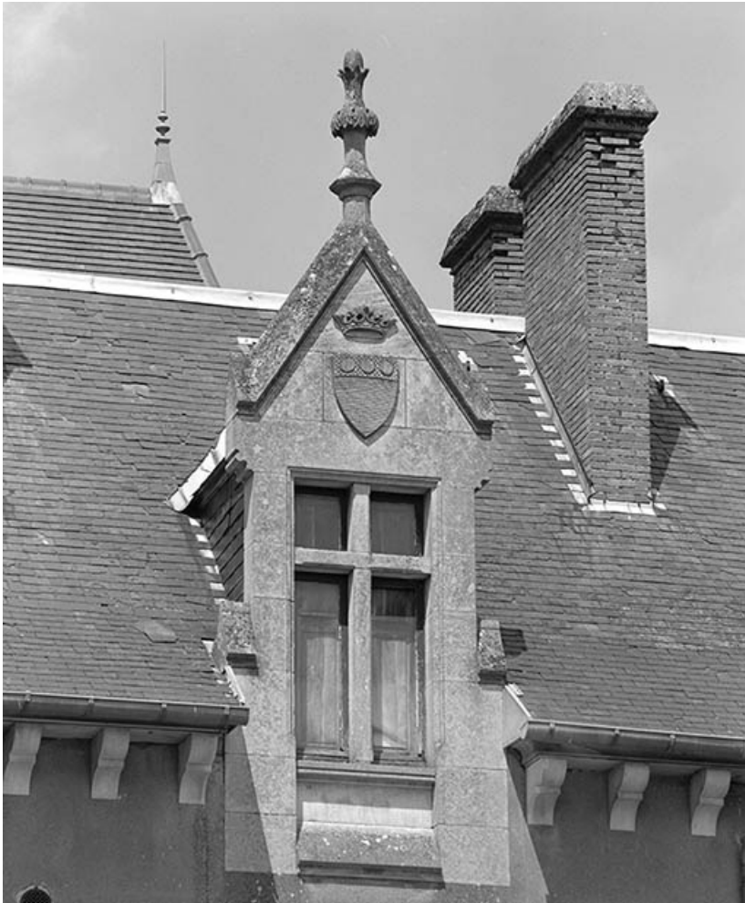
Détail de la lucarne centrale du corps de logis. 21, Ivry-en-Montagne R.D. 17 d, lieudit : Coraboeuf
