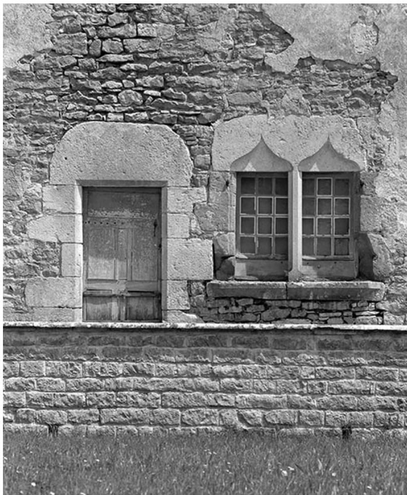
Détail de la porte et des 2 fenêtres situées au centre de la façade antérieure de l'aile est. 21, Ivry-en-Montagne R.D. 17 d, lieudit : Coraboeuf
