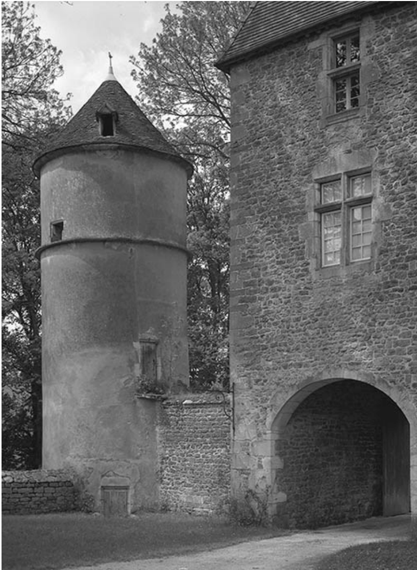
Tour nord-ouest et tour-porche, vue depuis la cour. 21, Ivry-en-Montagne R.D. 17 d, lieudit : Coraboeuf
