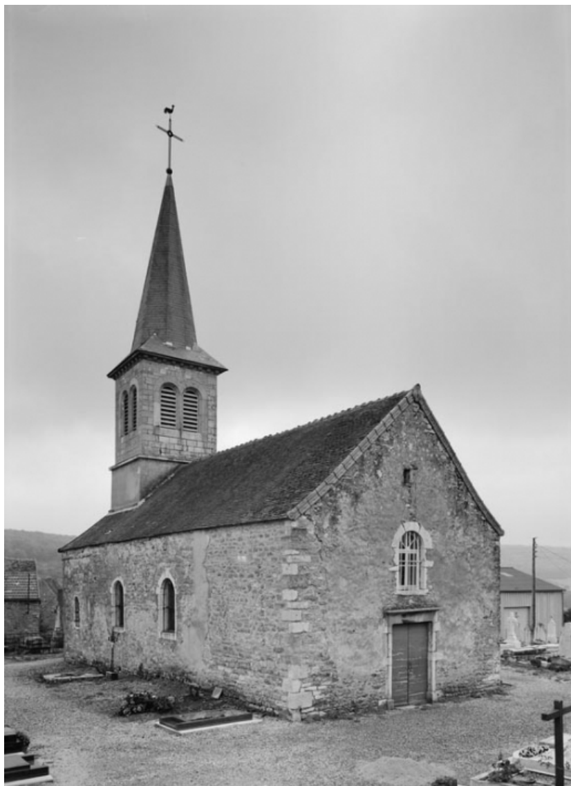
Vue d'ensemble de 3/4 gauche.
