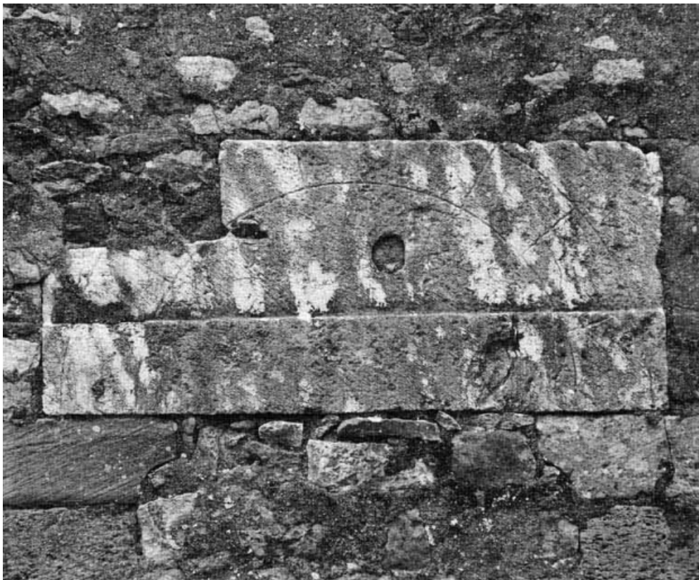
Linteau de la porte murée du mur droit. 21, Ivry-en-Montagne
