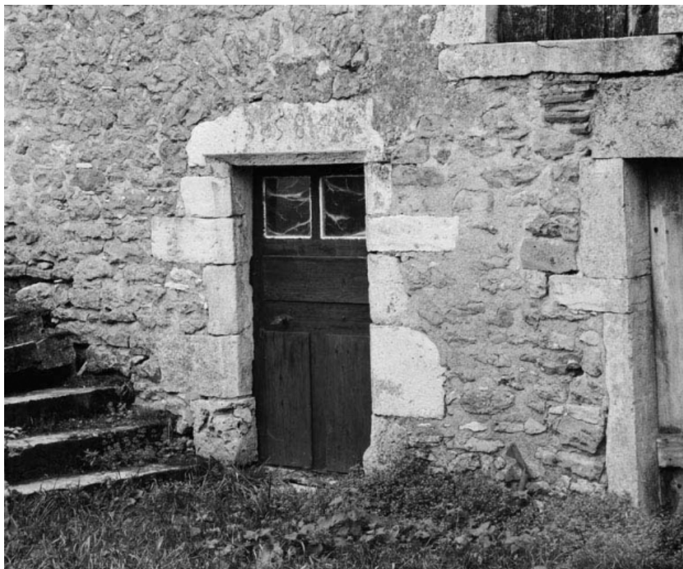
Détail de la porte datée 1584, sur la maison sise parcelle 71, section AB du cadastre de 1955. 21, Ivry-en-Montagne
