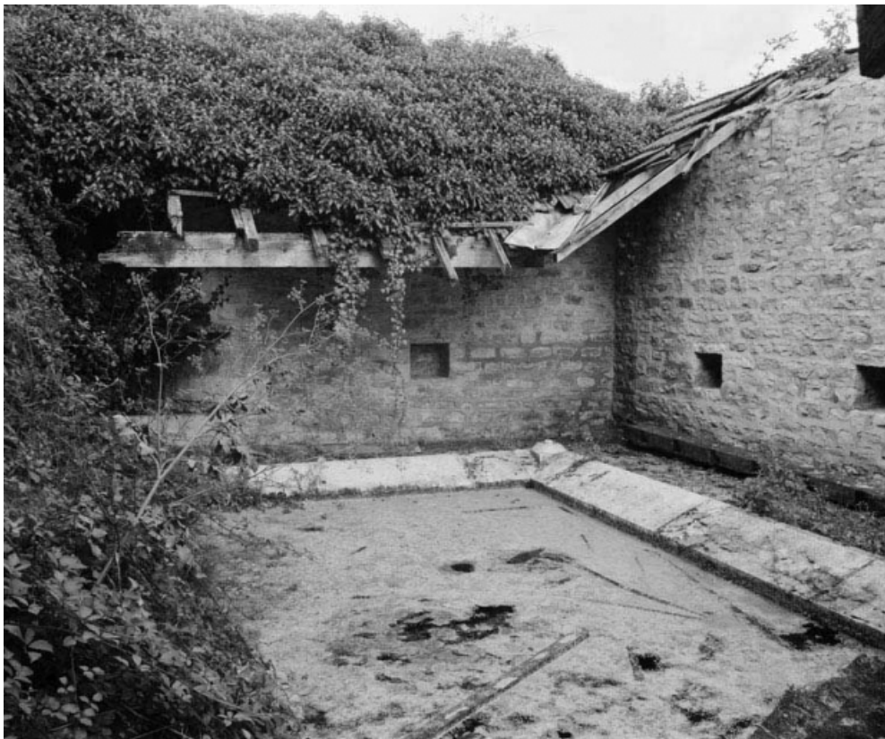
Mur droit et mur antérieur.
