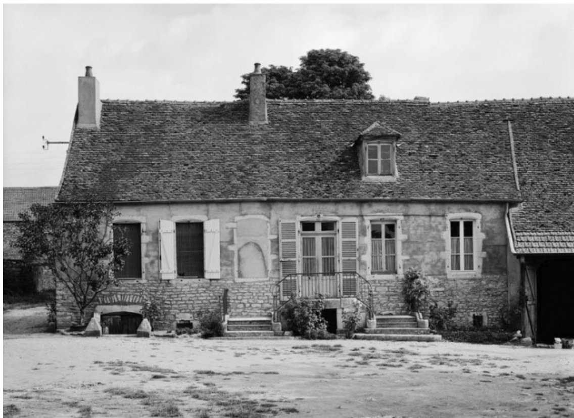
Vue de la façade.
