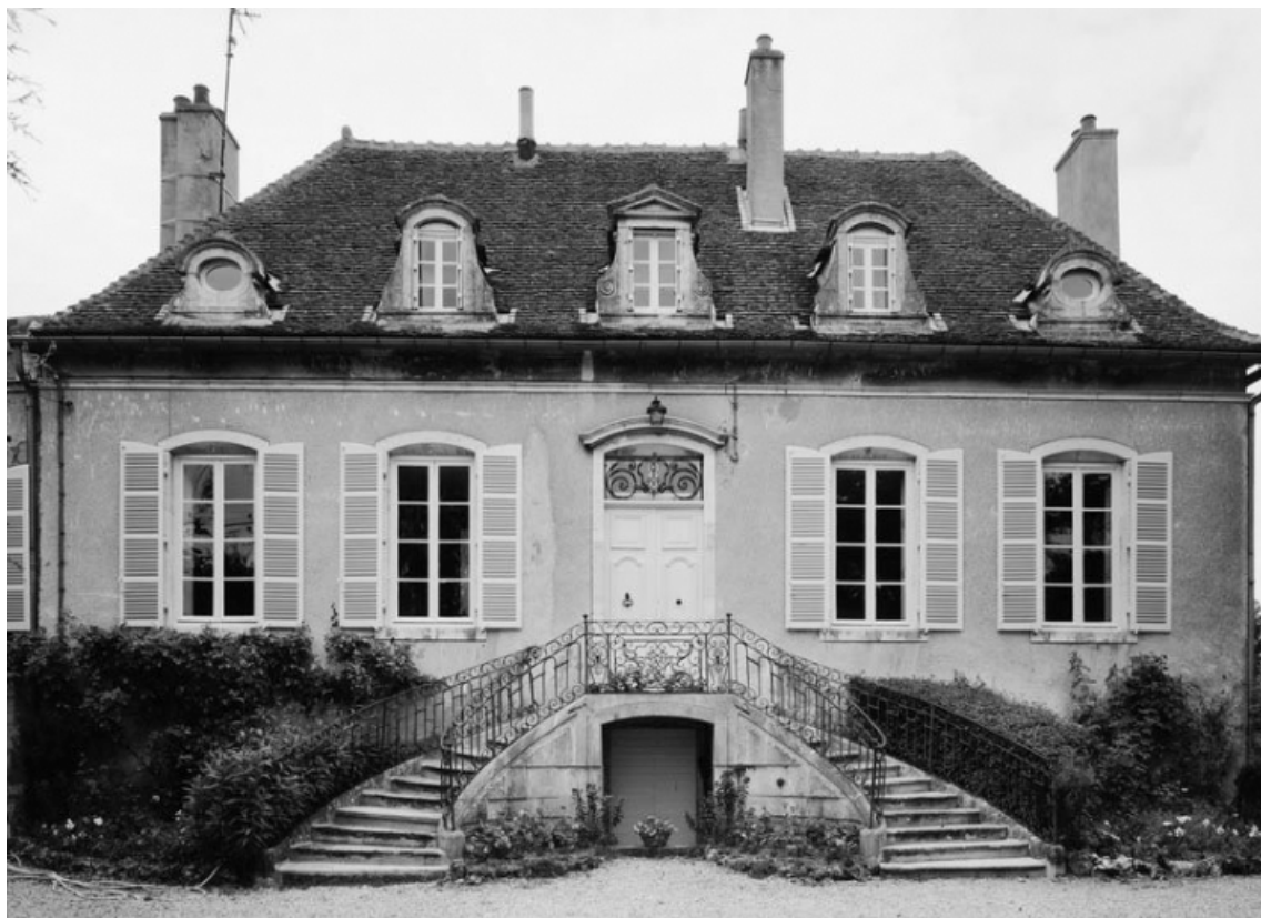
Vue de la façade.
