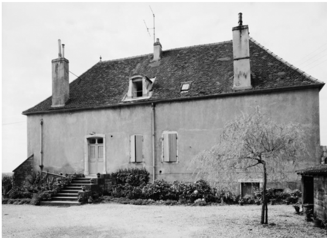
Vue de la façade.
