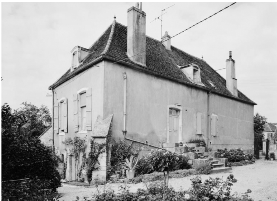
Vue de trois-quarts gauche du bâtiment.
