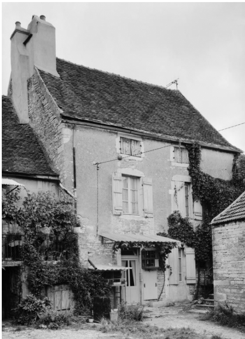
Vue de la maison sise parcelle 398, section A3 sur le cadastre de 1970. 21, Corpeau
