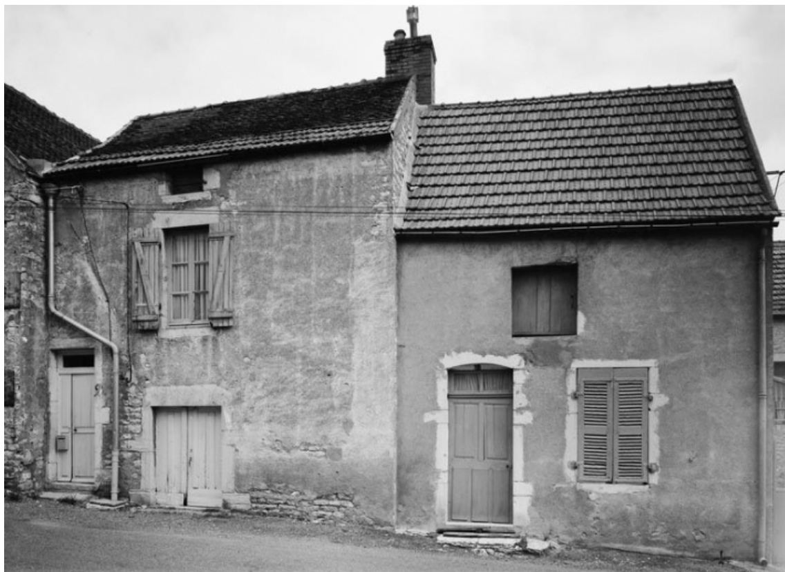
Vue d'ensemble de la maison sise parcelle 383b et 384, section A3 sur le cadastre de 1970. 21, Corpeau
