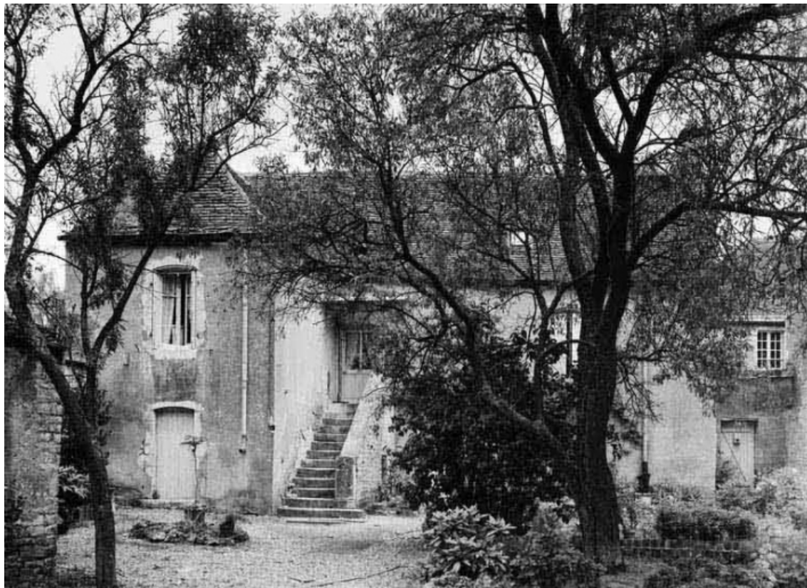
Vue d'ensemble de la maison sise parcelle 386, section A3 sur le cadastre de 1970. 21, Corpeau
