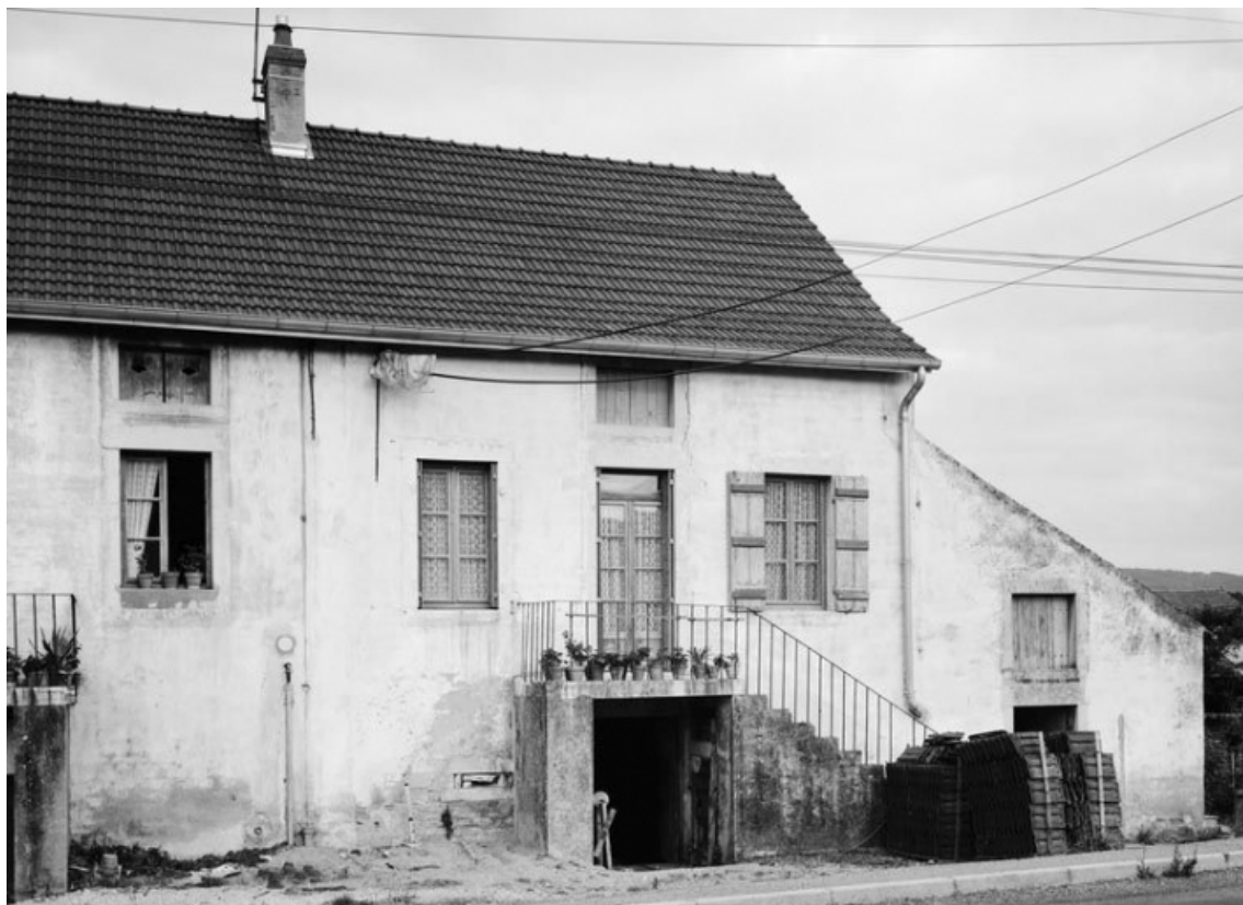
Vue d'ensemble de la maison sise parcelle 255, section D1 sur le cadastre de 1970. 21, Corpeau
