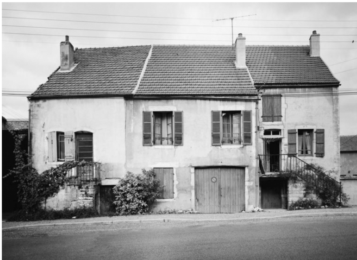
Vue d'ensemble de la maison sise parcelles 366 et 367, section D2 sur le cadastre de 1970. 21, Corpeau
