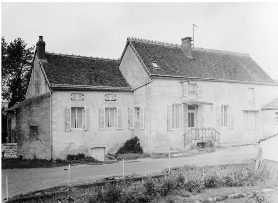
Vue d'ensemble de la maison sise parcelle 389, section A3 sur le cadastre de 1970. 21, Corpeau
