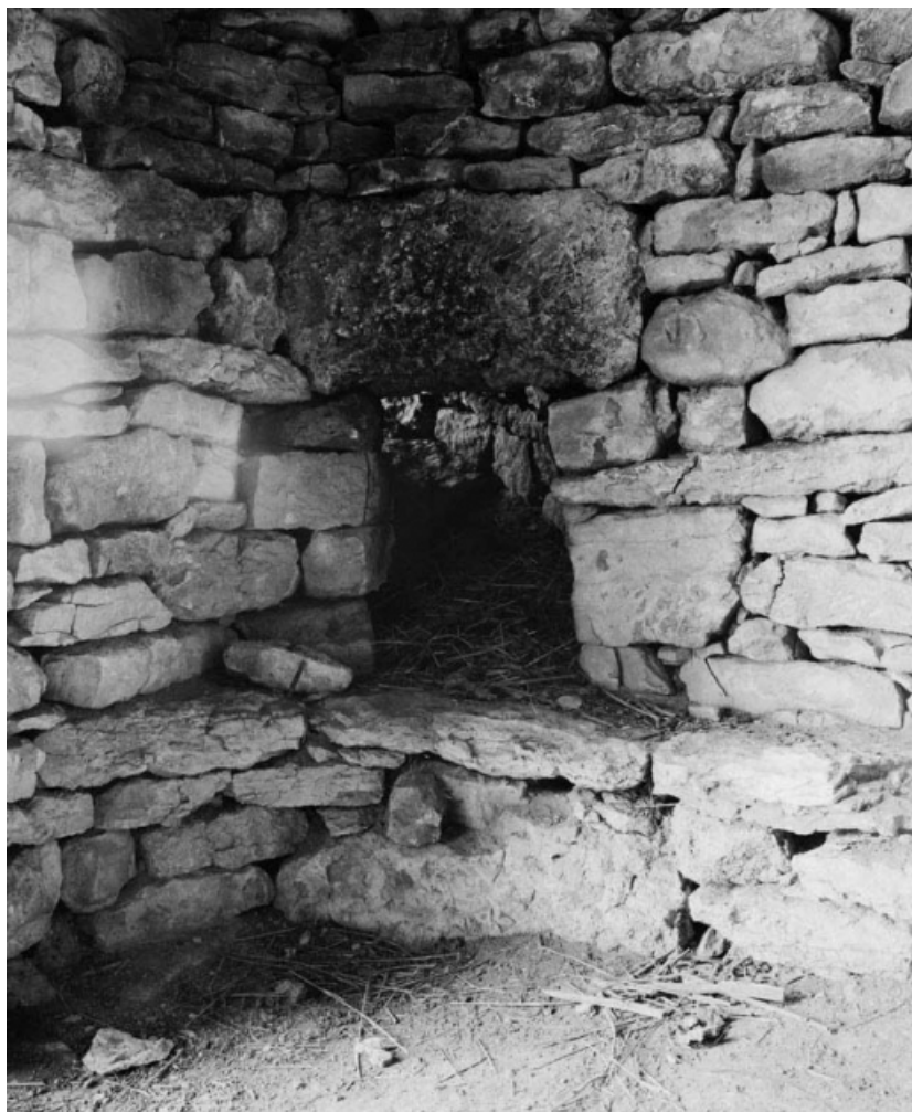
Vue de l'intérieur: détail du conduit de cheminée.
