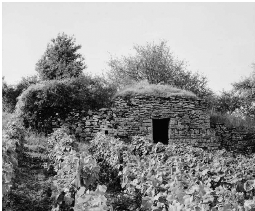
Vue d'ensemble de la cabane et du mur de soutènement.
