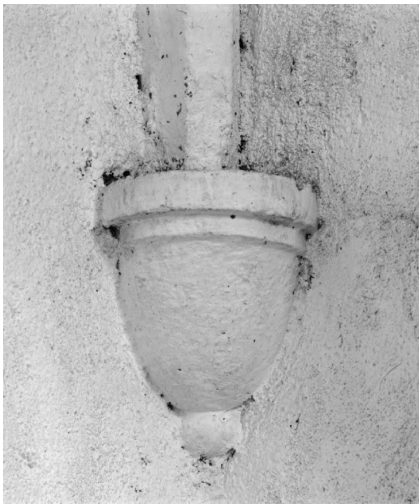
Détail du culot postérieur gauche de la 2ème travée.
