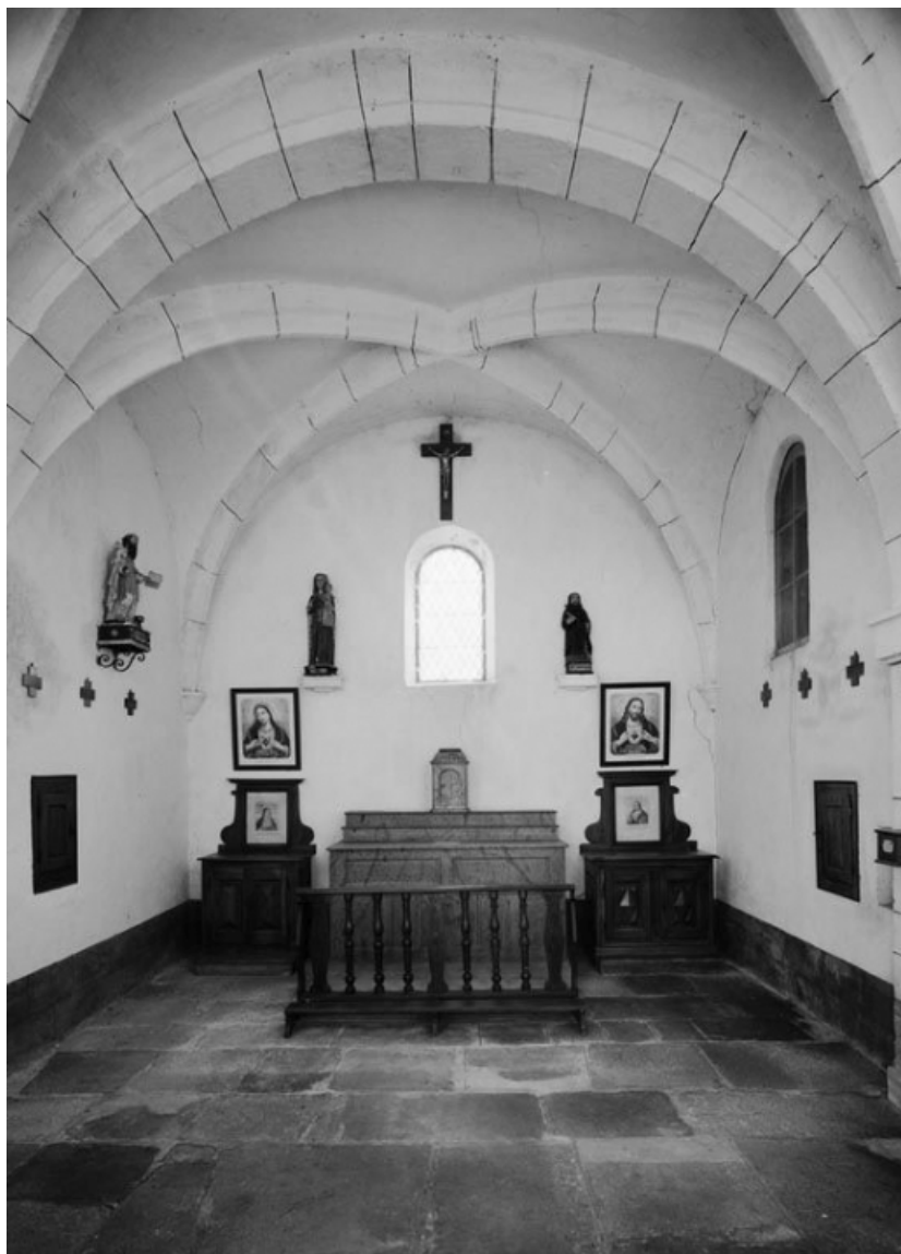
Vue de l'intérieur, depuis l'entrée.
