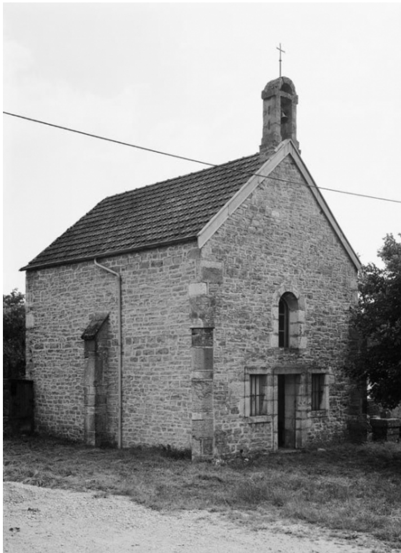
Vue de la façade et du mur gauche.
