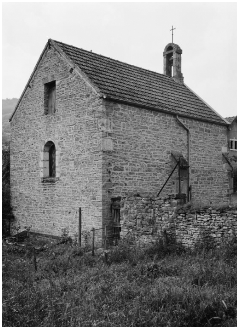
Vue du chevet du mur gauche.
