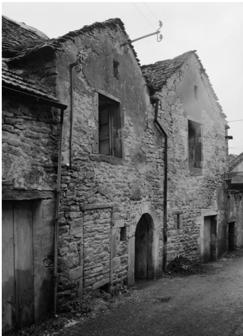
Vue d'ensemble des maisons sises parcelles 389 et 390, section C2 du cadastre de 1948. 21, Cormot-le-Grand
