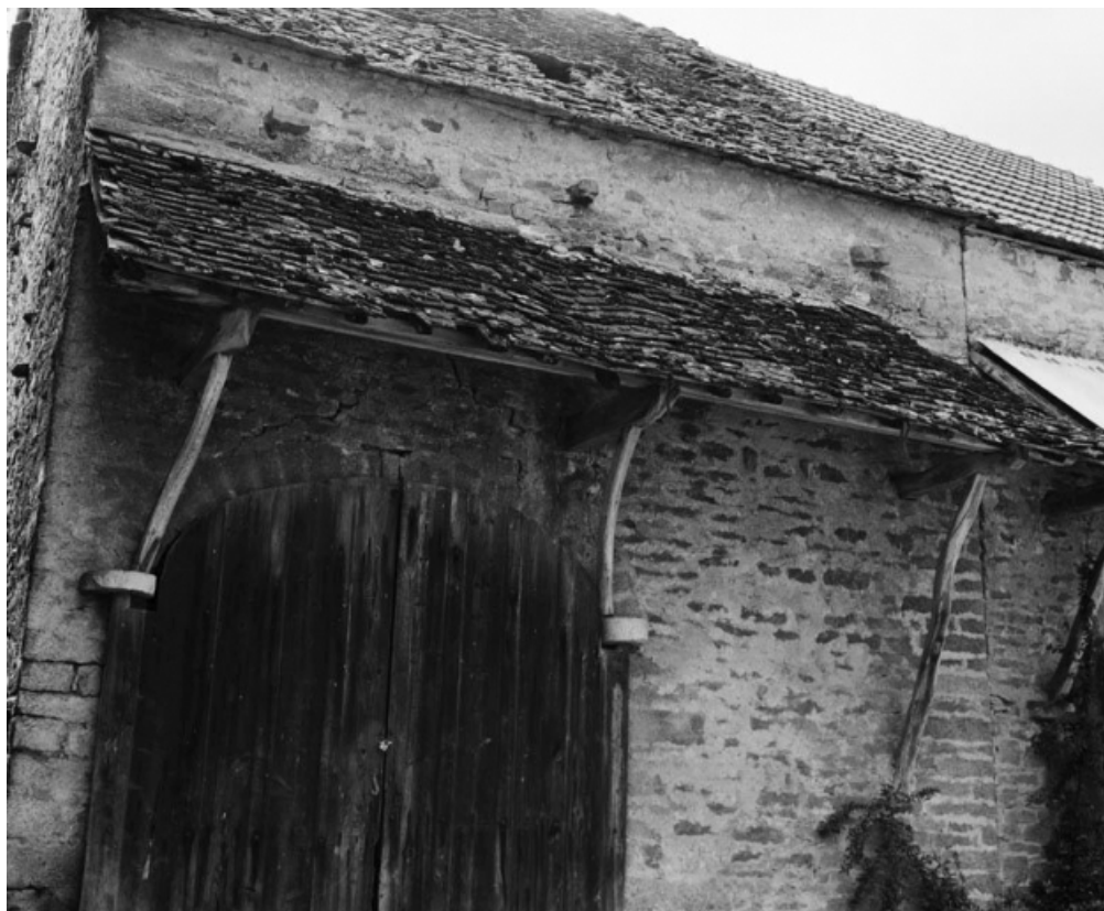
Détail du auvent de la maison sise parcelle 421, section C2 du cadastre de 1948. 21, Cormot-le-Grand
