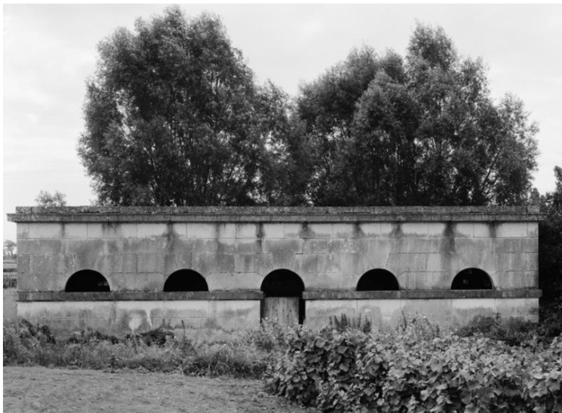
Vue de la façade antérieure du lavoir.
