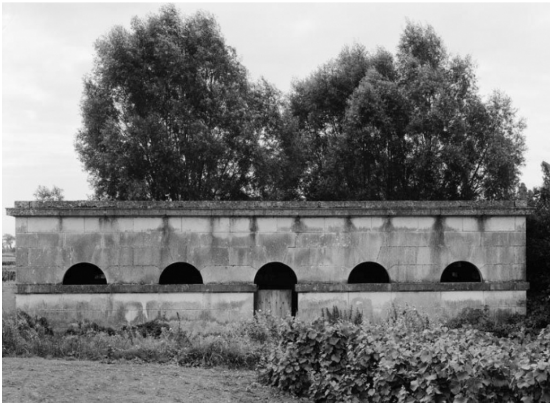
Vue de la façade antérieure du lavoir.
