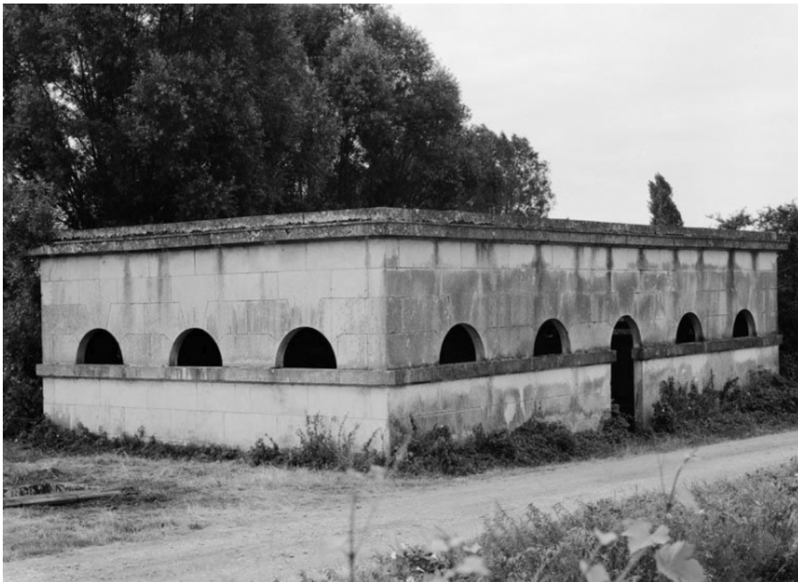
Vue d'ensemble, de trois-quarts gauche. 21, Chassagne-Montrachet à l'est du village
