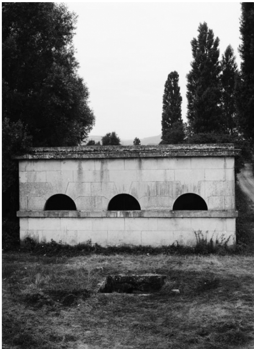
Élévation gauche du lavoir. Au premier plan, le bassin de la fontaine. 21, Chassagne-Montrachet à l'est du village
