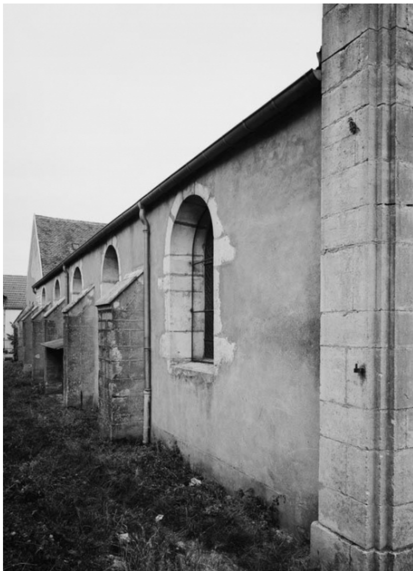
Vue de l'élévation gauche. 21, Chassagne-Montrachet
