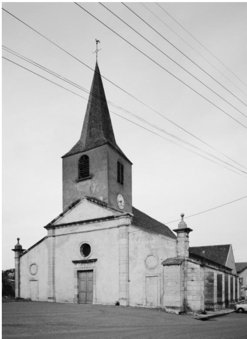
Vue d'ensemble de trois-quarts droit. 21, Chassagne-Montrachet
