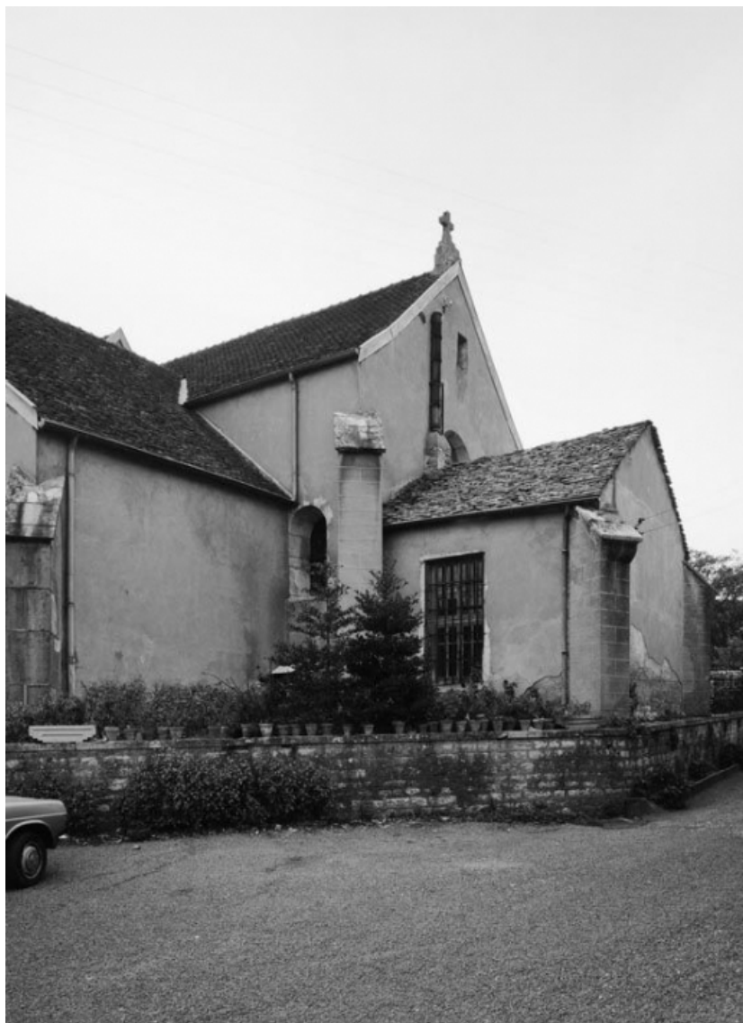
Vue du chœur et de la sacristie.
