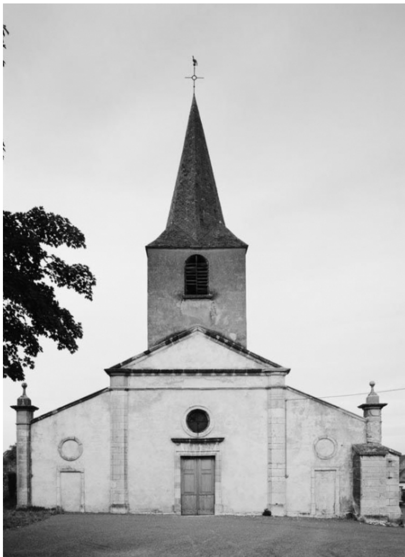
Vue d'ensemble de la façade.
