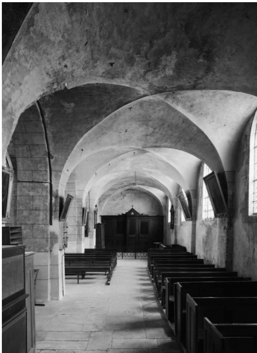
Vue du bas-côté gauche, depuis la chapelle. 21, Chassagne-Montrachet
