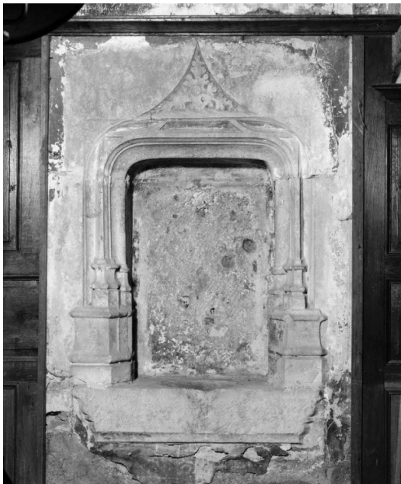
Lavabo de la chapelle latérale droite.
