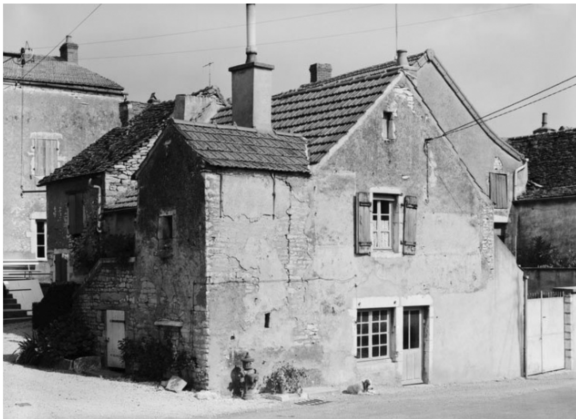
Vue d'ensemble de la maison sise parcelle 253, section AK (cadastre de 1966). 21, Chassagne-Montrachet
