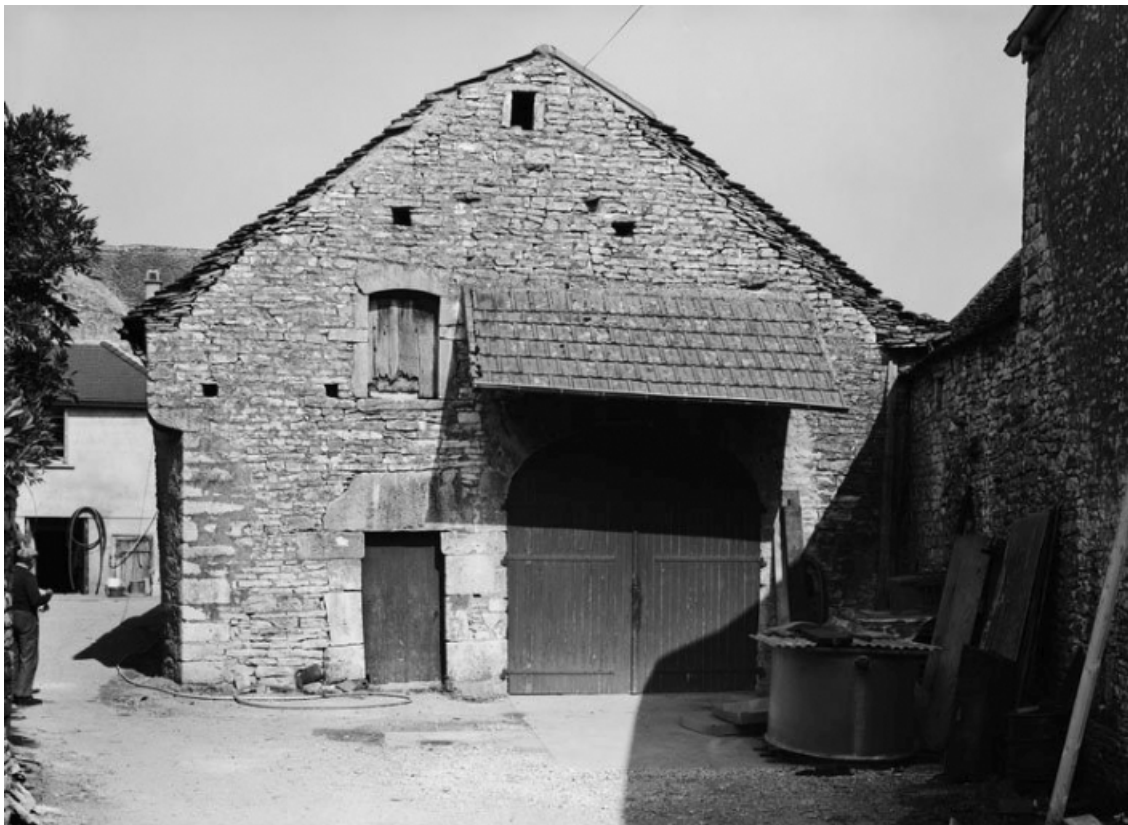
Vue du mur-pignon de la maison (ancienne cuverie) sise parcelle 237, section AK (cadastre de 1966). 21, Chassagne-Montrachet
