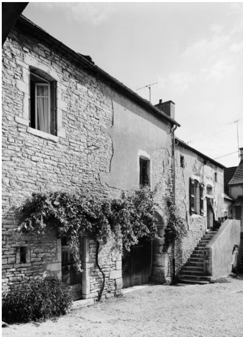
Vue d'ensemble de la maison sise parcelle 107, section AK (cadastre de 1966). 21, Chassagne-Montrachet
