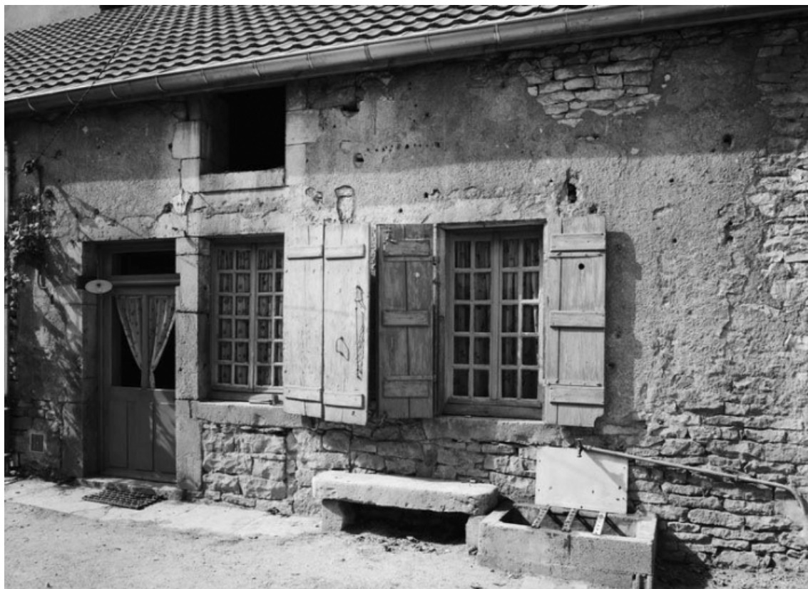
Vue d'ensemble de la maison sise parcelle 205, section AK (cadastre de 1966). 21, Chassagne-Montrachet
