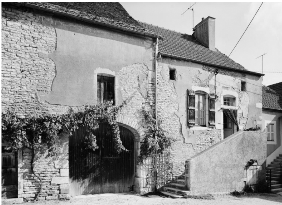
Vue d'ensemble de la maison sise parcelle 107, section AK (cadastre de 1966). 21, Chassagne-Montrachet
