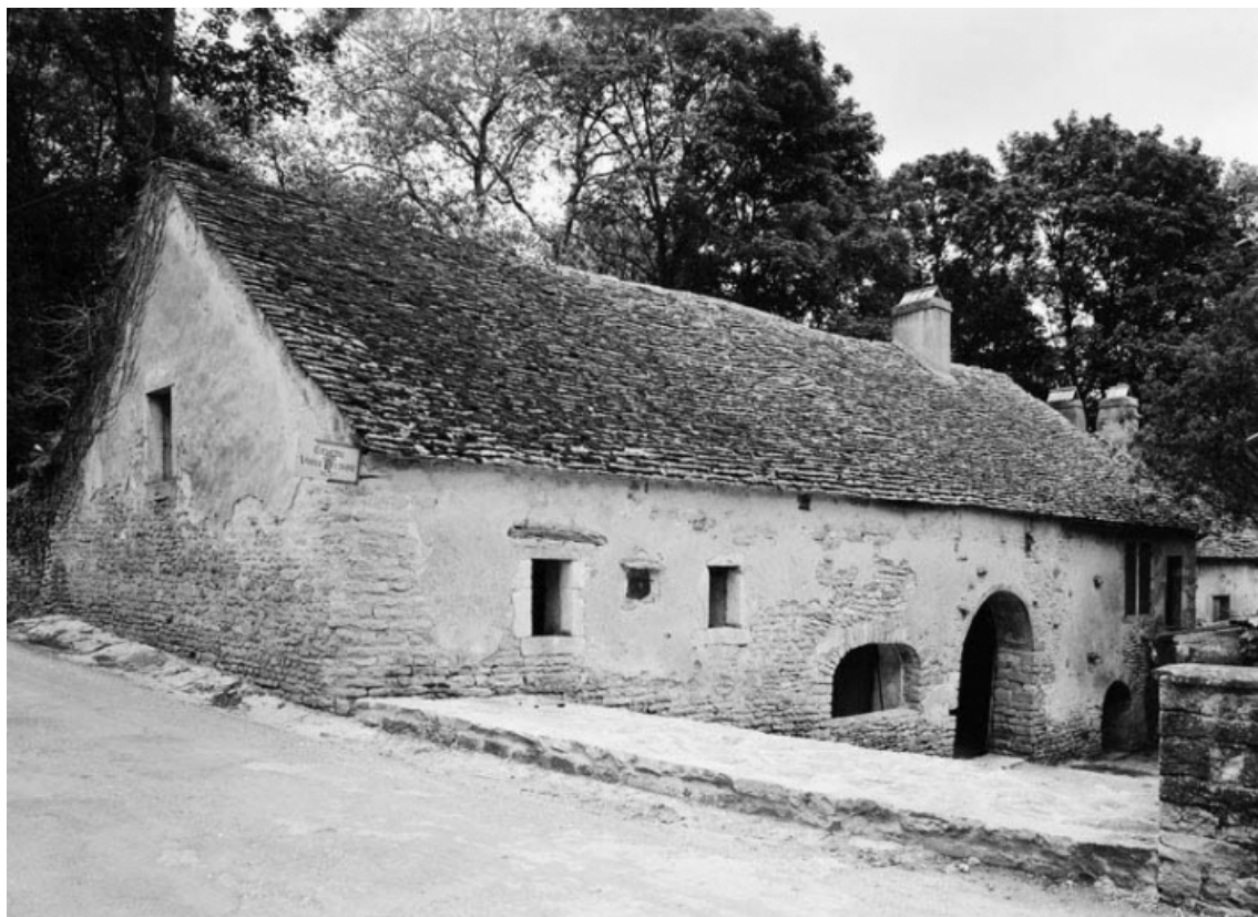
Vue de la cuverie avec pressoir.
