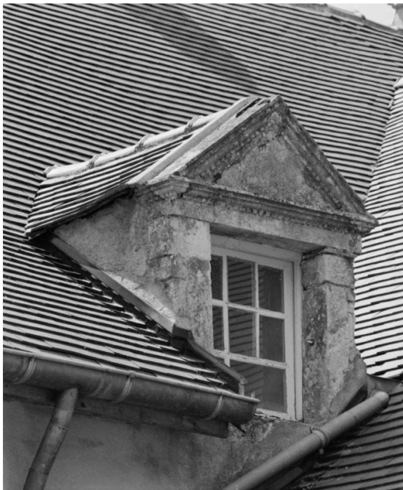
Détail d'une lucarne, côté cour.
