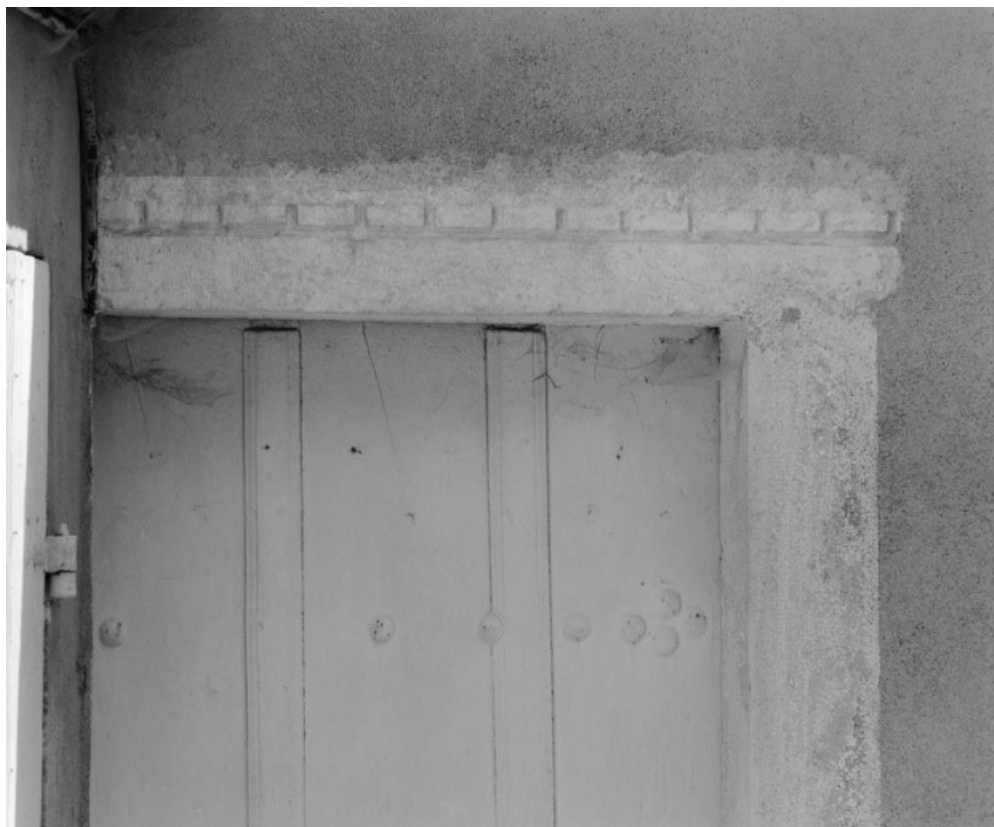
Détail du linteau de la porte des dépendances.
