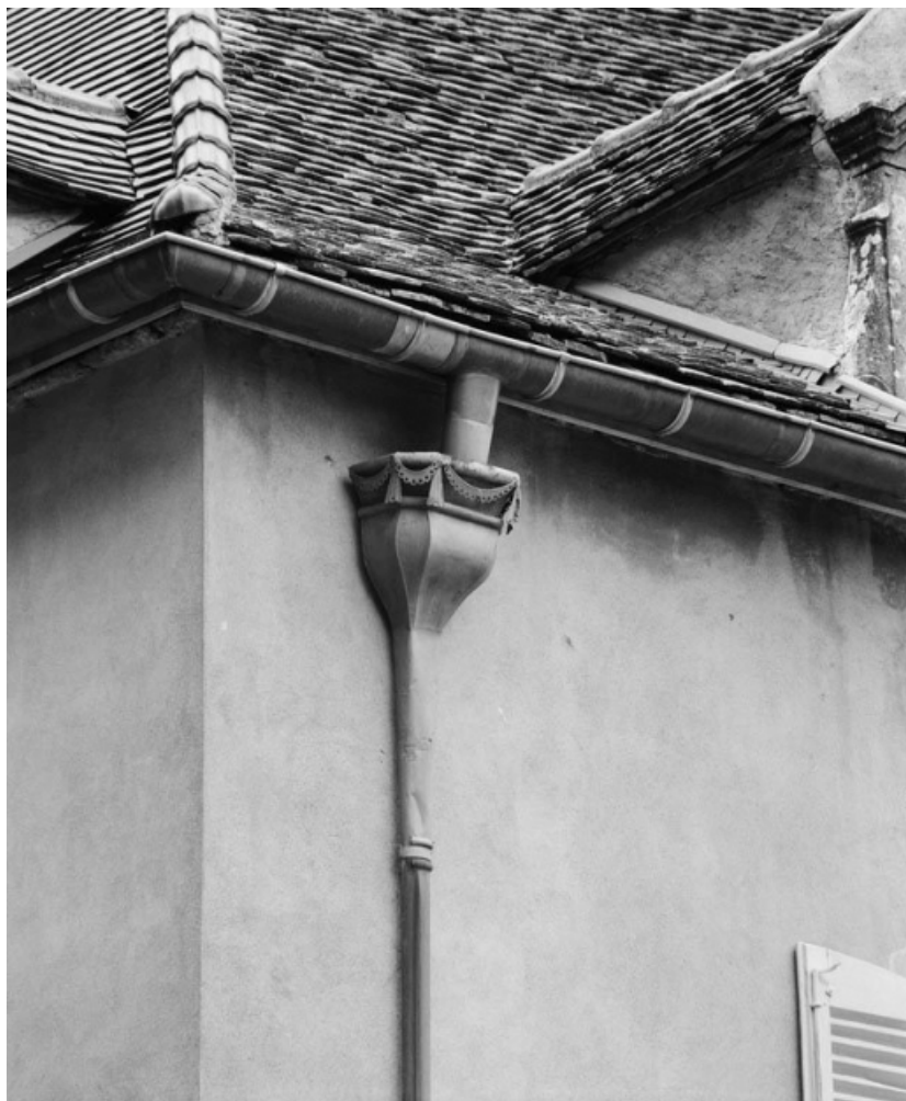
Vue de la cuvette du tuyau de descente de la façade postérieure.
