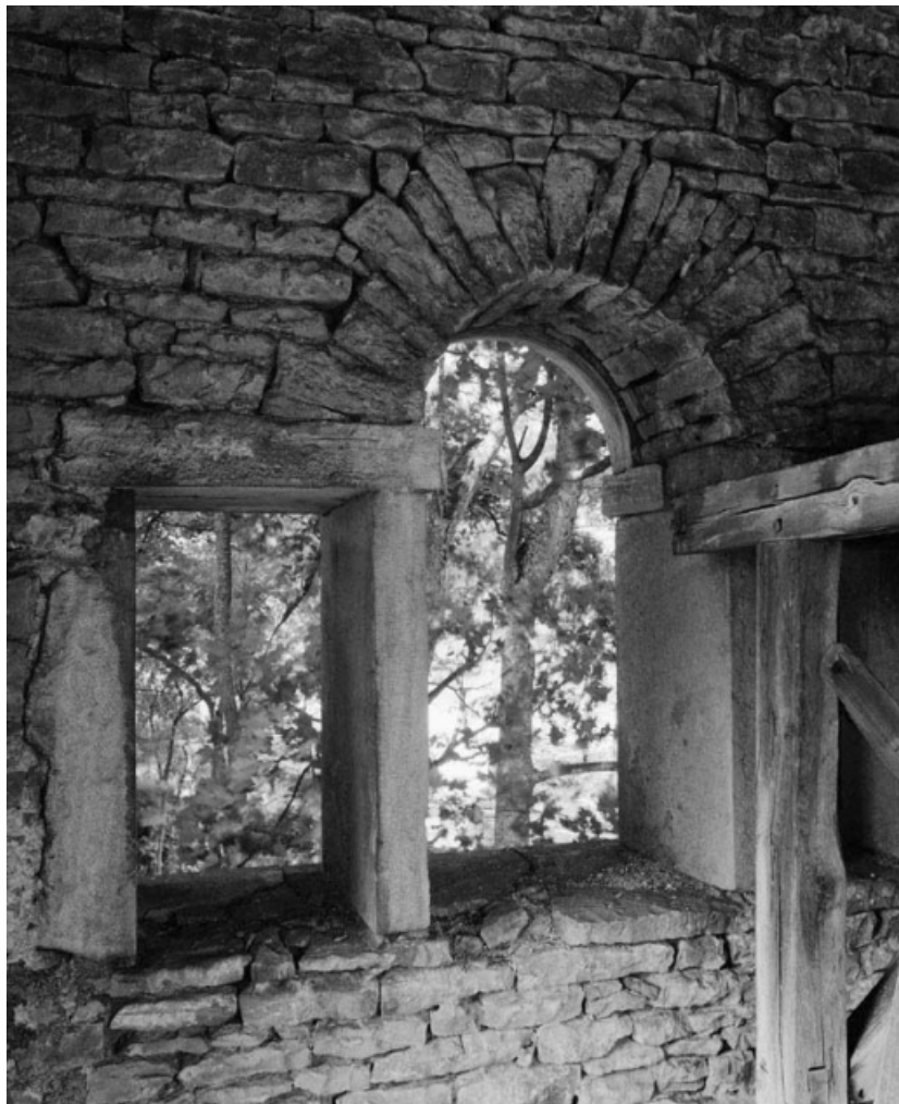
Vue intérieure des baies antérieures du clocher.
