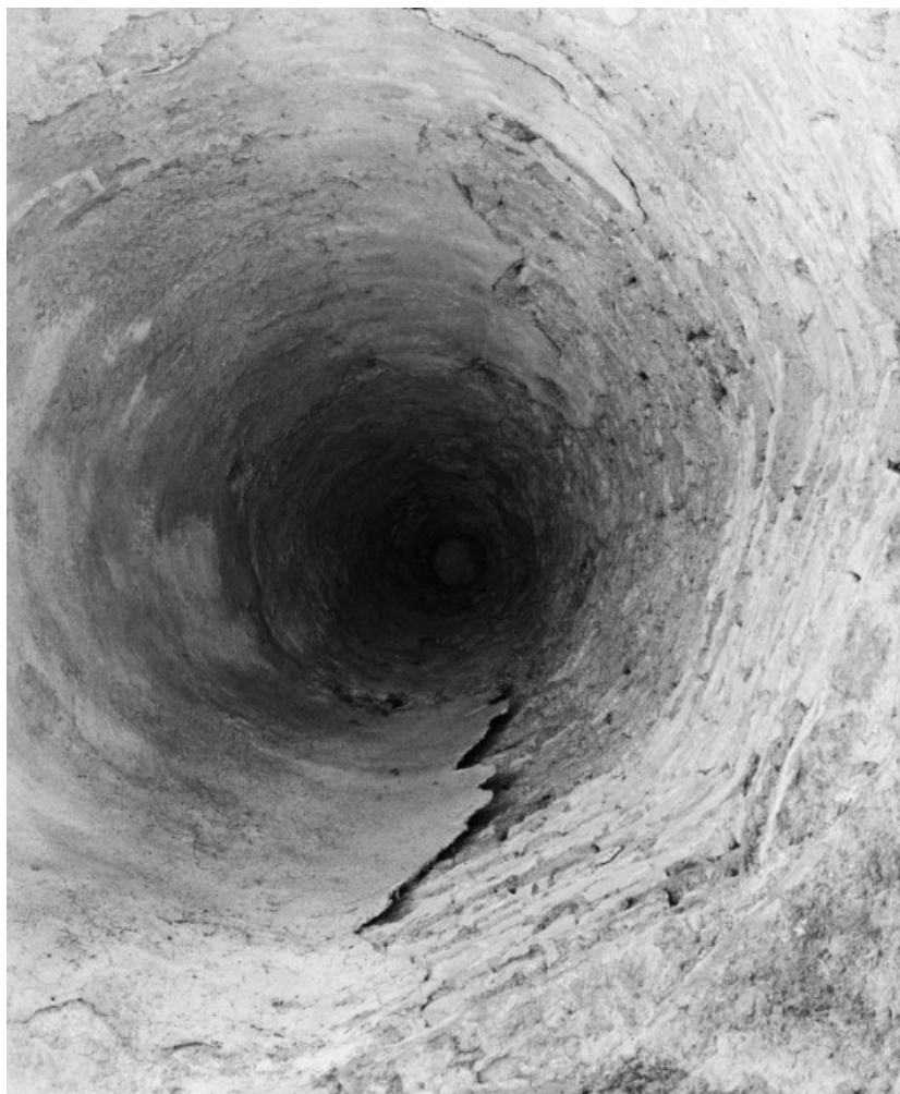
Vue intérieure de la flèche du clocher.
