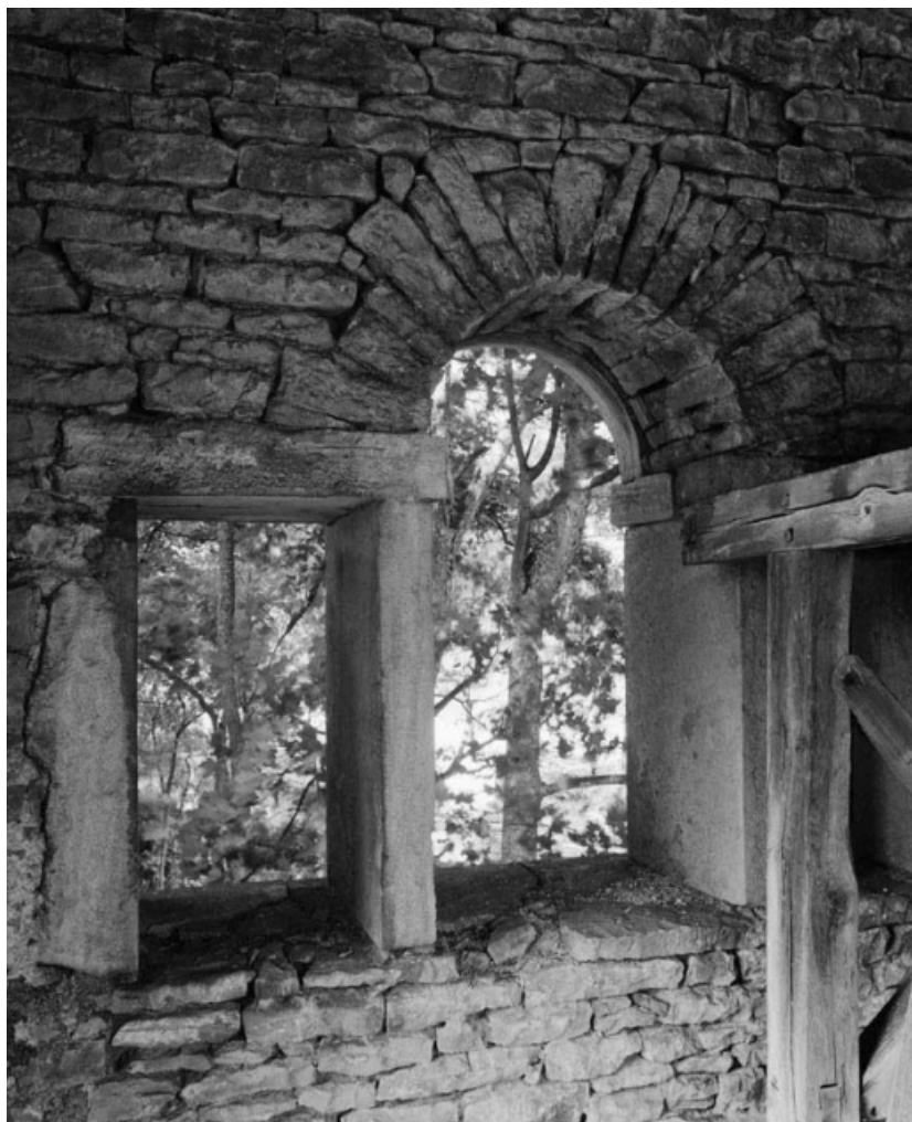
Vue intérieure des baies antérieures du clocher.
