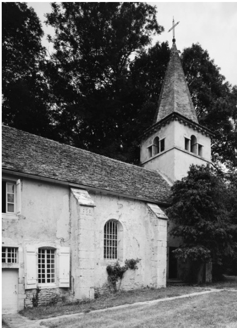
Vue de l'élévation gauche.
