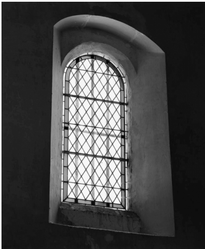
Deuxième fenêtre gauche de la nef. 21, Baubigny
