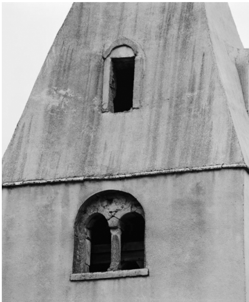
Détail des baies antérieures du clocher.
