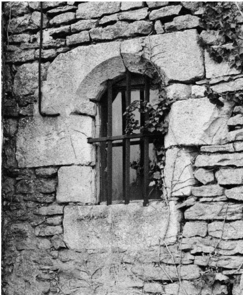
Fenêtre de la sacristie.
