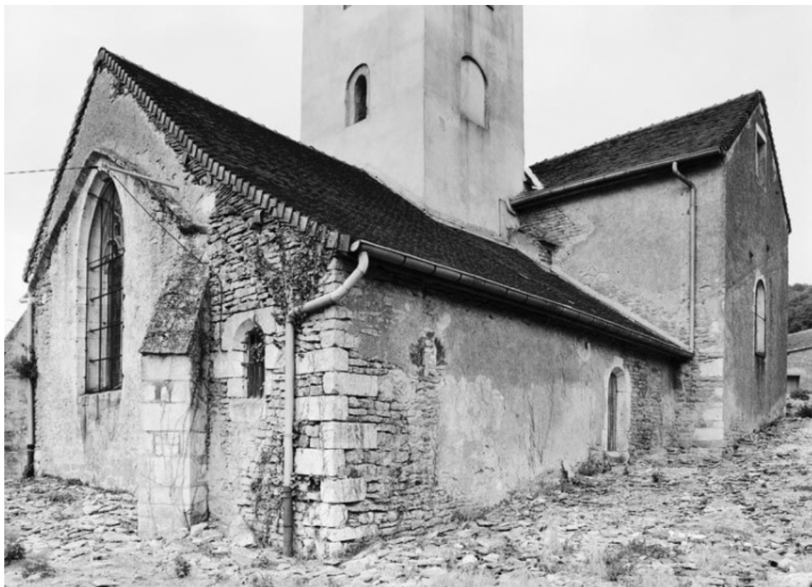
Élévation gauche du choeur et chapelle gauche.
