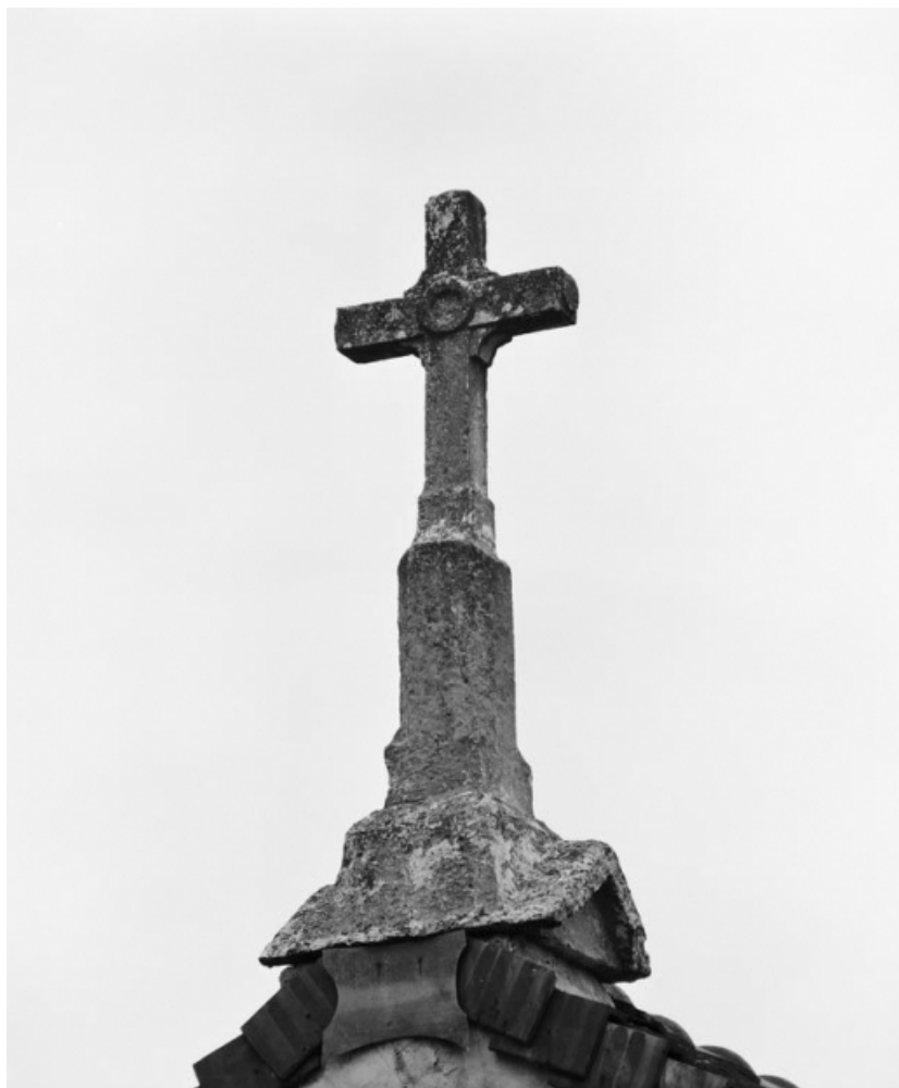
Croix amortissant le pignon du porche.
