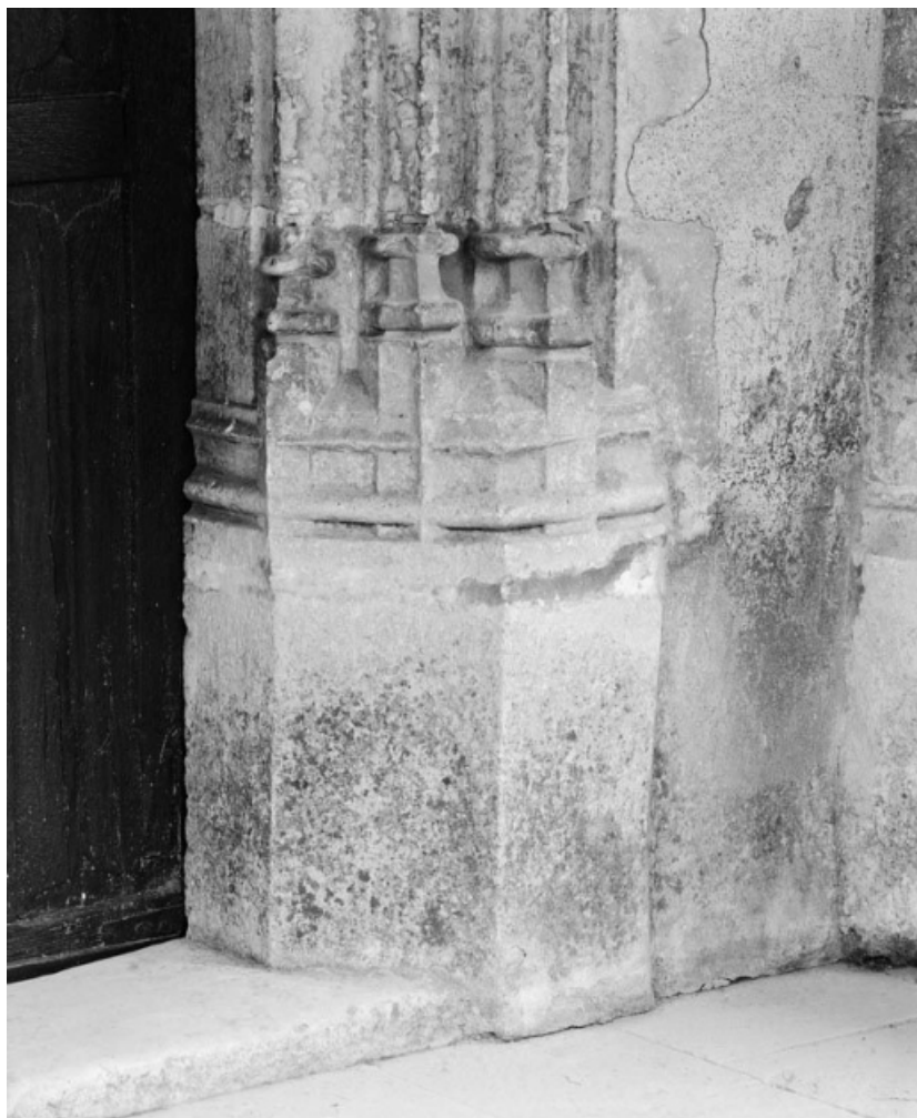
Base d'un piédroit du portail de la nef.
