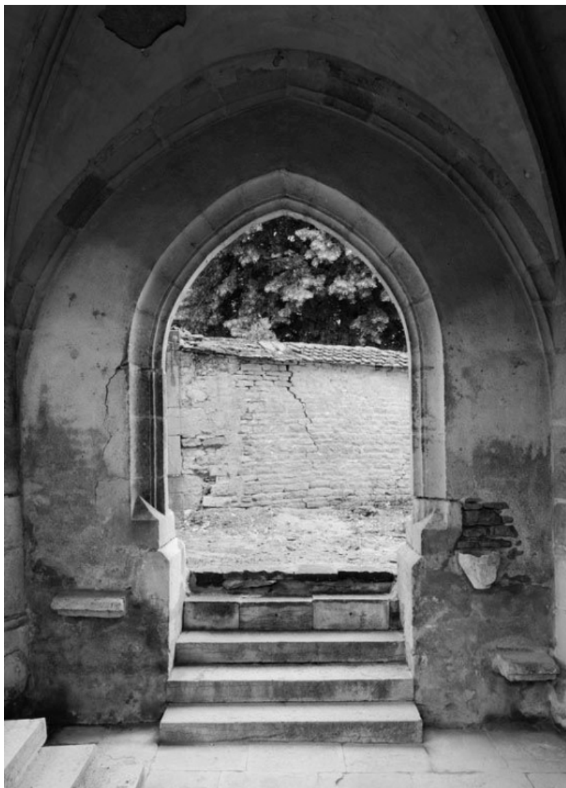
Mur gauche du porche.
