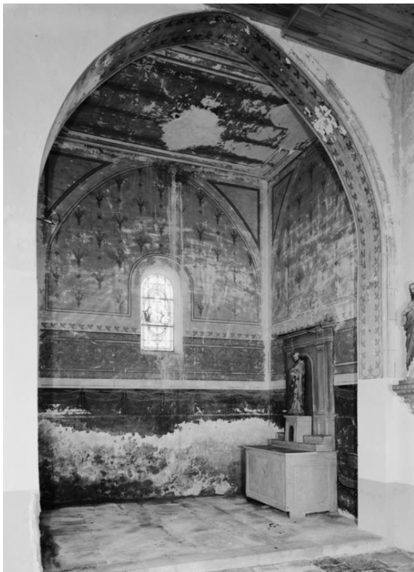
Chapelle gauche (peintures murales). 21, Baubigny
