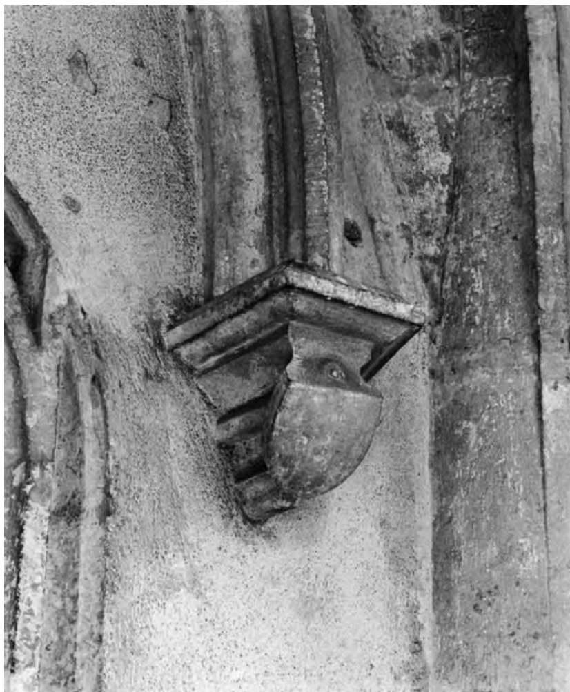
Culot droit de l'archivolte du portail de la nef. 21, Baubigny
