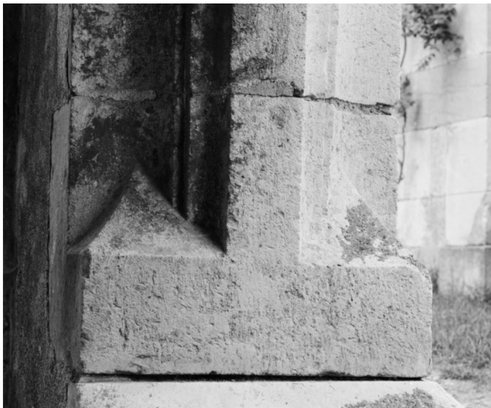
Base d'un piédroit de l'arcade antérieure du porche.
