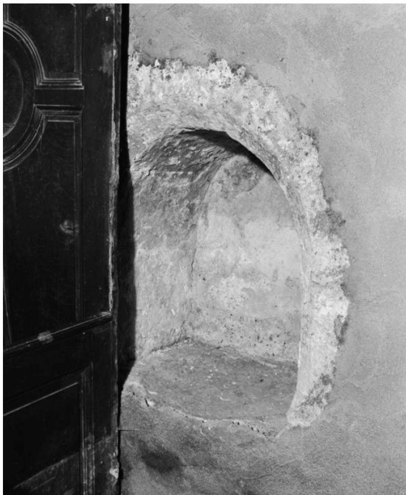
Lavabo du mur droit du choeur.
