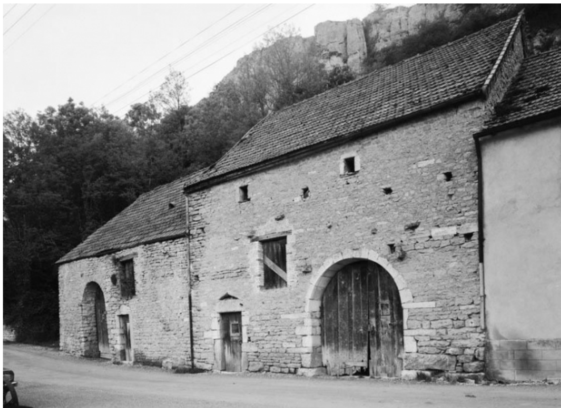
Vue d'ensemble des cuvieries (parcelle 71, section B1 du cadastre de 1953). 21, Baubigny
