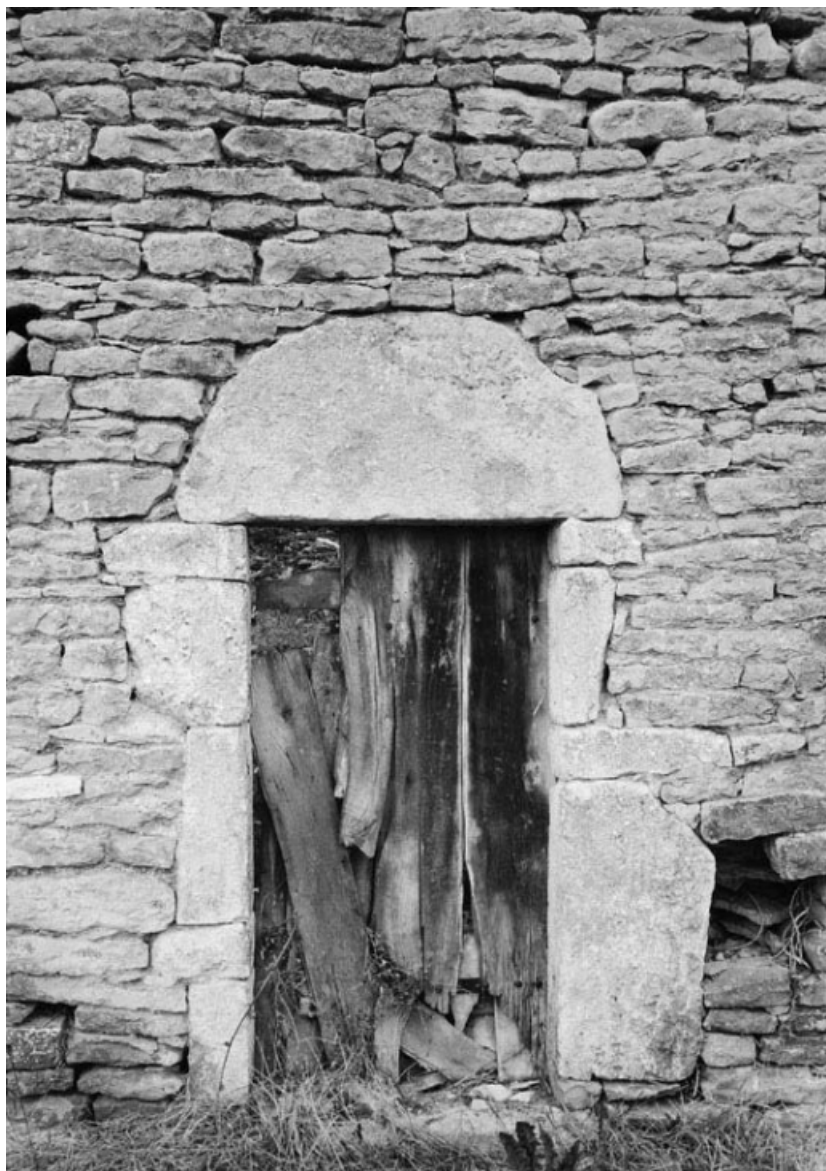
Détail de la porte droite.
