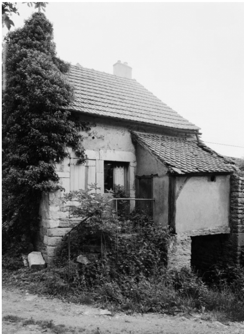
Vue d'ensemble d'une maison (parcelle 410, section D3 du cadastre de 1953). 21, Baubigny
