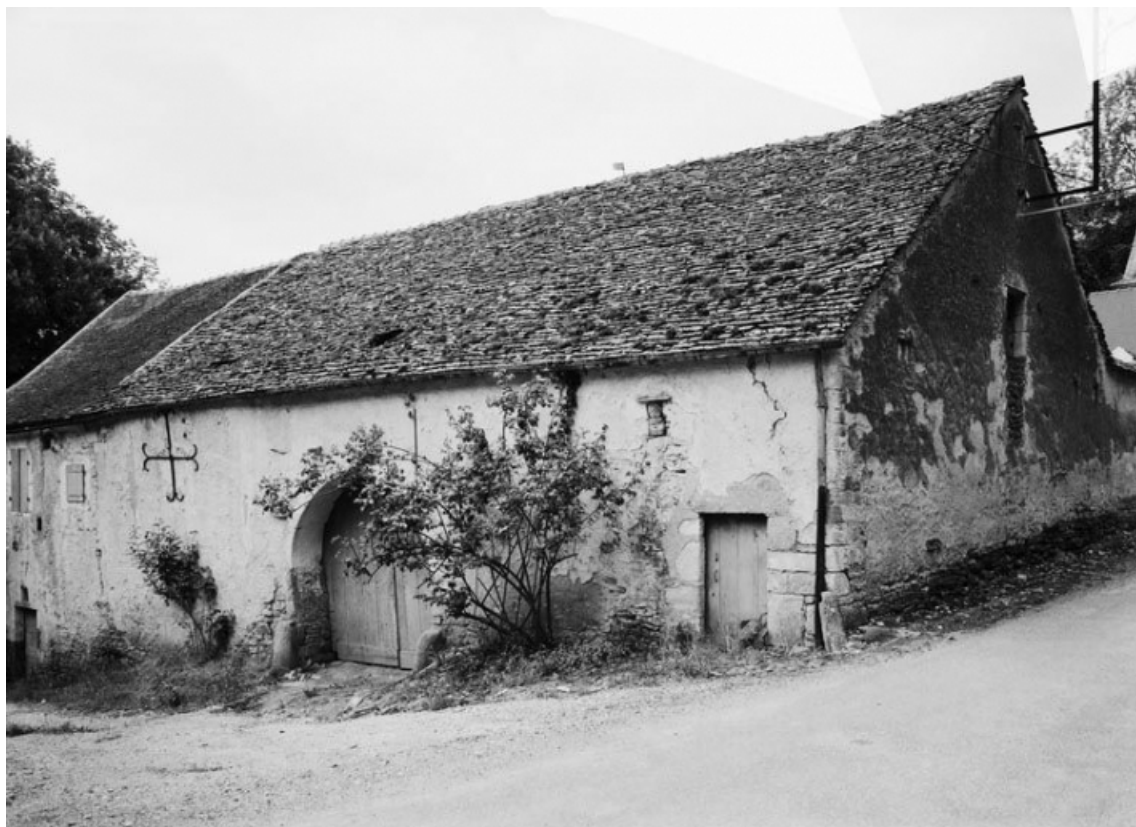
Vue d'ensemble d'une cuverie (parcelle 1163, section C5 sur le cadastre de 1953). 21, Baubigny
