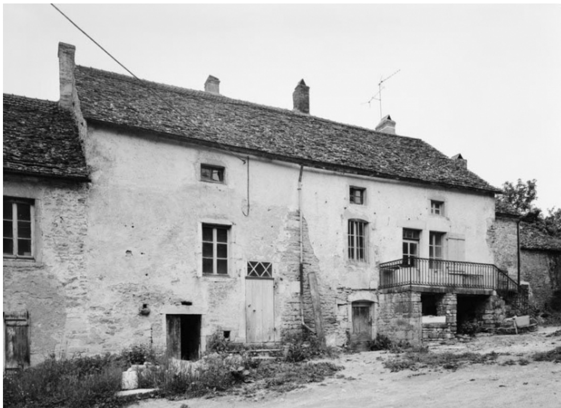
Vue d'ensemble d'une maison (parcelle 1127 a et b, section C5 du cadastre de 1953). 21, Baubigny
