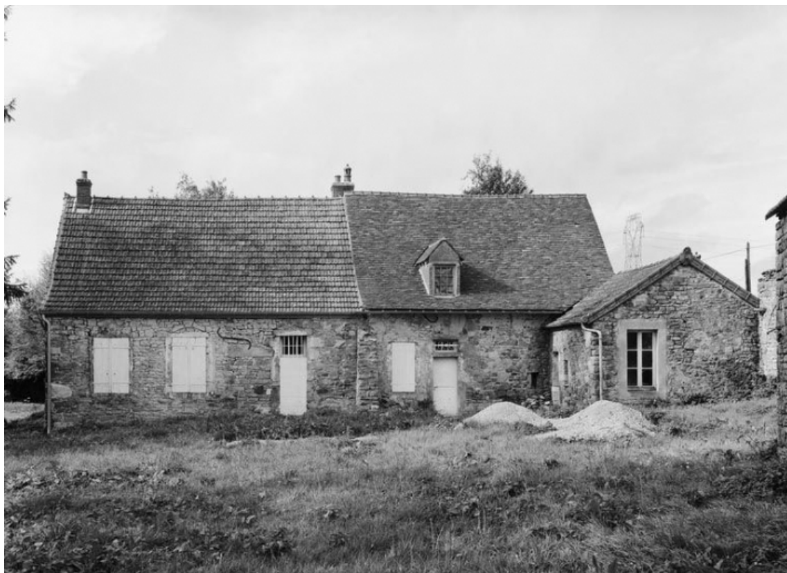
Vue d'ensemble, façade antérieure.
