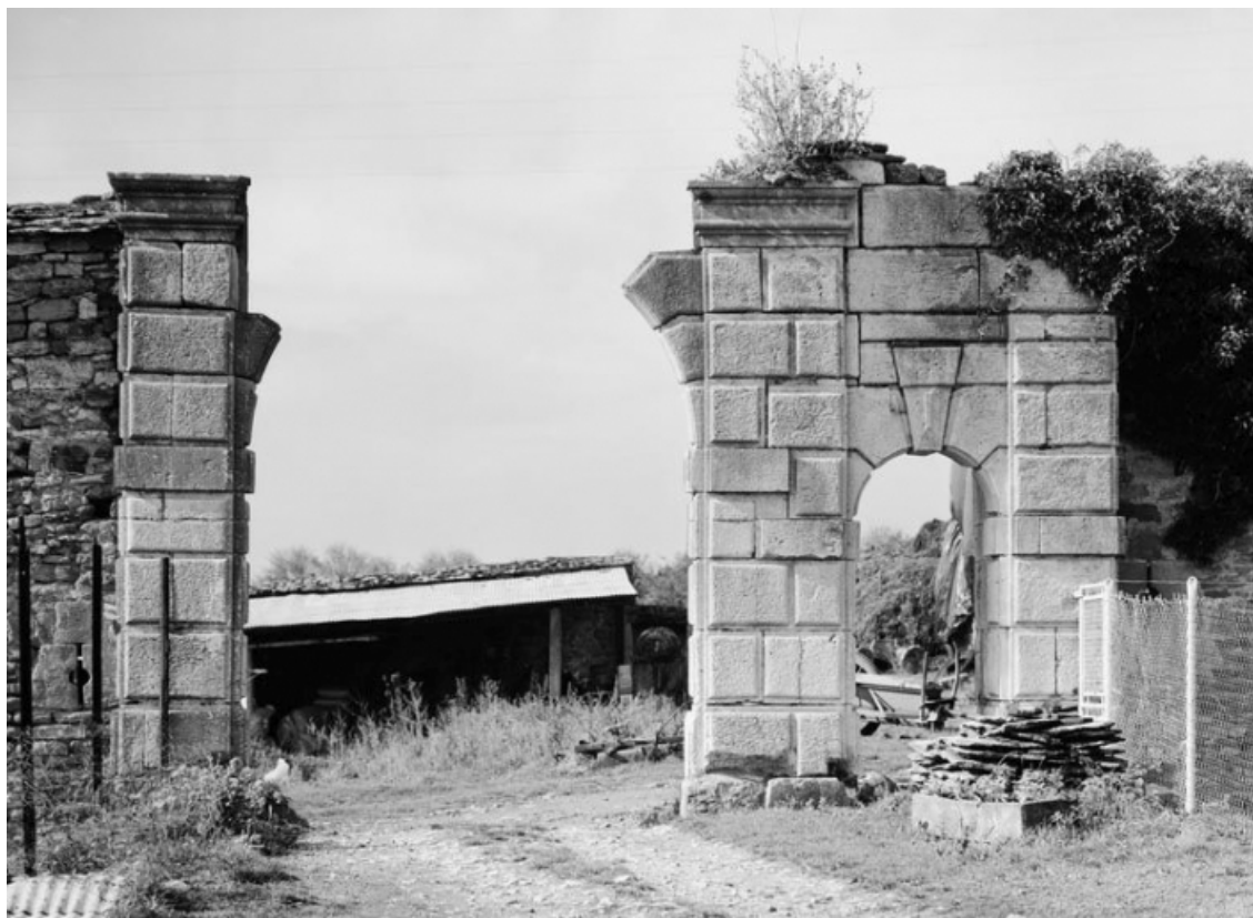
Portail : vue de la porte charretière et de la porte piétonne.
