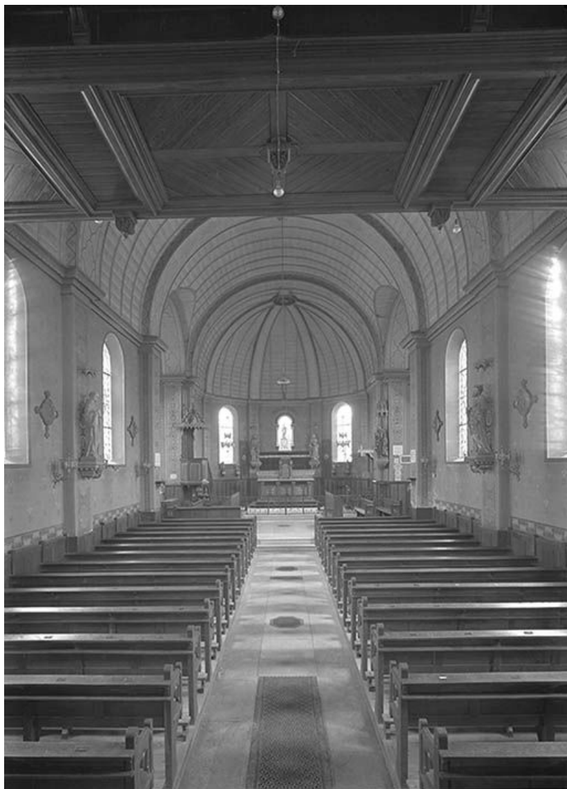
Vue sur la nef et le chœur depuis l'entrée.
