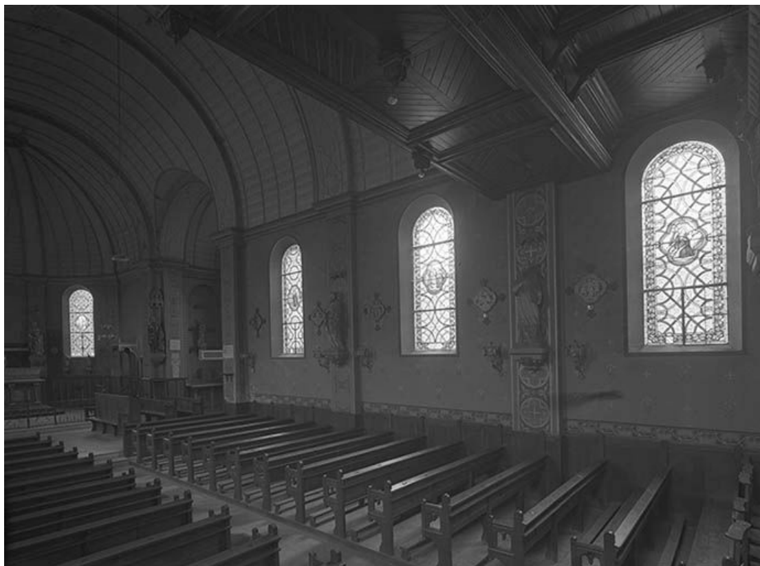
Vue sur le mur Sud.
