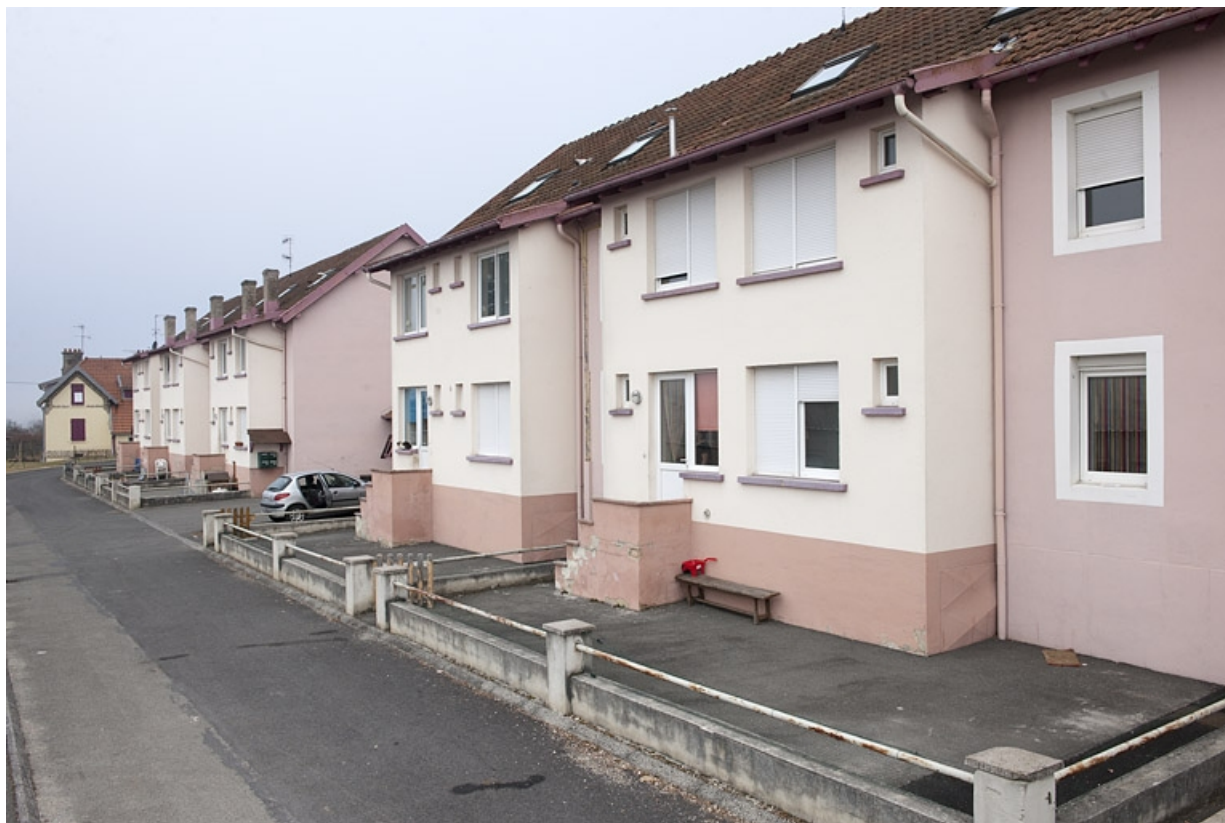
Immeubles d'habitation vus depuis l'est. 25, Fesches-le-Châtel route de Méziré
