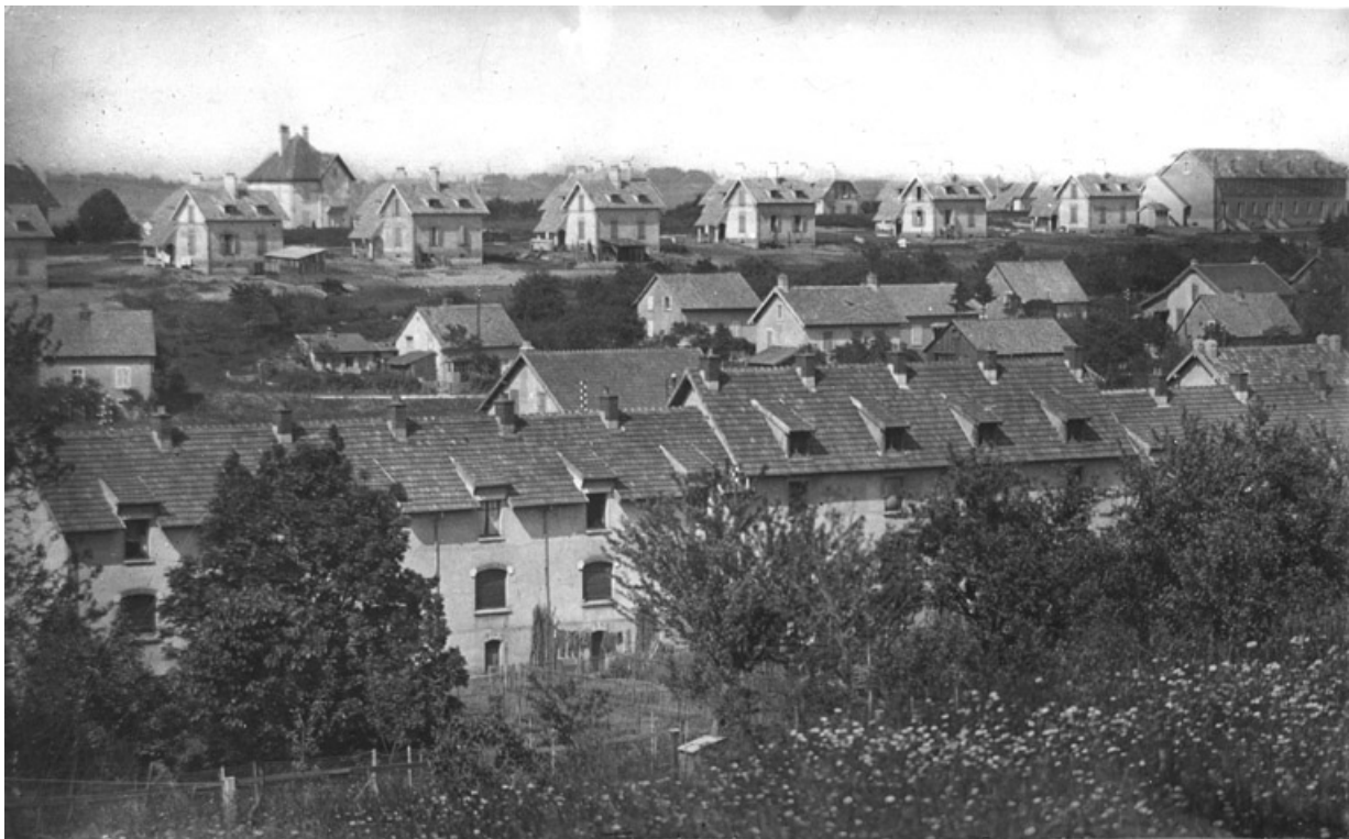
Vue d'ensemble depuis le sud-ouest. 25, Fesches-le-Châtel route de Méziré
