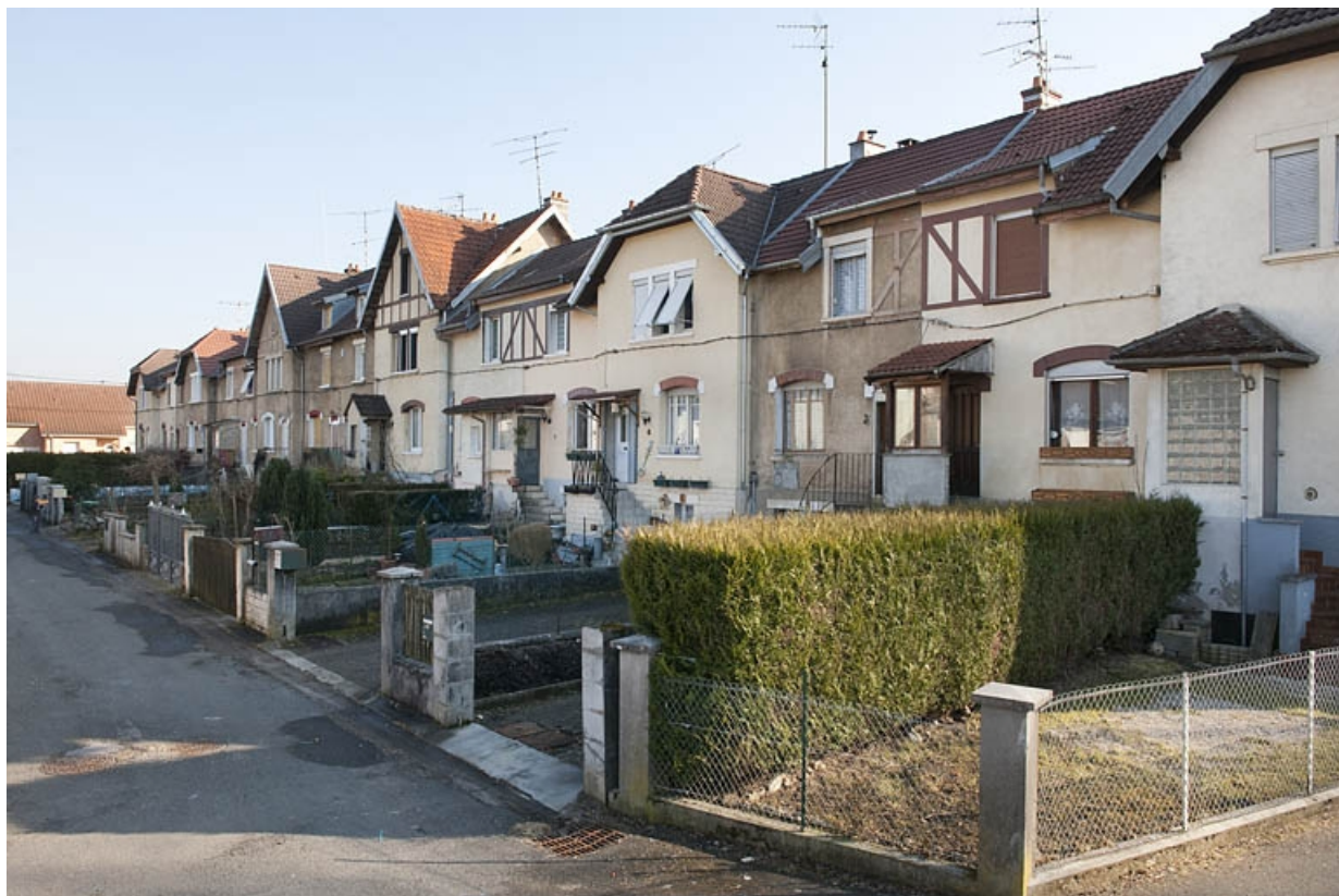
Cité du Congo. Vue d'ensemble depuis le nord-ouest.
