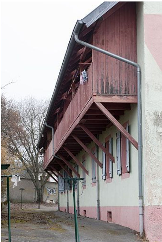
Façade postérieure de l'immeuble de 10 logements.
