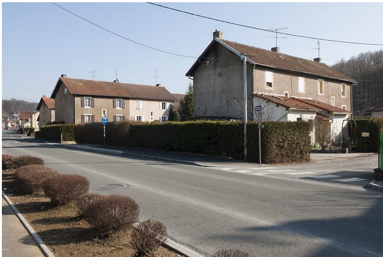
Immeubles depuis la rue du 18 Novembre. 25, Fesches-le-Château
