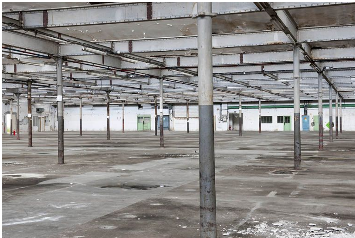
Salle de filature. Vue depuis le nord-ouest.
