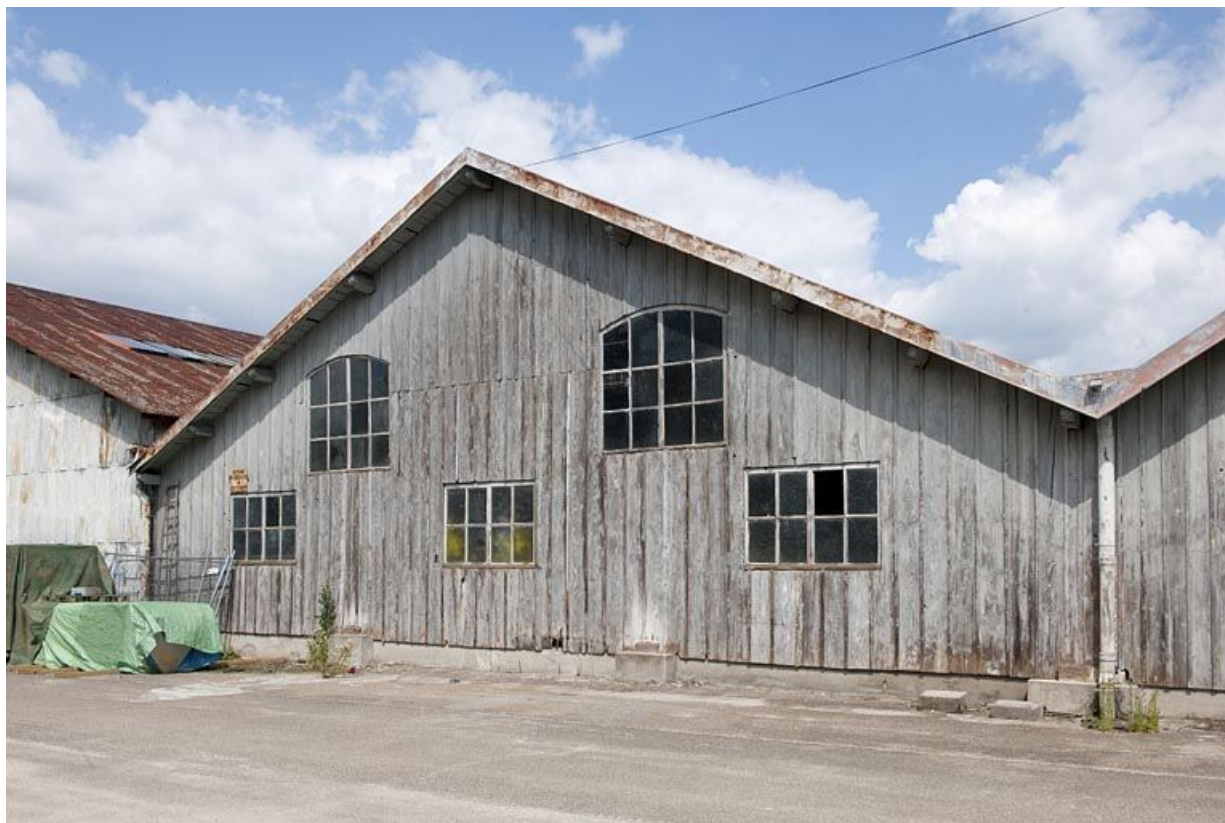
Pignon en bois d'un entrepôt industriel.
