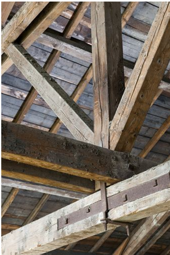
Entrepôt industriel. Charpente : jonction poinçon-entrait. 25, Exincourt, 58 rue des Mines
