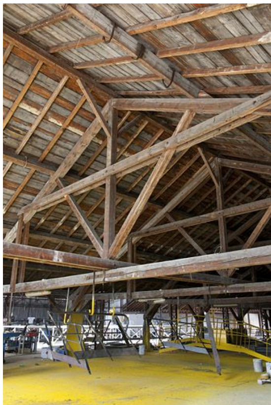
Entrepôt industriel. Charpente. 25, Exincourt, 58 rue des Mines
