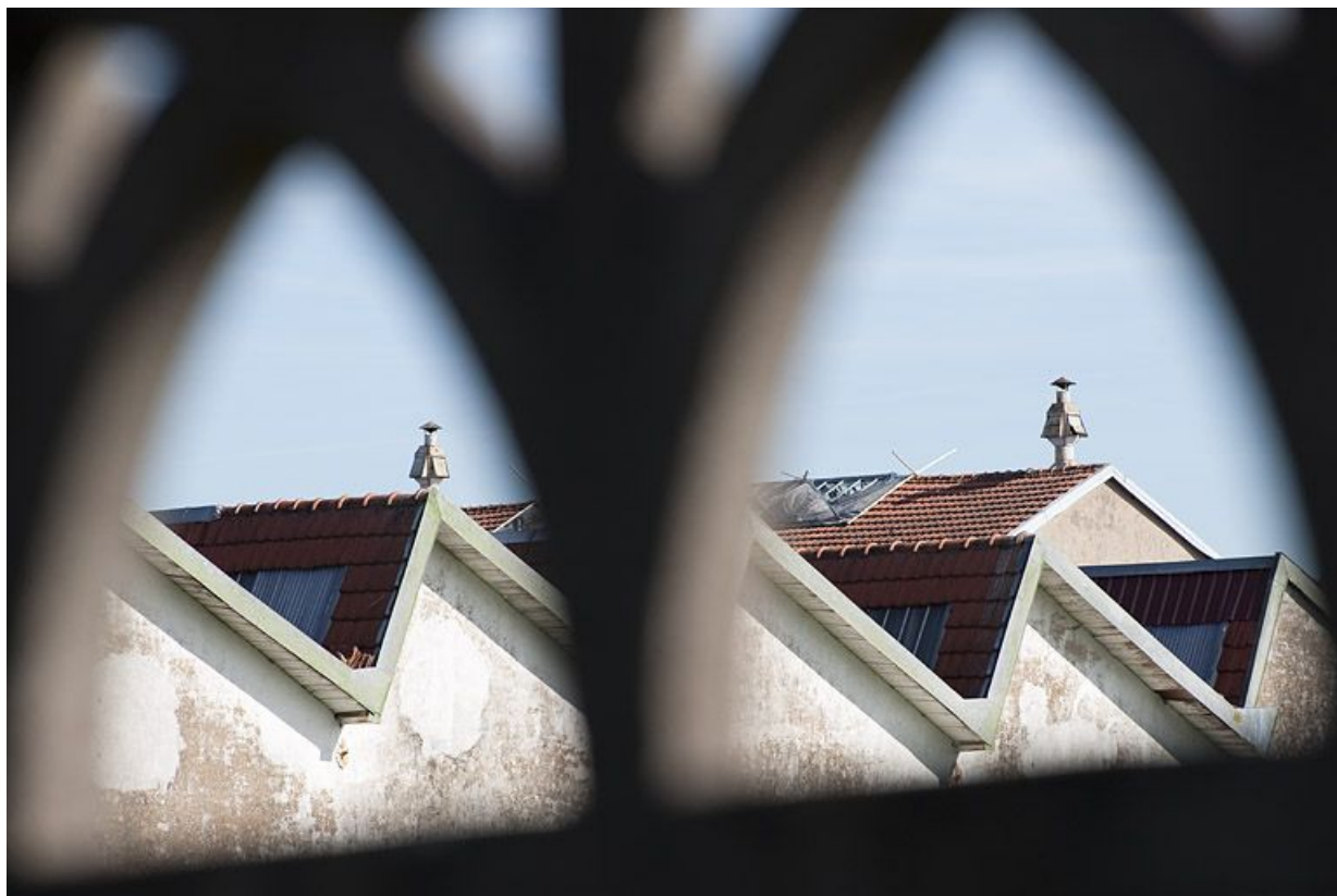
Sheds de l'atelier de filature vus à travers une clôture.
