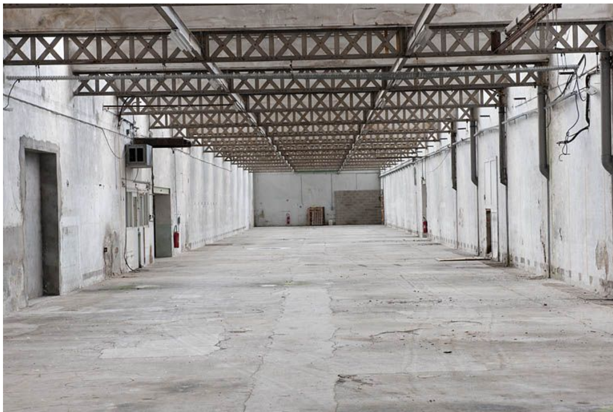
Extension ouest. Vue depuis le sud.
