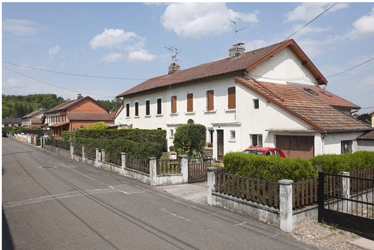
Habitation à étage. Vue de trois quarts droite. 25, Exincourt rue des Gravieres
