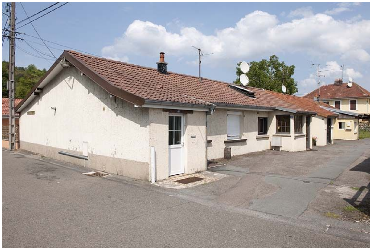
Habitation en rez-de-chaussée. Vue depuis la rue.
