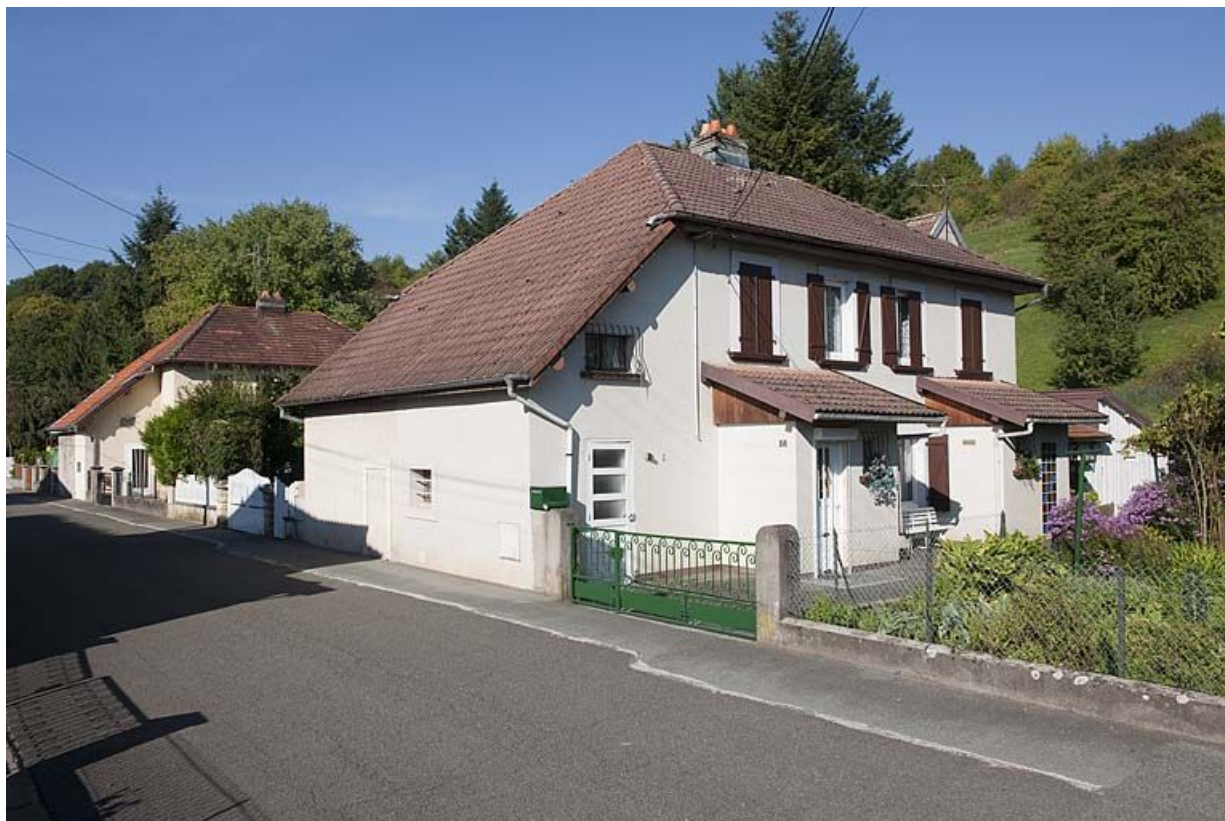
Maisons rue des Gravier. Vue de trois quarts 25, Exincourt rue du général Weygand
