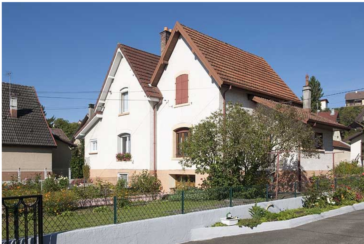
Maison double de cadre rue de la Croze. Vue de trois quarts.
