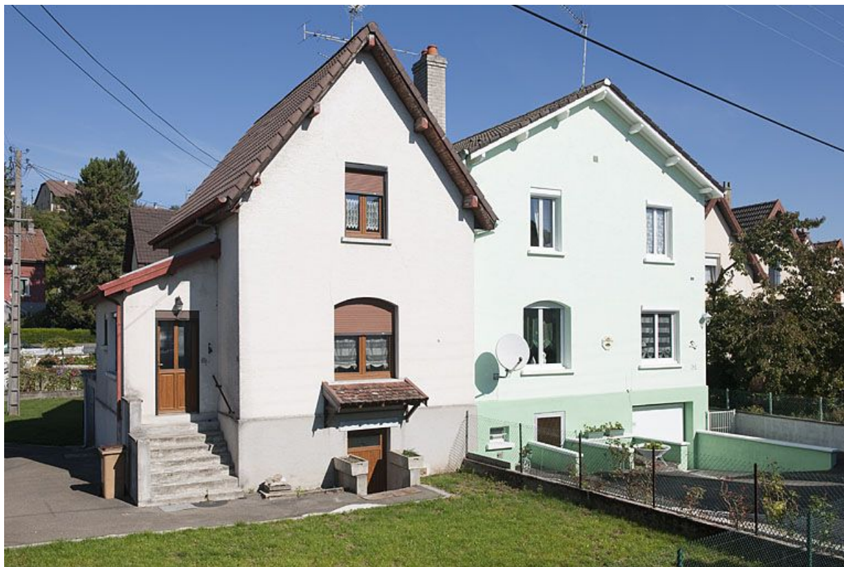
Maison double de cadre rue de la Croze. Façade sud.
