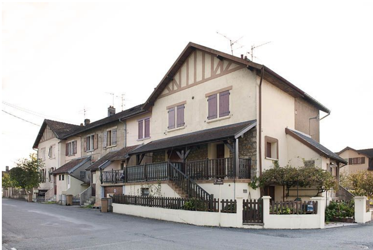
Immeuble de 8 logements. Vue de trois quarts gauche.
