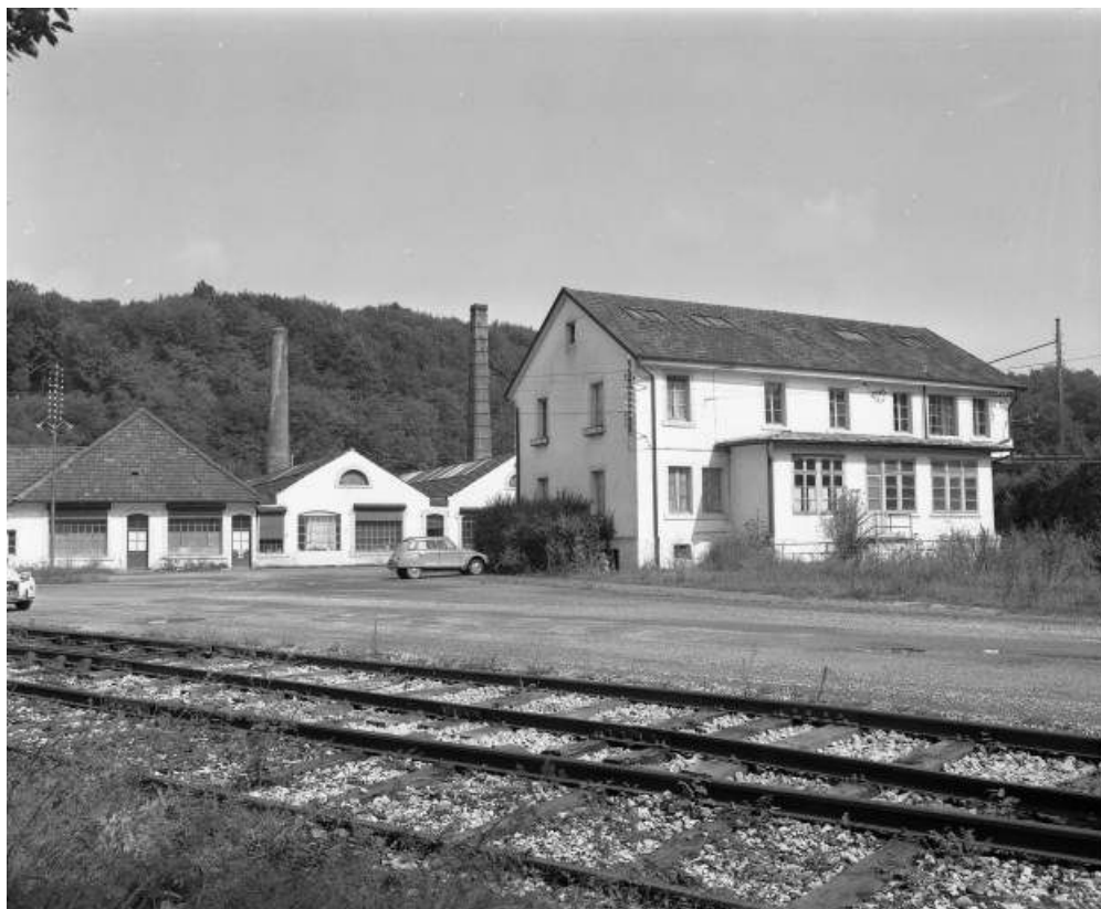
Ateliers et bâtiment de direction depuis le sud en 1981. 25, Dampierre-les-Bois rue du 8 Mai, lieudit : la Feschotte
