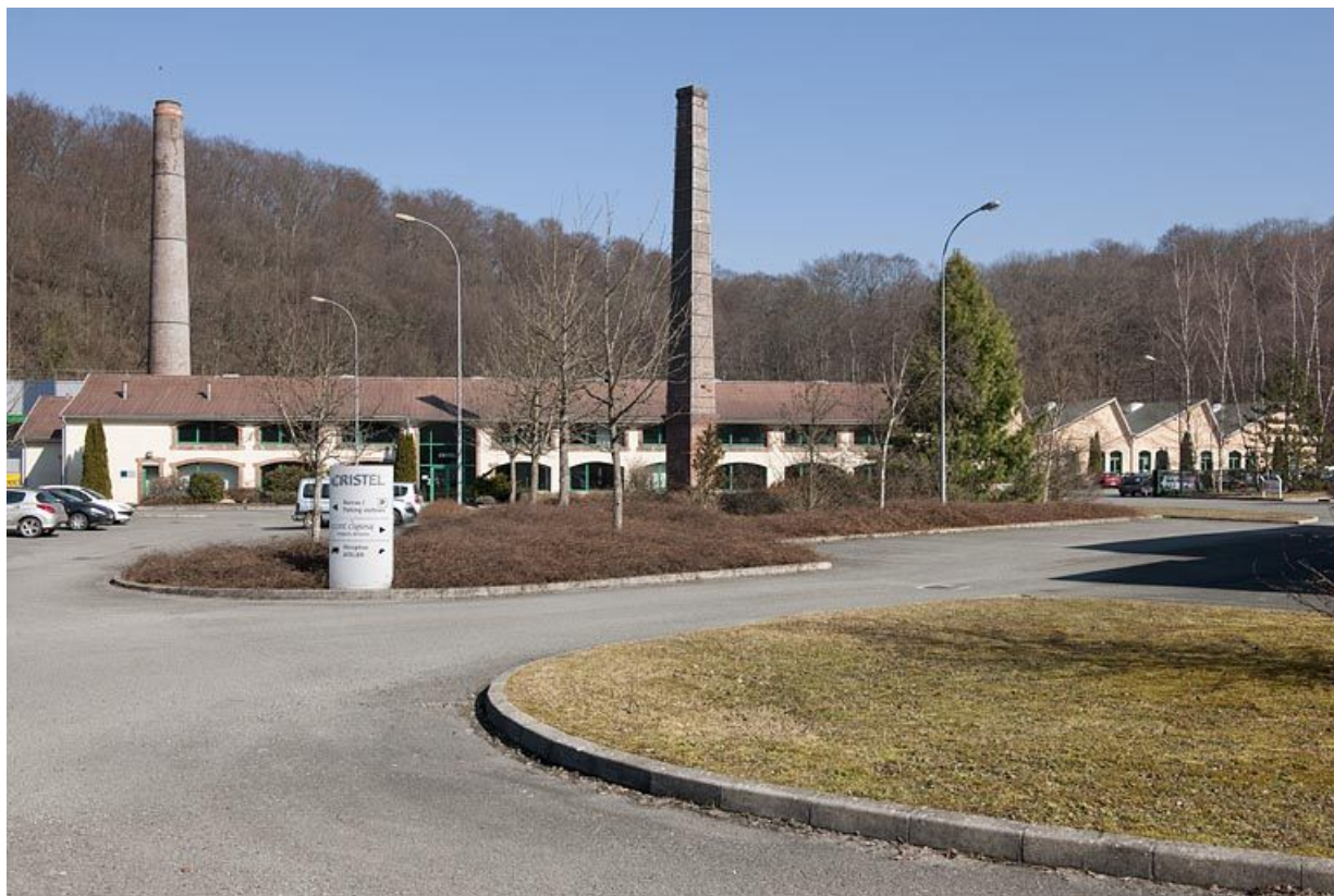
Vue d'ensemble depuis l'ouest. 25, Fesches-le-Châtel
