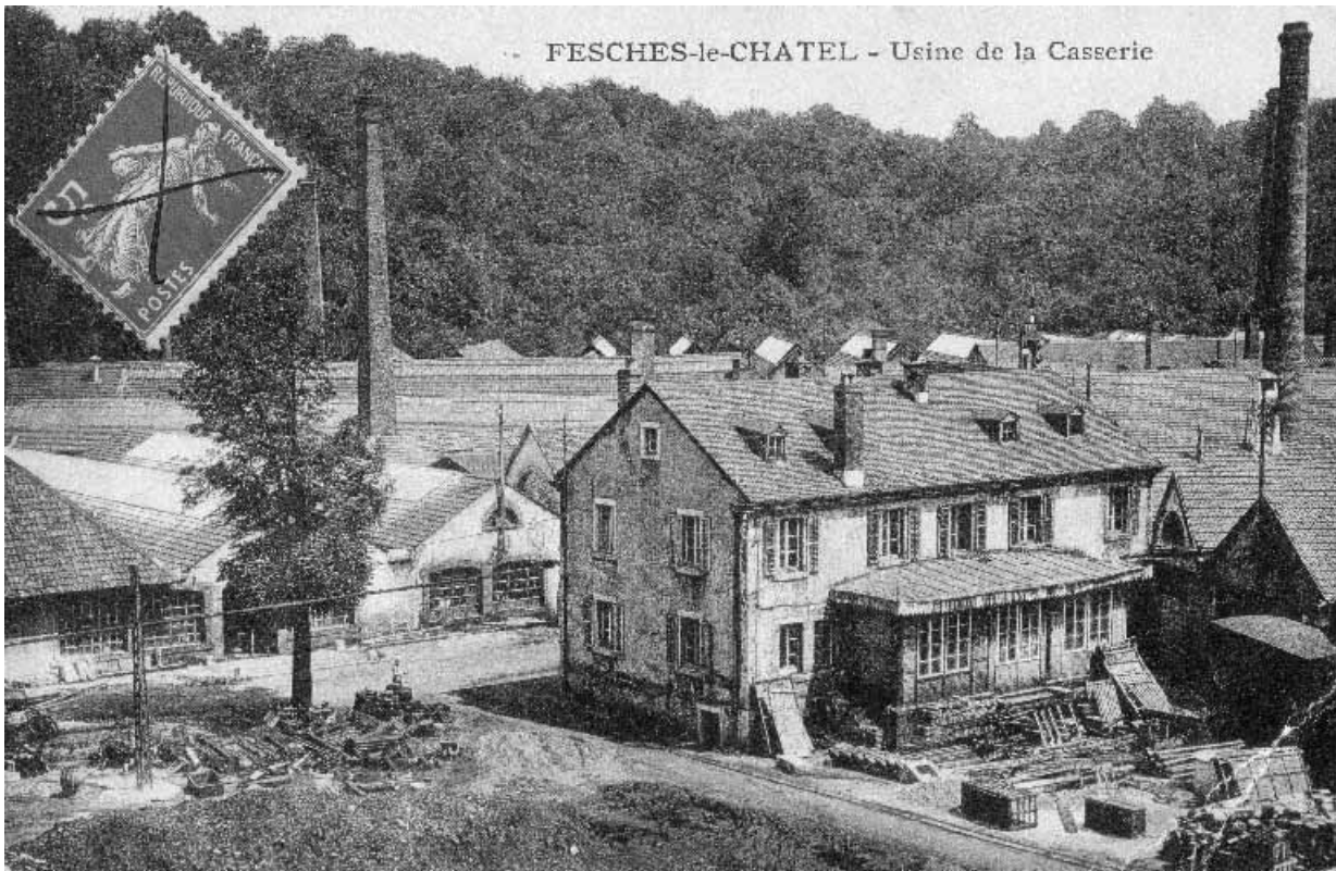
Feschés-le-Châtel - Usine de la Casserie.
