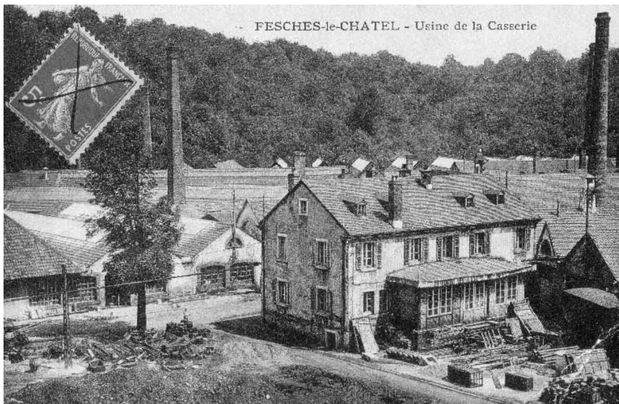
Feschés-le-Châtel - Usine de la Casserie.
