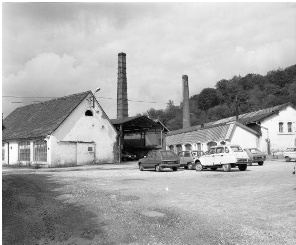
Ateliers de fabrication depuis l'est en 1981.
