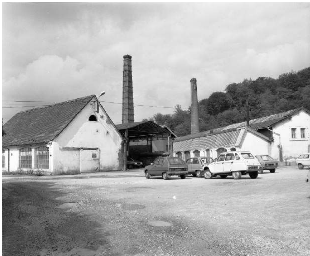
Ateliers de fabrication depuis l'est en 1981.
