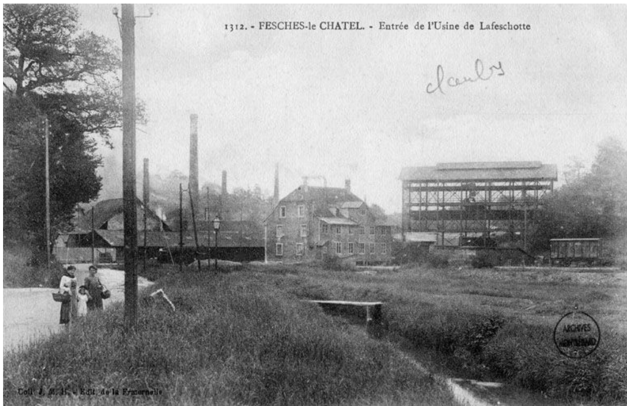
Feschés-le-Châtel. - Entrée de l'usine de Lafeschotte.
