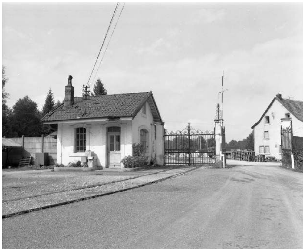
Loge du portier et entrée de l'usine en 1981.
