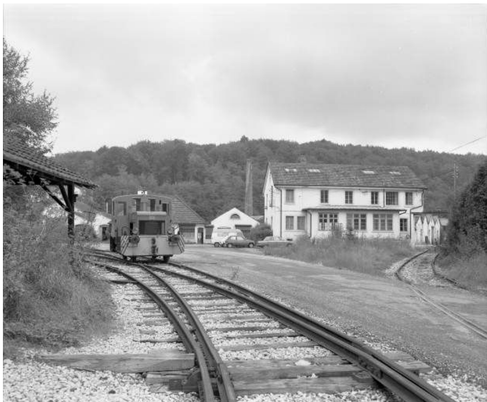
Vue d'ensemble depuis le sud-est en 1981.
