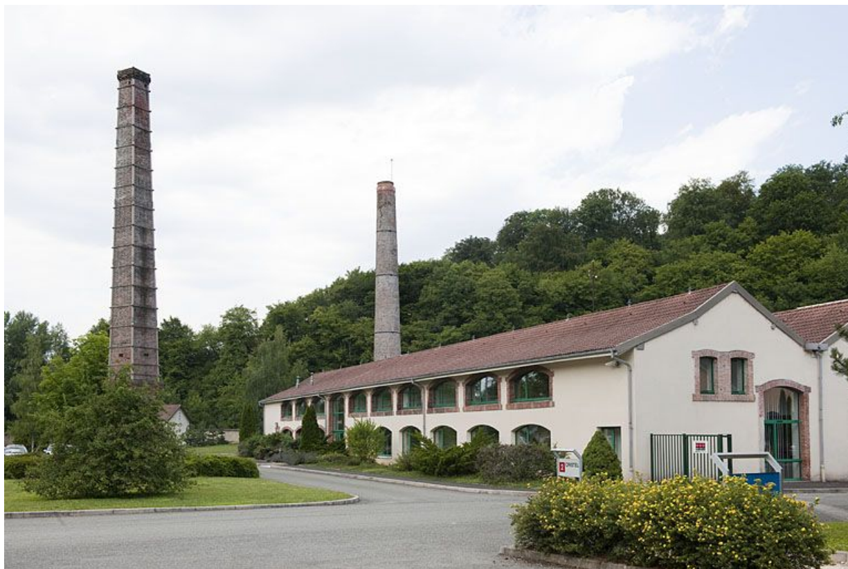
Le bâtiment des bureaux vus de trois quarts.
