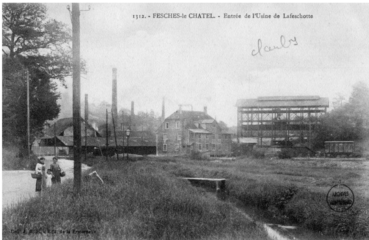
Feschés-le-Châtel. - Entrée de l'usine de Lafeschotte.
