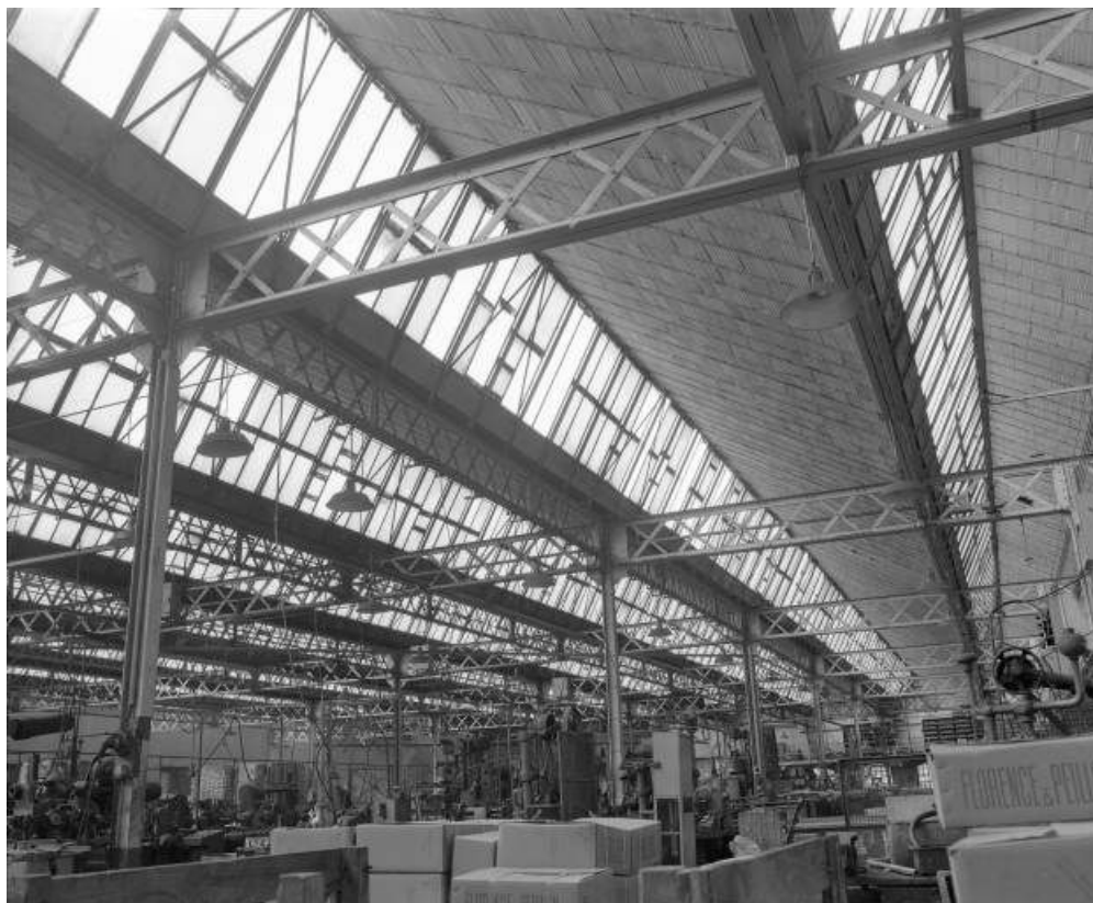
Vue intérieure de l'atelier des pompes en 1981.
