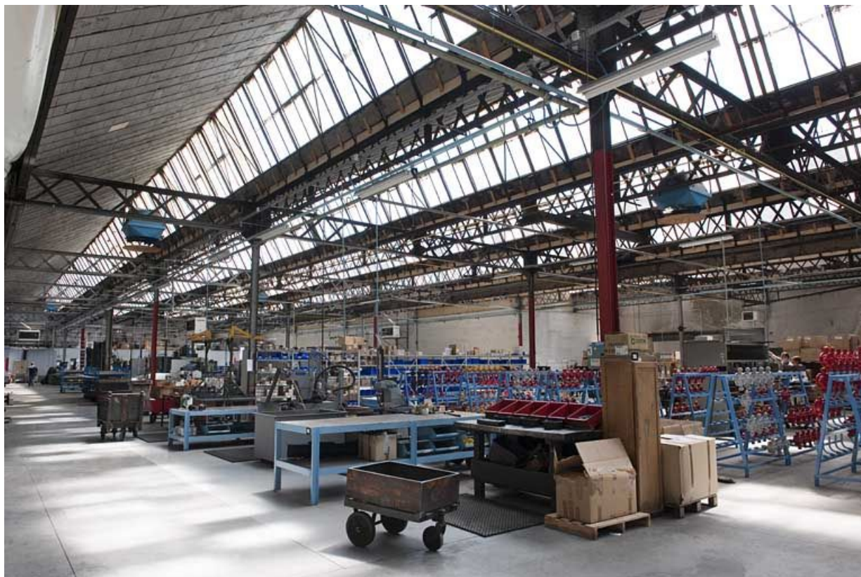
Atelier de fabrication des pompes. Vue d'ensemble depuis le nord-ouest.
