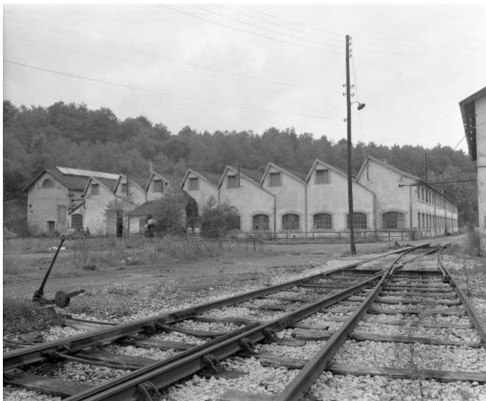
Atelier des pompes depuis l'est en 1981.
