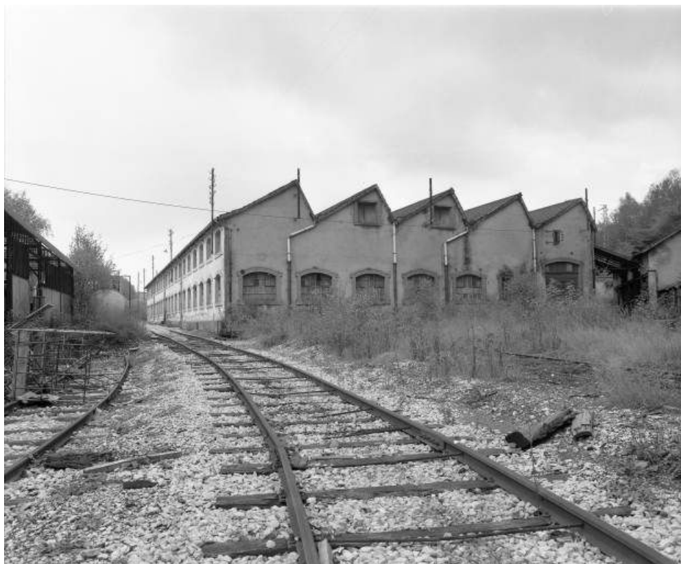
Atelier des pompes depuis l'ouest en 1981.
