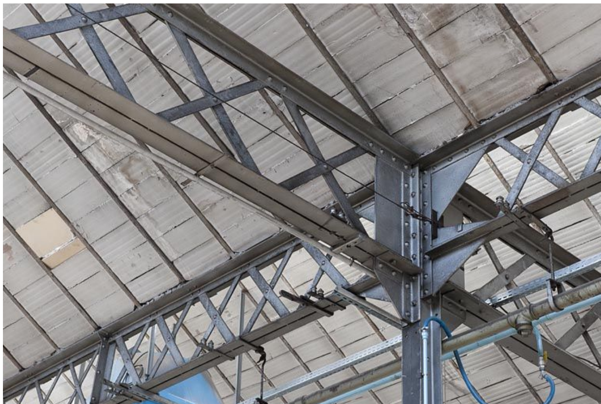
Atelier de fabrication des pompes. Détail des poutrelles de la charpente métallique.
