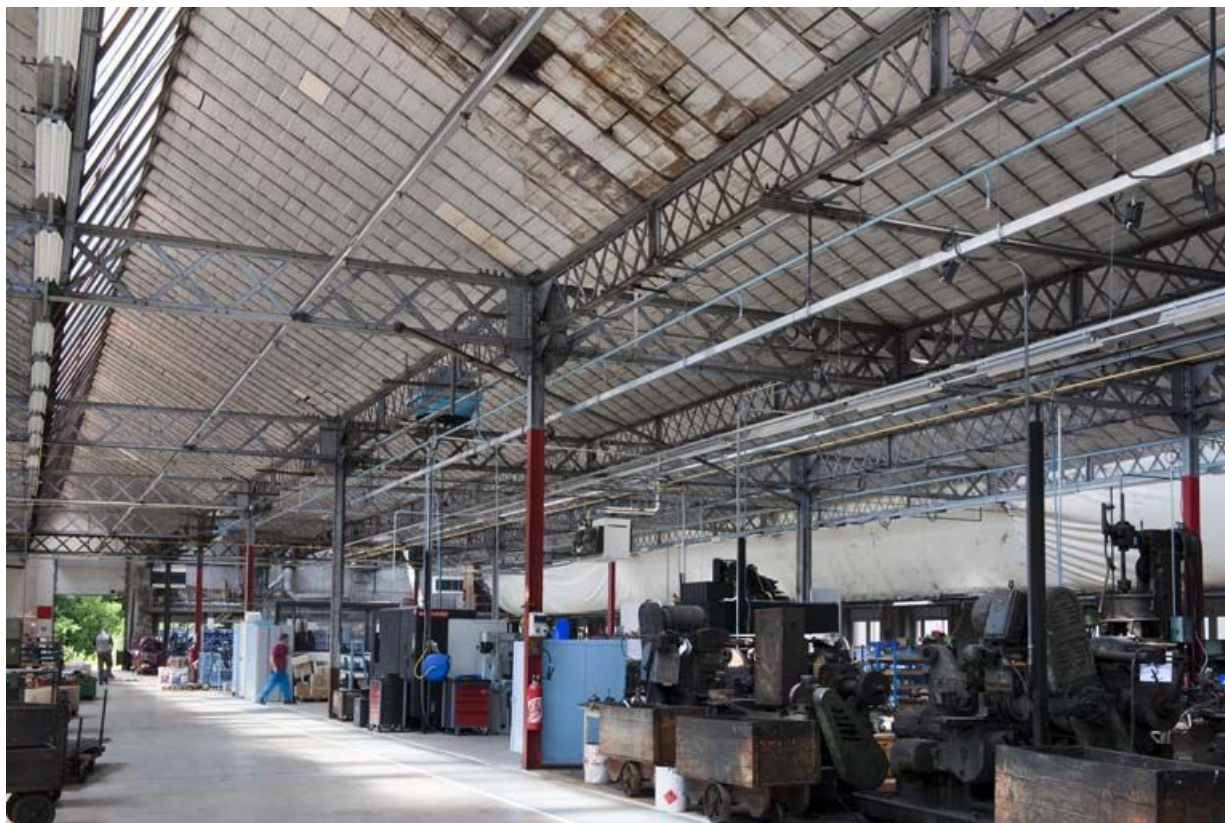
Atelier de fabrication des pompes. Vue d'ensemble vers l'ouest. 25, Dampierre-les-Bois rue des Etains, lieudit : la Feschotte du Haut
