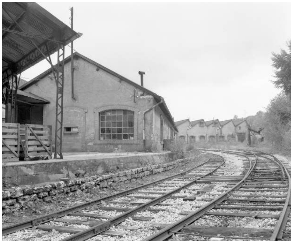
Magasin des fournitures générales et atelier des pompes depuis la voie ferrée 1981.
