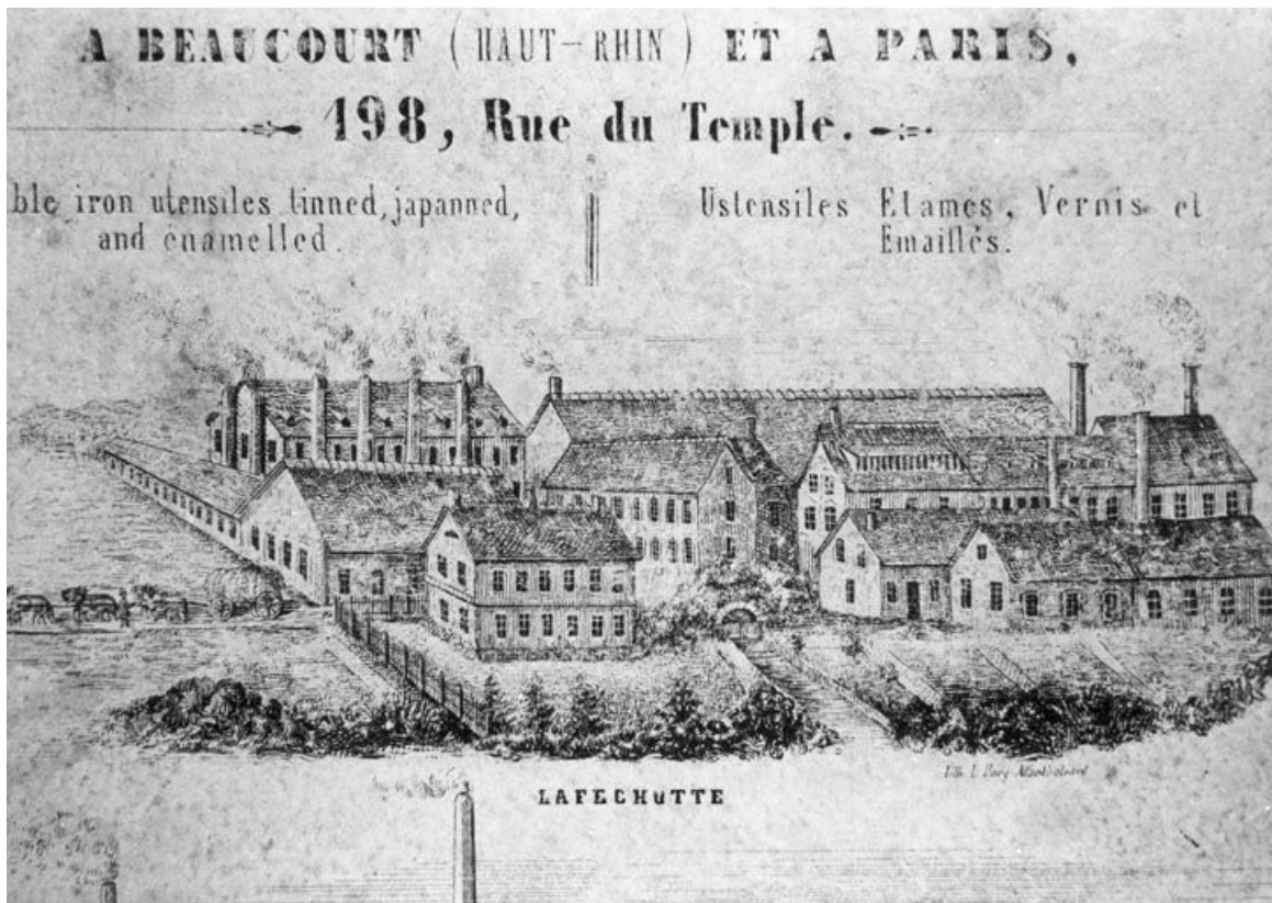
[Vue cavalière de l'usine de Lafeschotte].
