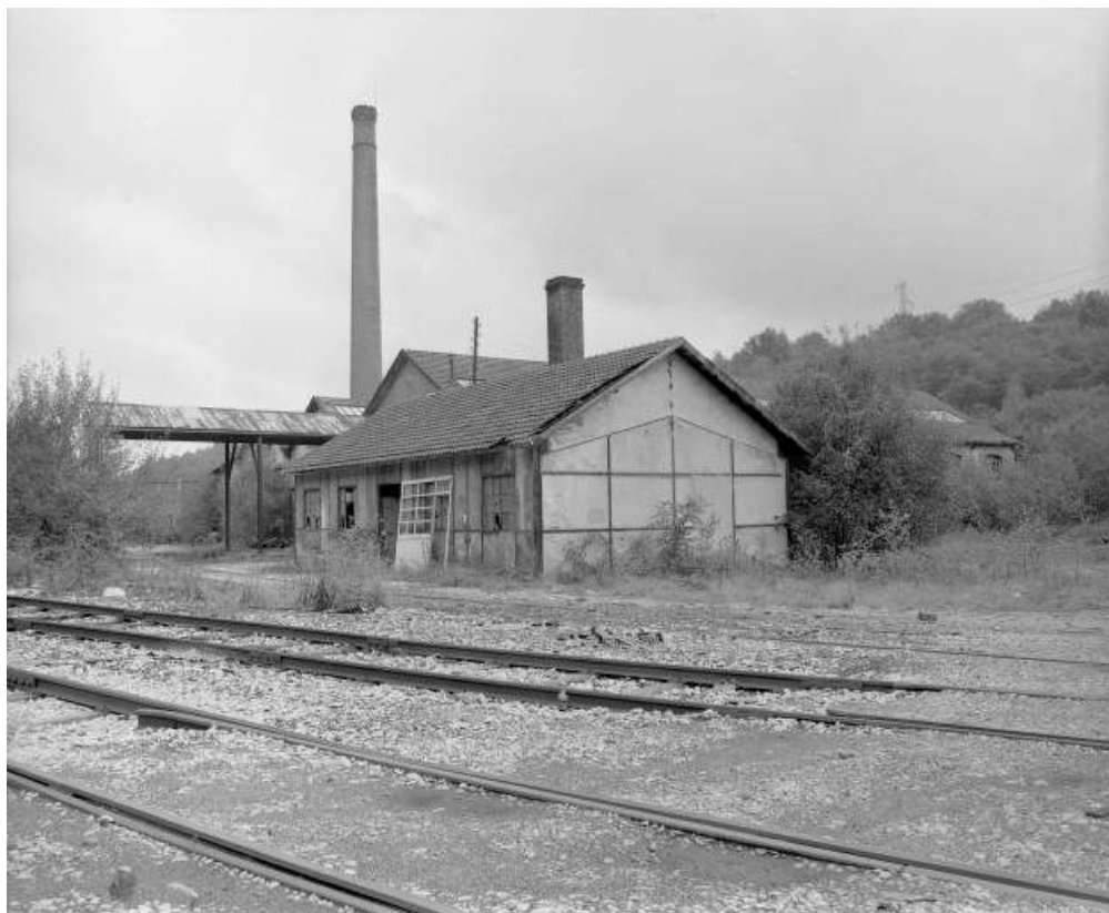
Chaudière devant l'atelier de galvanisation en 1981.
