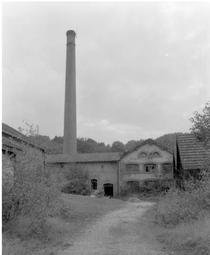
Façade nord de l'atelier de galvanisation en 1981.
