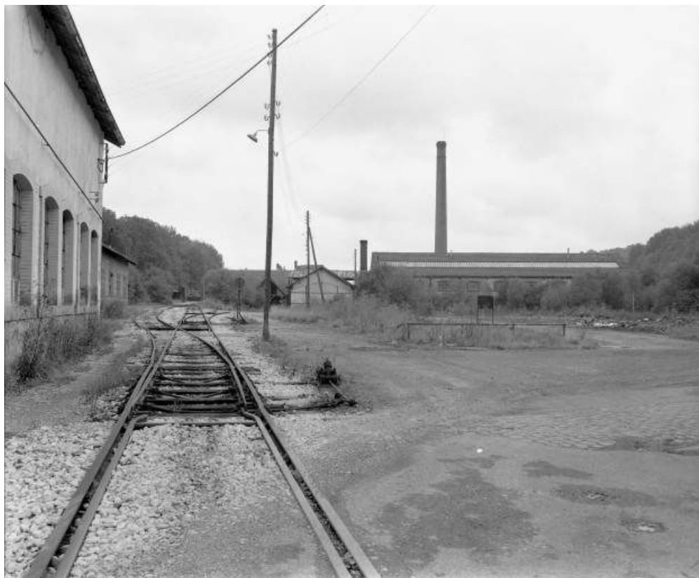
Vue depuis l'ouest. Atelier de galvanisation et sa cheminée en 1981.
