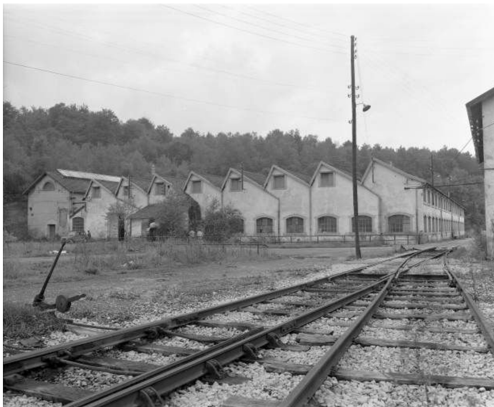
Atelier des pompes depuis l'est en 1981.
