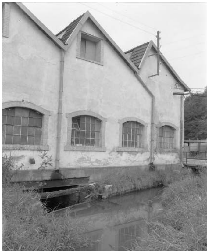
Bief de dérivation sous l'atelier des pompes en 1981.
