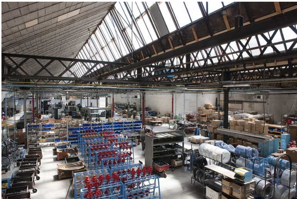
Atelier de fabrication des pompes. Vue plongeante depuis le nord-ouest.
