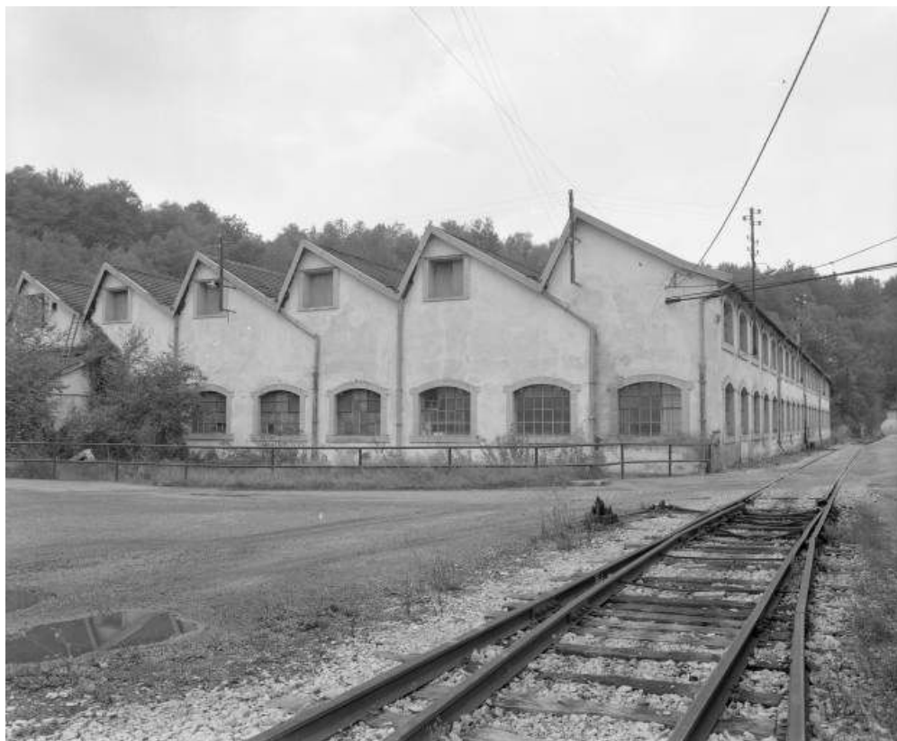
Vue rapprochée de l'atelier des pompes en 1981.
