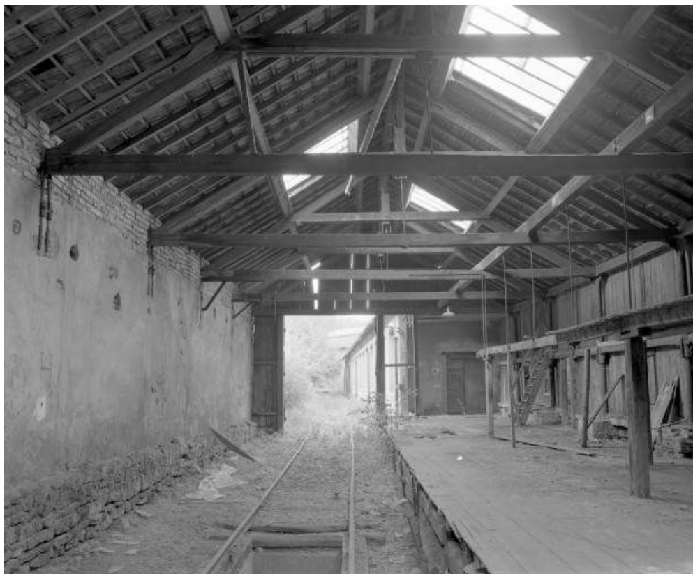
Quai de chargement jouxtant l'atelier de fabrication (pots à lait et fûts à bière) en 1981.
