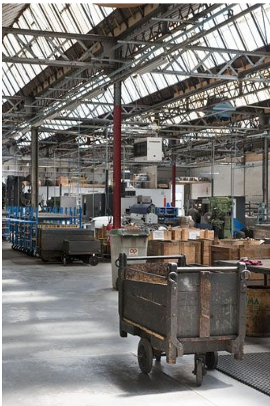
Atelier de fabrication des pompes. Vue partielle.
