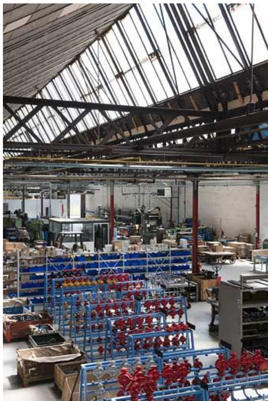
Atelier de fabrication des pompes. Vue plongeante vers l'est. 25, Dampierre-les-Bois rue des Etains, lieudit : la Feschotte du Haut
