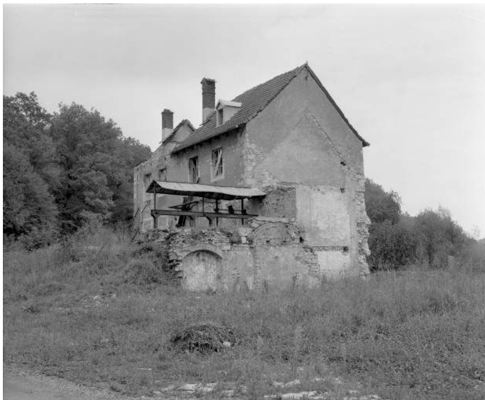
Vestiges de l'usine de Lafeschotte du Haut en 1981. Vue depuis le sud-ouest en 1981.
