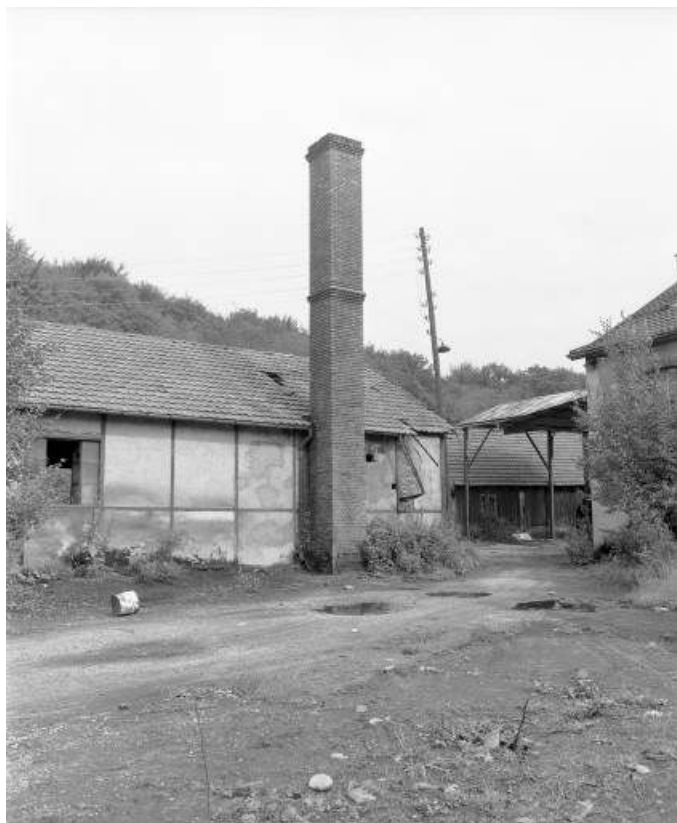
La chaufferie et sa cheminée en 1981.
