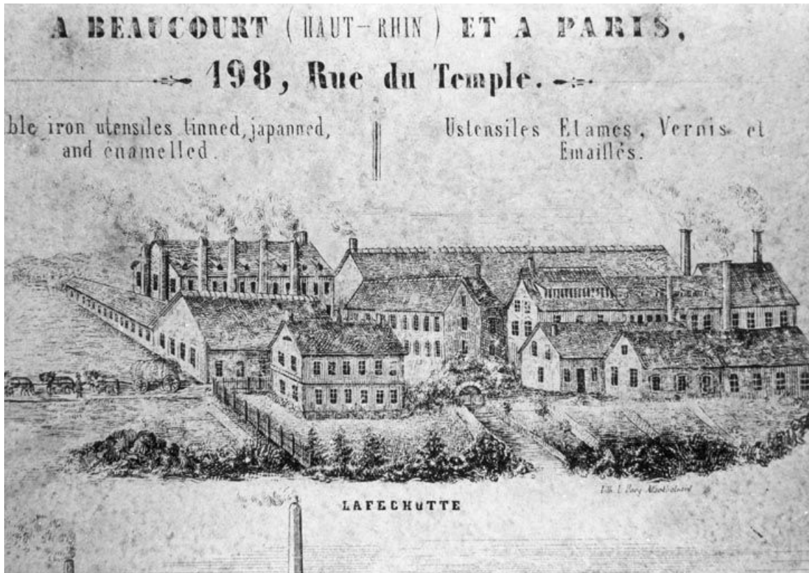
[Vue cavalière de l'usine de Lafeschotte].
