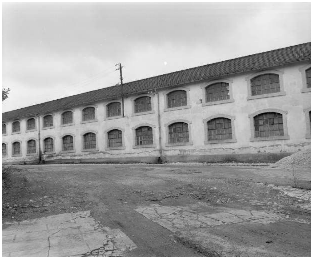
Façade nord de l'atelier des pompes en 1981.
