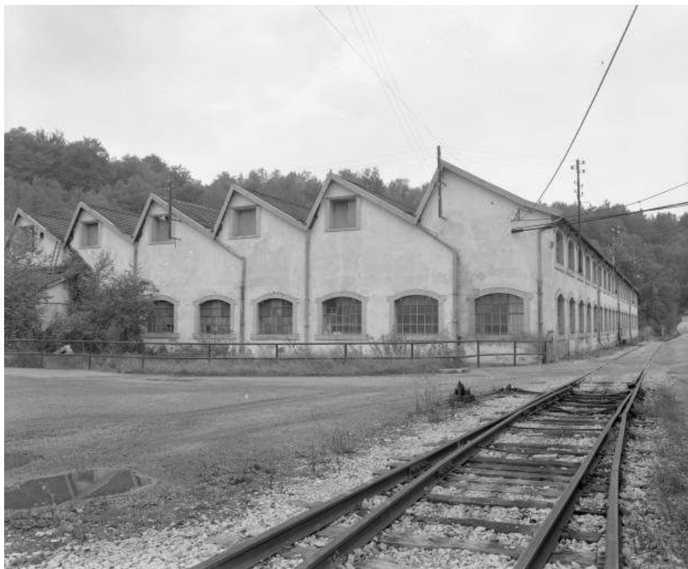
Vue rapprochée de l'atelier des pompes en 1981.
