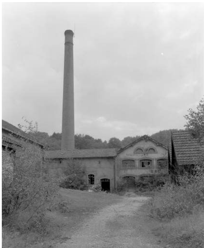
Façade nord de l'atelier de galvanisation en 1981.
