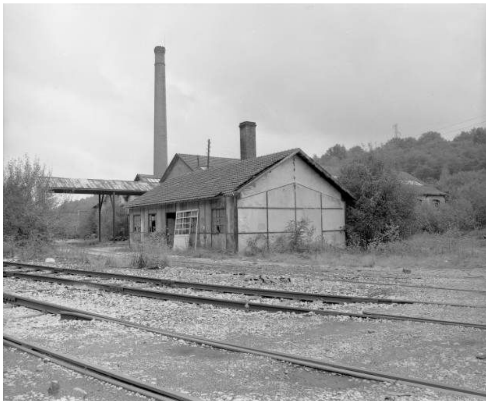
Chaudière devant l'atelier de galvanisation en 1981.
