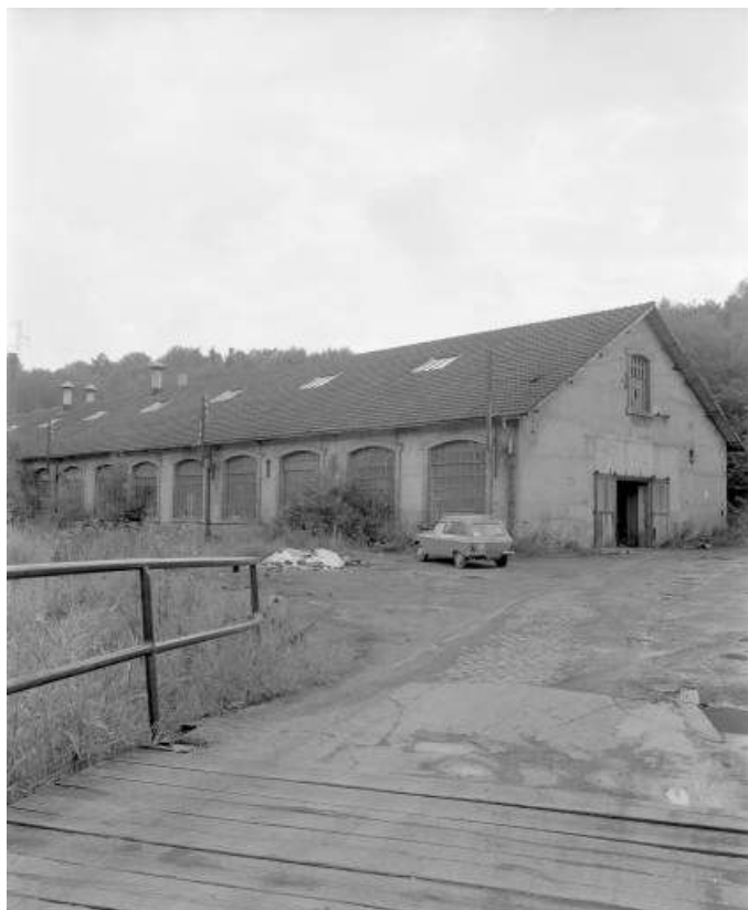
Atelier de fabrication (pots à lait et fûts à bière) en 1981.
