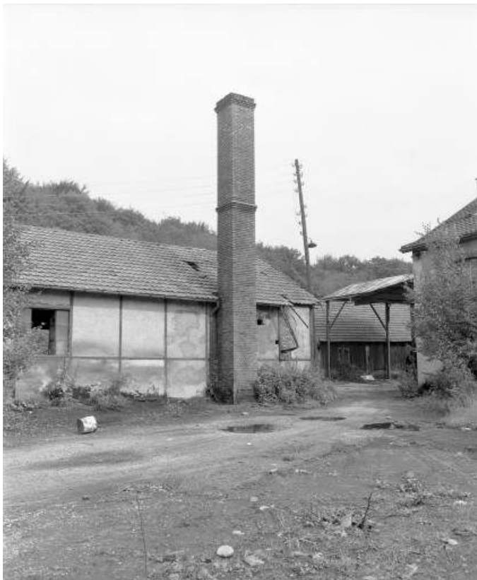
La chaufferie et sa cheminée en 1981.
