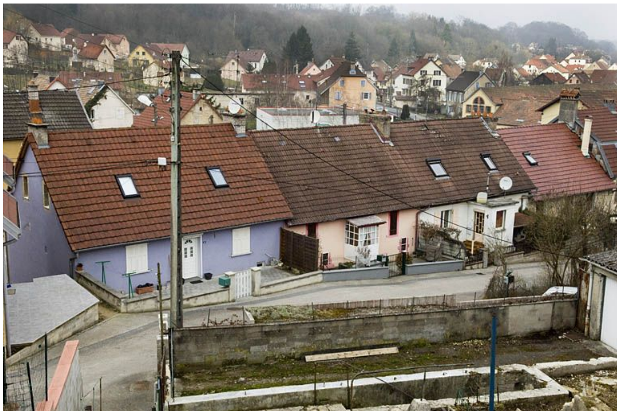
Façades postérieures des logements ouvriers (rue de la Voûte). 25, Badevel Grande Rue
