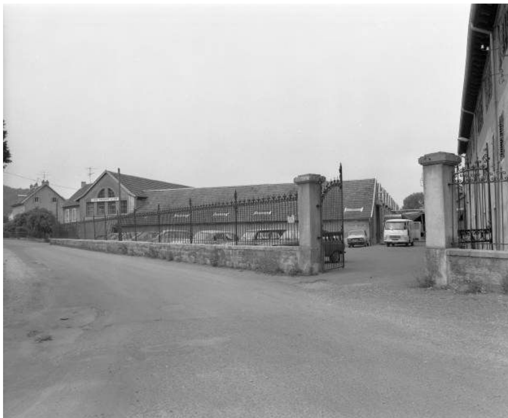
Ateliers en rez-de-chaussée depuis le sud en 1981.
