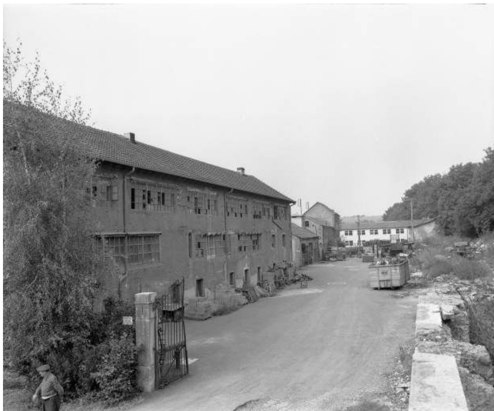
Façade est de l'atelier de montage de pendules (?) en 1981.
