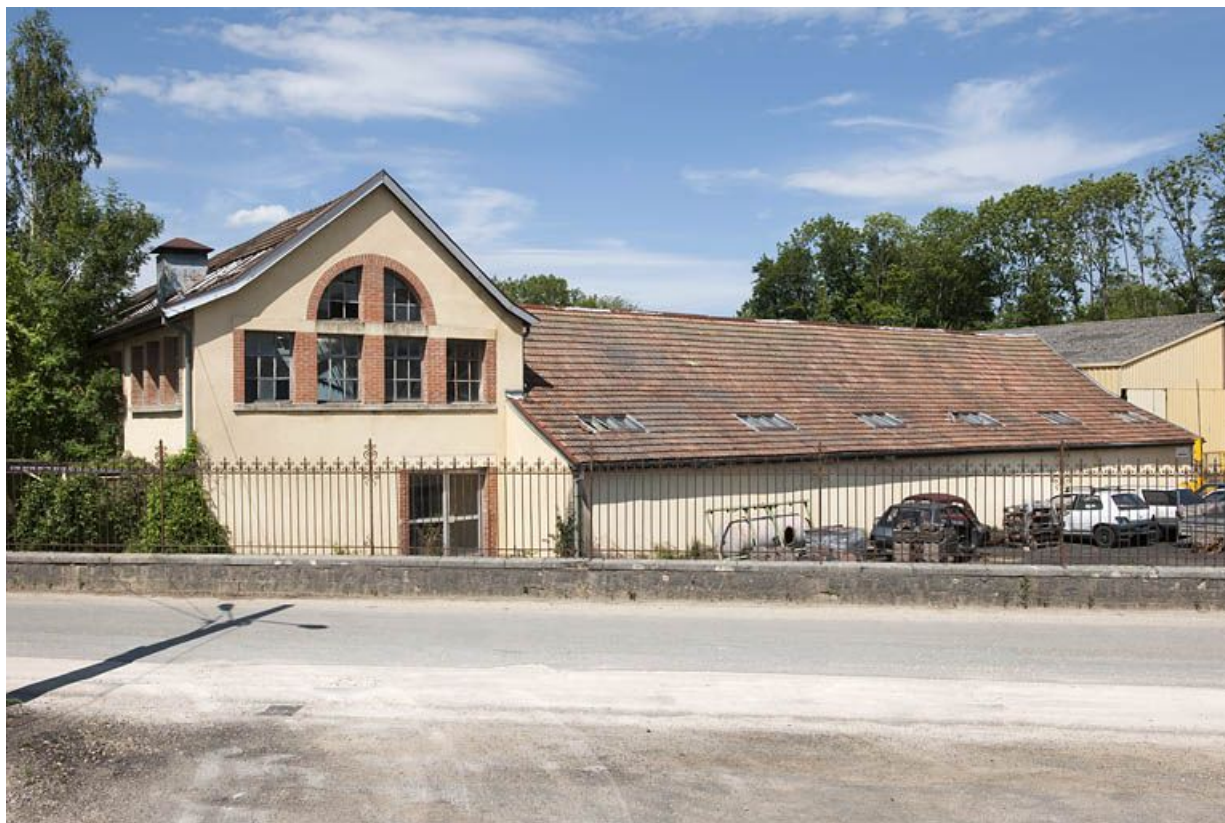
Atelier de fabrication (emboutissage, décolletage).
