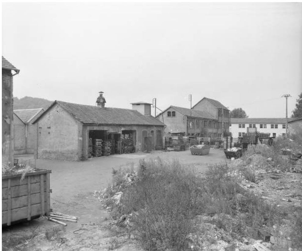
Ateliers divers depuis le sud-est en 1981. 25, Badevel Grande Rue
