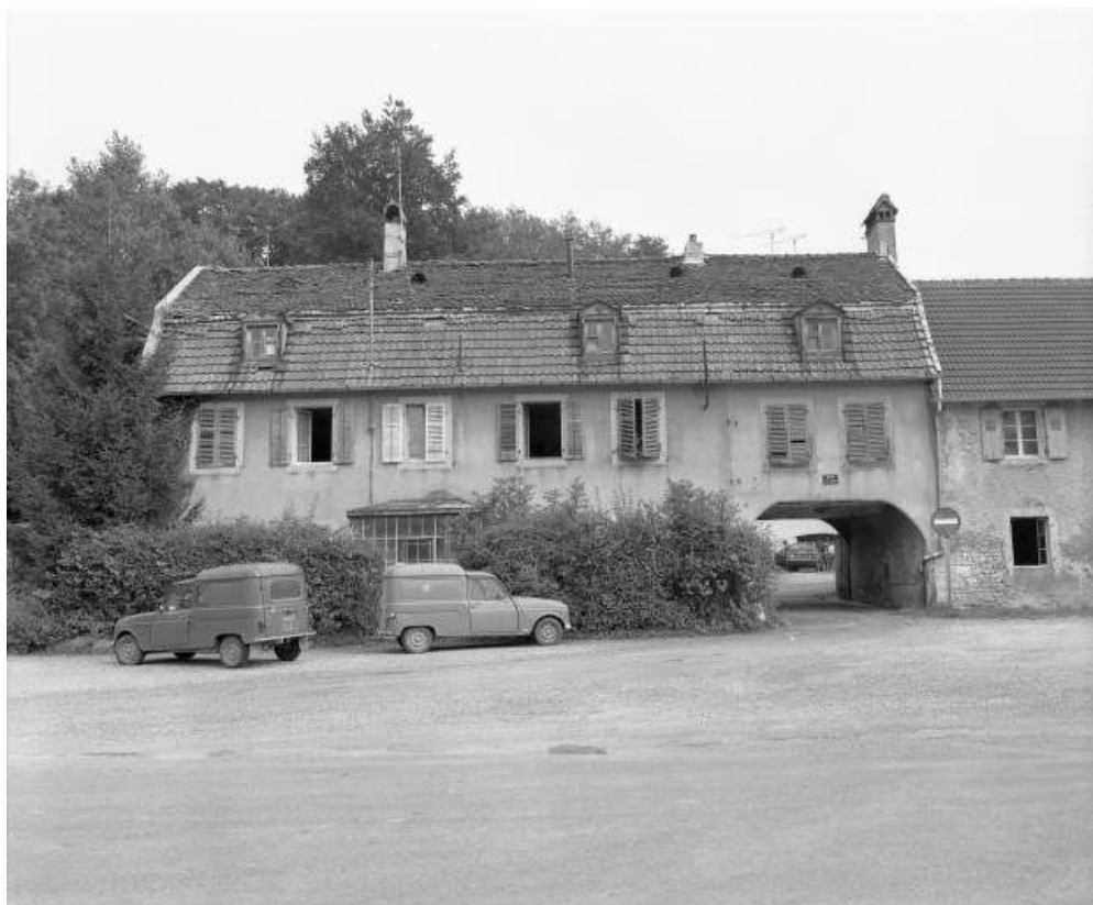
Maison de direction. Vue de face en 1981.
