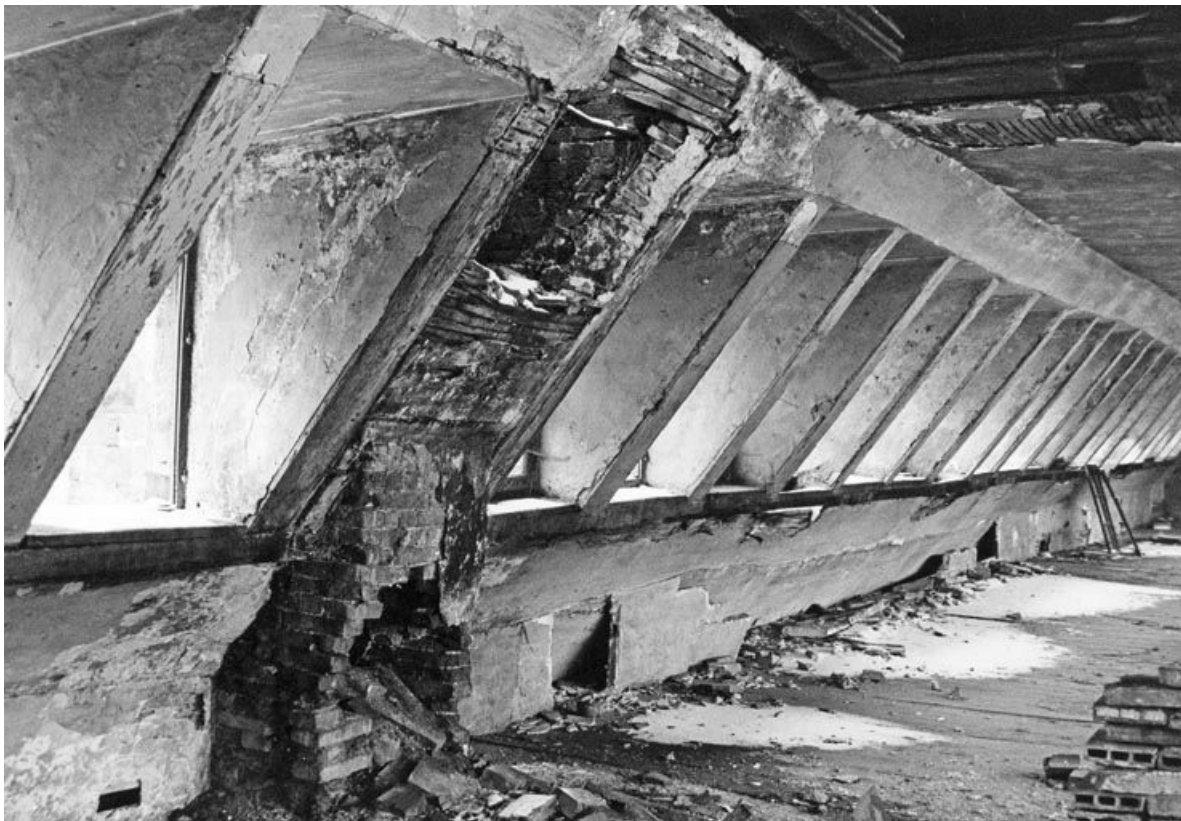
Vue intérieure du deuxième étage de comble : fenêtres et cheminée. 25, Badevel Grande Rue
