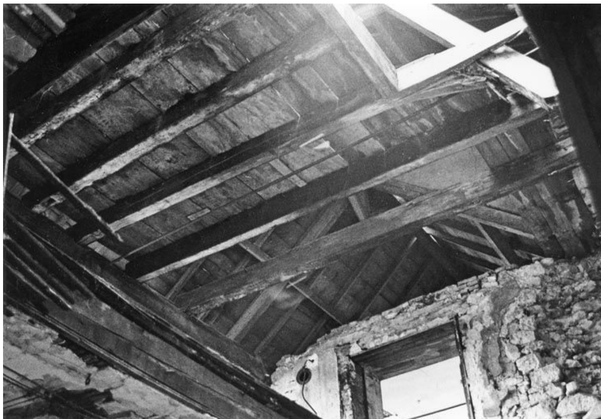
Atelier de fabrication : détail de la charpente.
