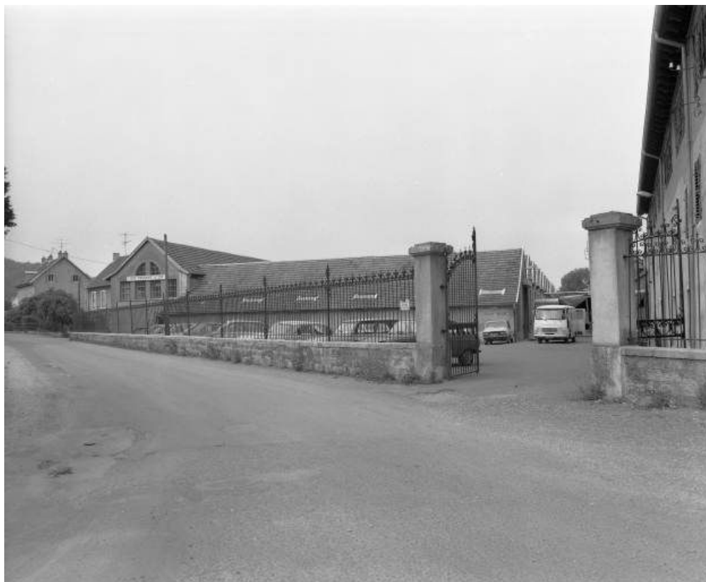
Ateliers en rez-de-chaussée depuis le sud en 1981.
