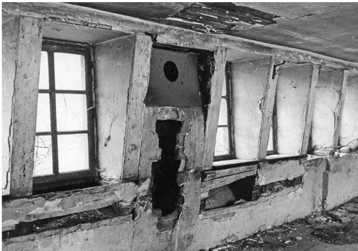
Vue intérieure du premier étage de comble : fenêtres et cheminée.
