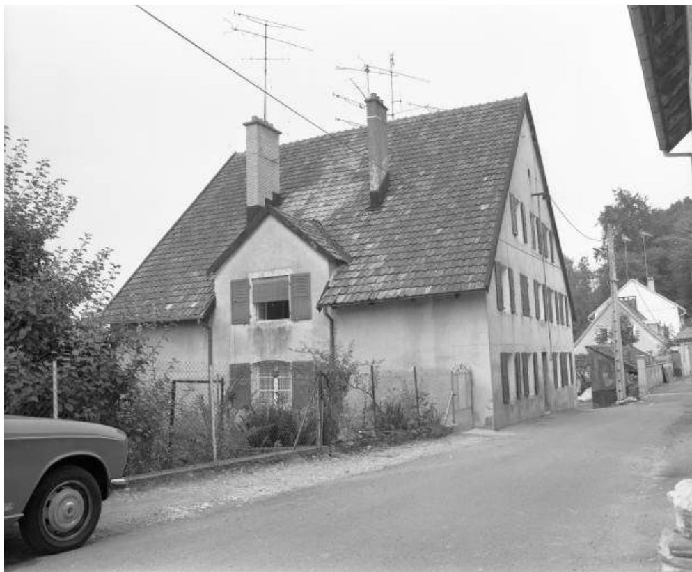
Bâtiment abritant des écuries et des logements ouvriers. Vue de trois quarts arrière en 1981. 25, Badevel Grande Rue
