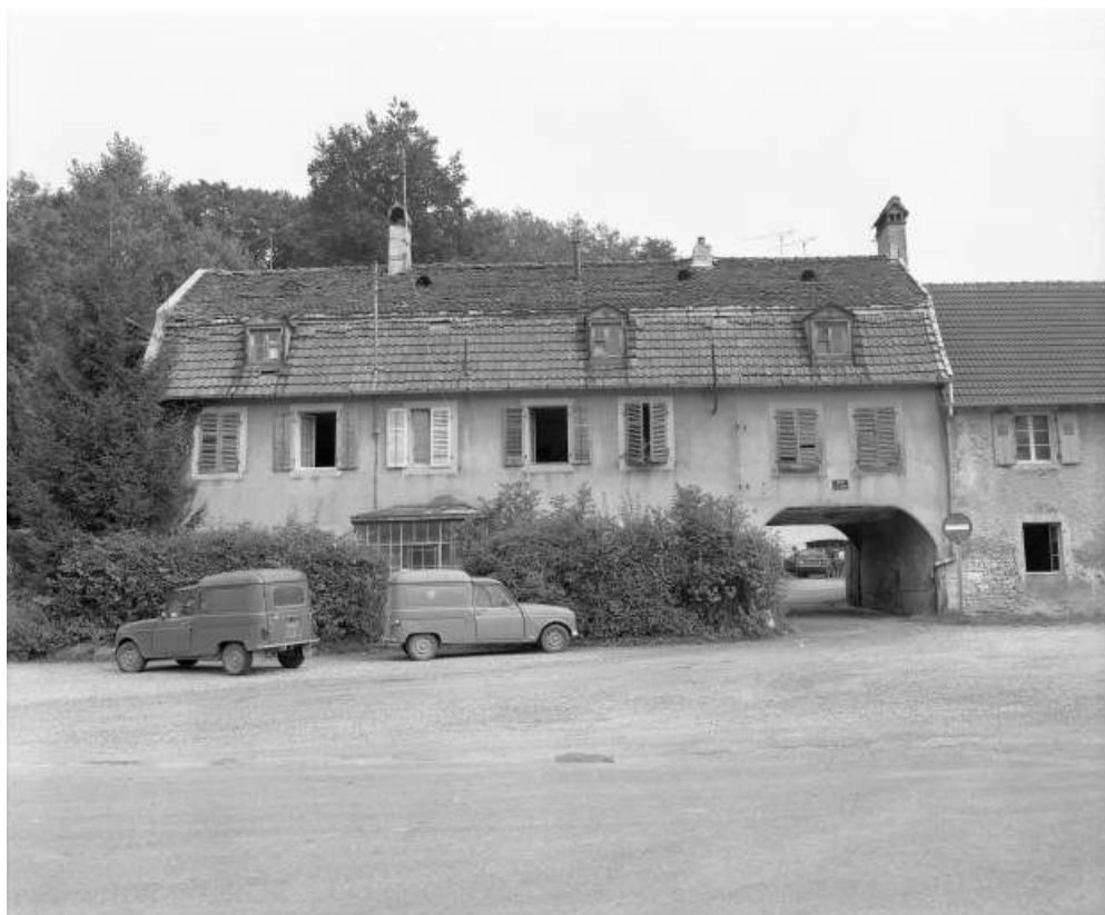
Maison de direction. Vue de face en 1981.
