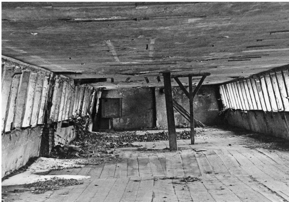
Atelier de fabrication : vue intérieure du premier étage de comble. 25, Badevel Grande Rue
