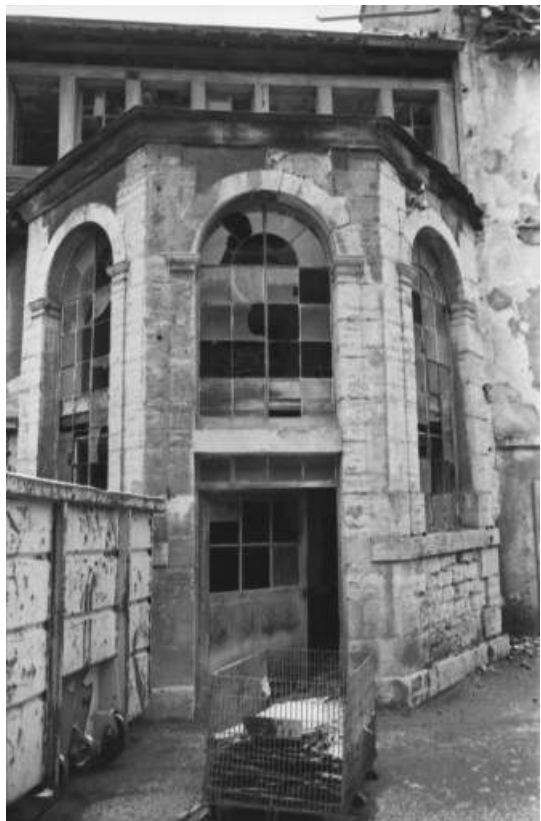
Atelier d'horlogerie. Détail de l'entrée en 1979.
