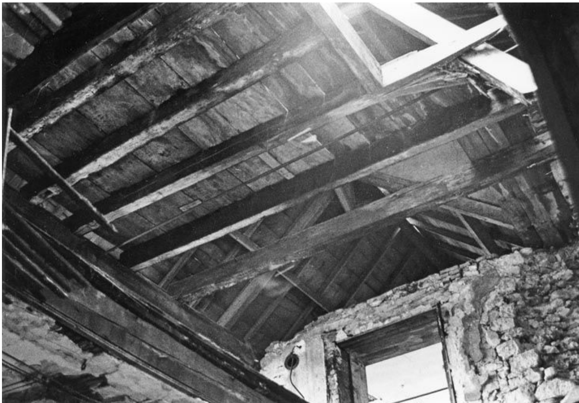
Atelier de fabrication : détail de la charpente.
