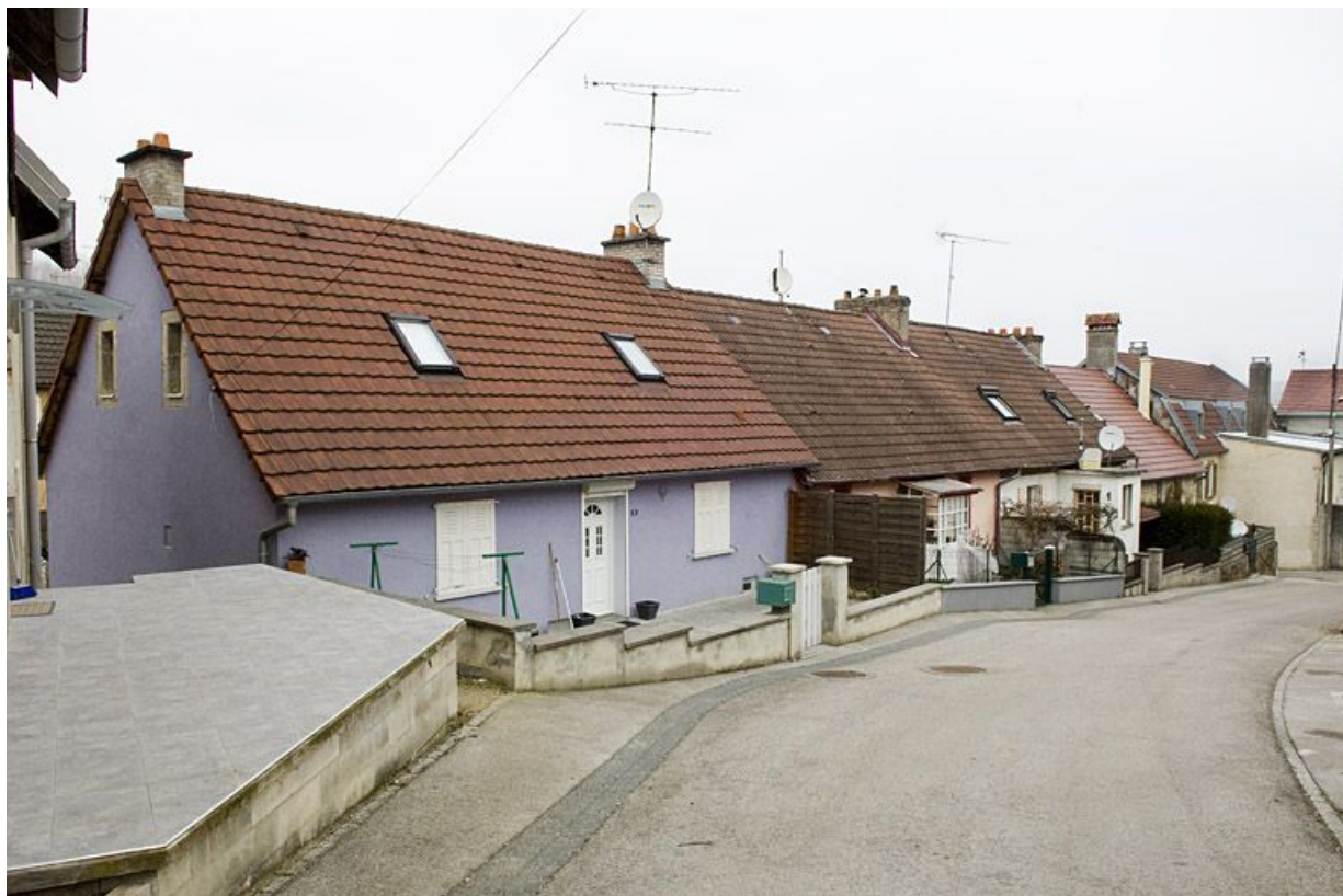
Logements ouvriers (rue de la Voûte). 25, Badevel Grande Rue
