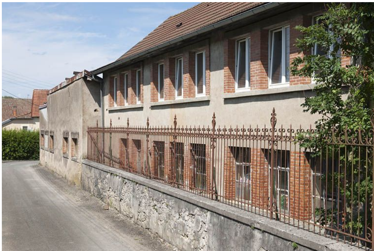
Façade ouest d'un bâtiment industriel (atelier ?). 25, Badevel Grande Rue
