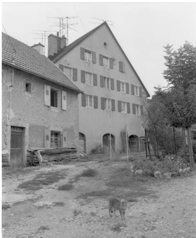
Bâtiment abritant des écuries et des logements ouvriers en 1981. 25, Badevel Grande Rue
