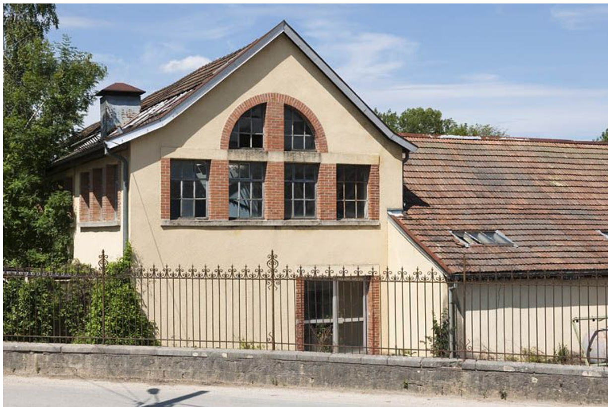
Pignon sud d'un bâtiment industriel (atelier ?). 25, Badevel Grande Rue
