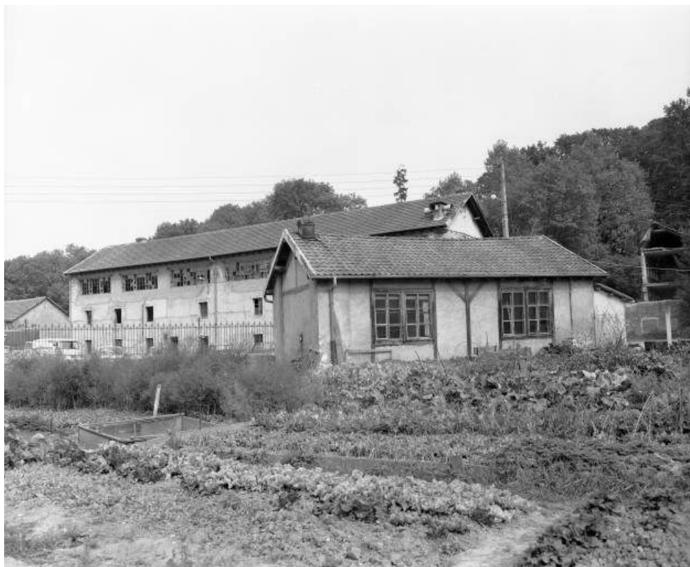
Salle de réunion pour la fanfare de l'usine en 1981. 25, Badevel Grande Rue
