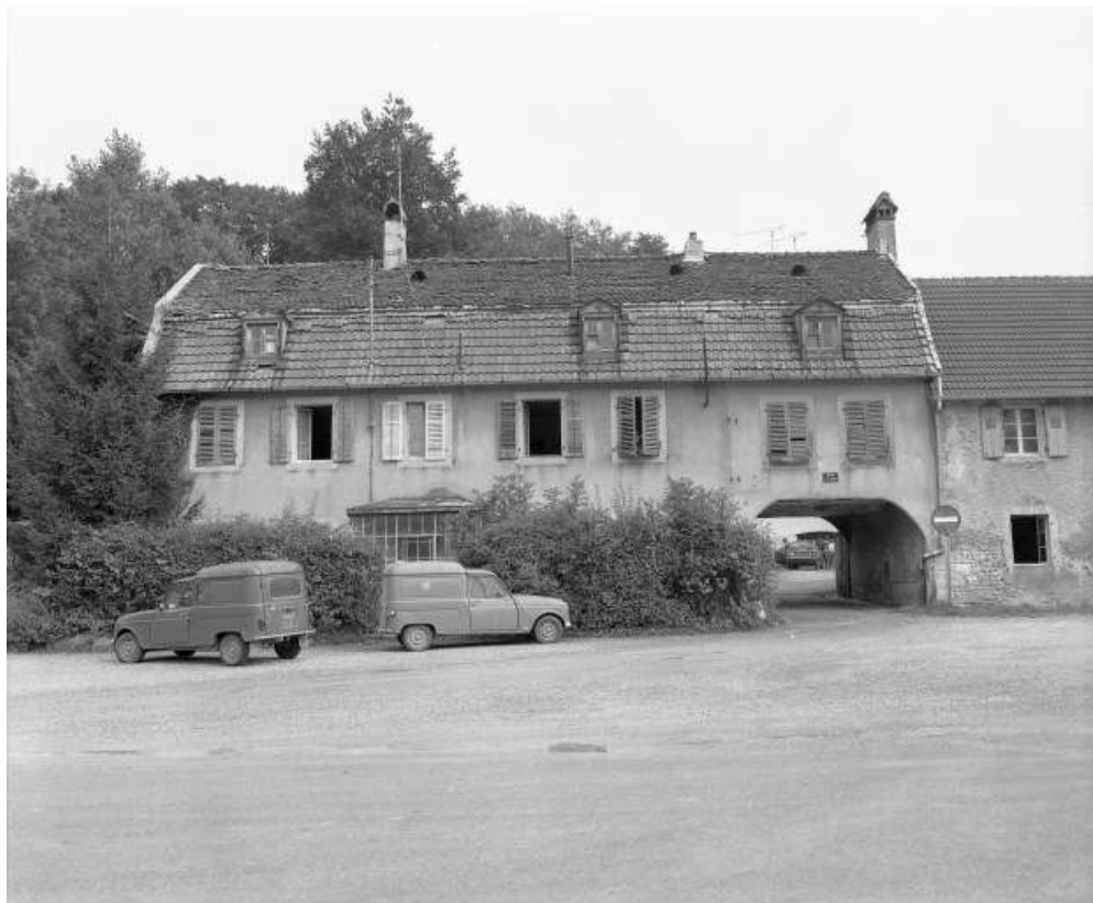
Maison de direction. Vue de face en 1981.
