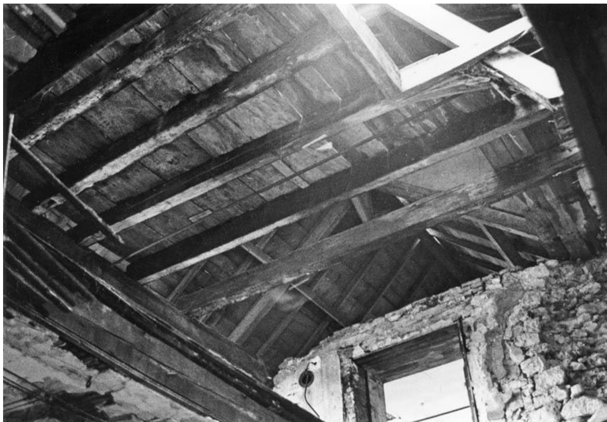
Atelier de fabrication : détail de la charpente.
