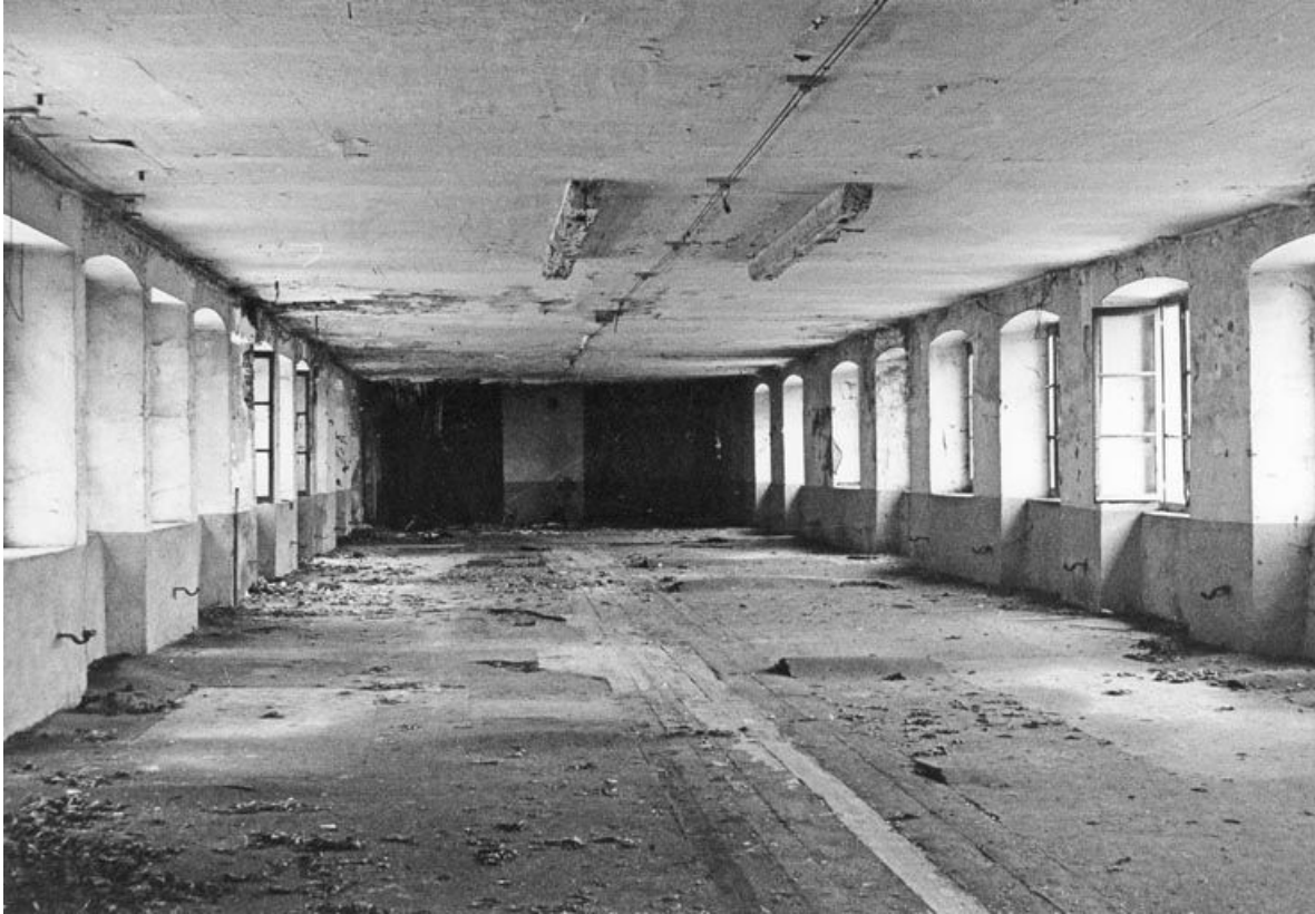
Atelier de fabrication : vue intérieure du deuxième étage.
