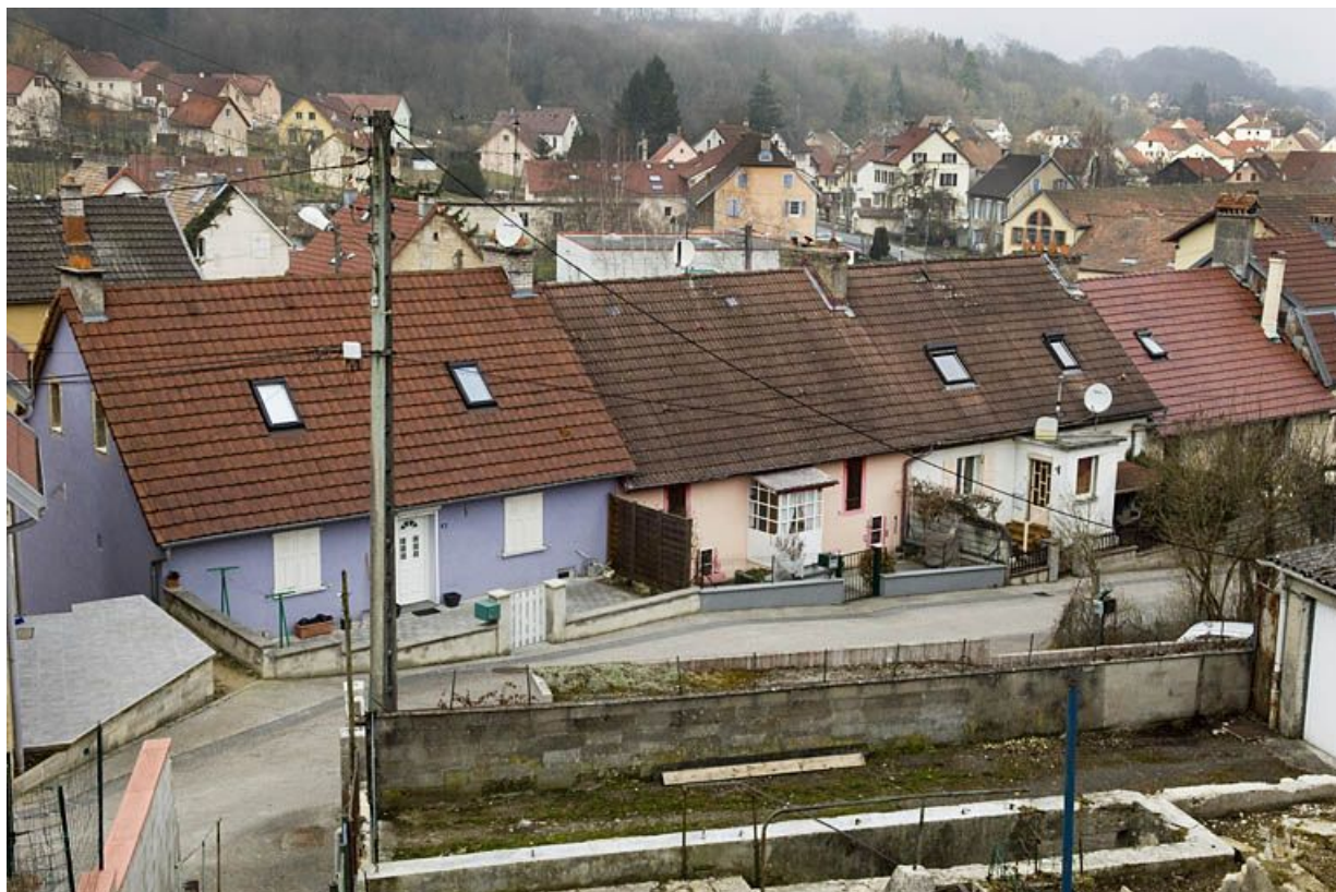
Façades postérieures des logements ouvriers (rue de la Voûte). 25, Badevel Grande Rue
