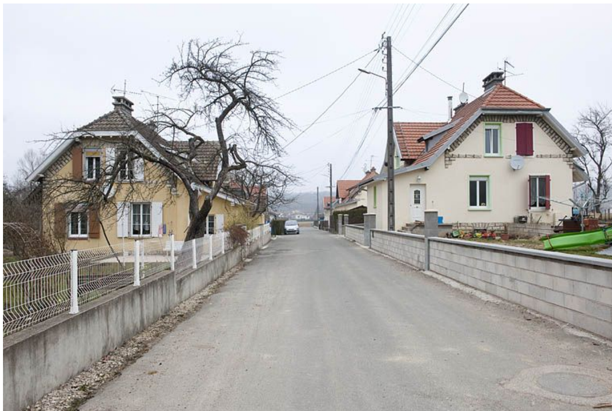
Vue d'ensemble depuis la rue.
