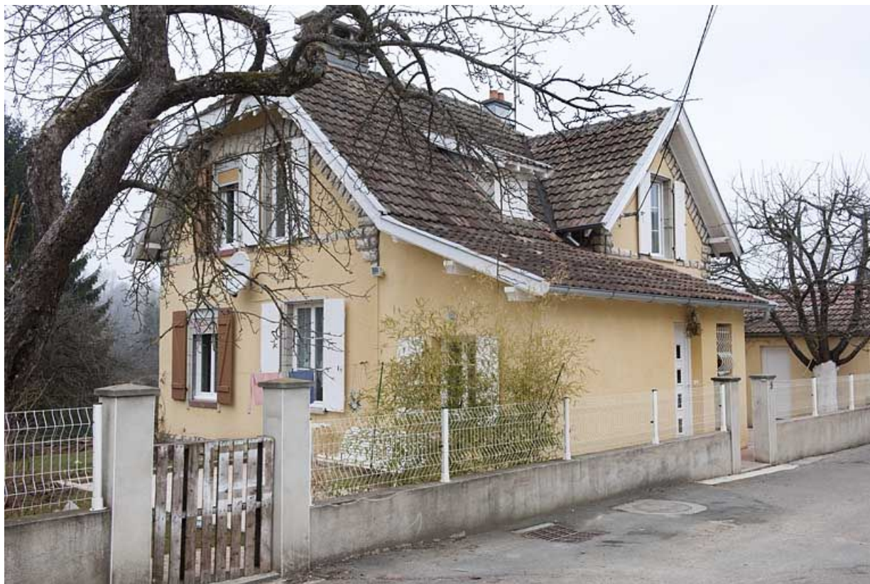
Maison jumelée. Vue de trois quarts gauche. 25, Badevel rue des Cités
