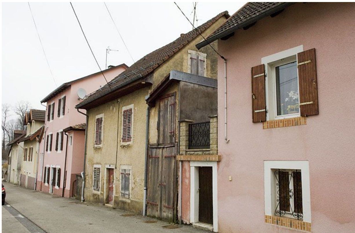
Vue d'ensemble du bas de la rue de la Voûte.
