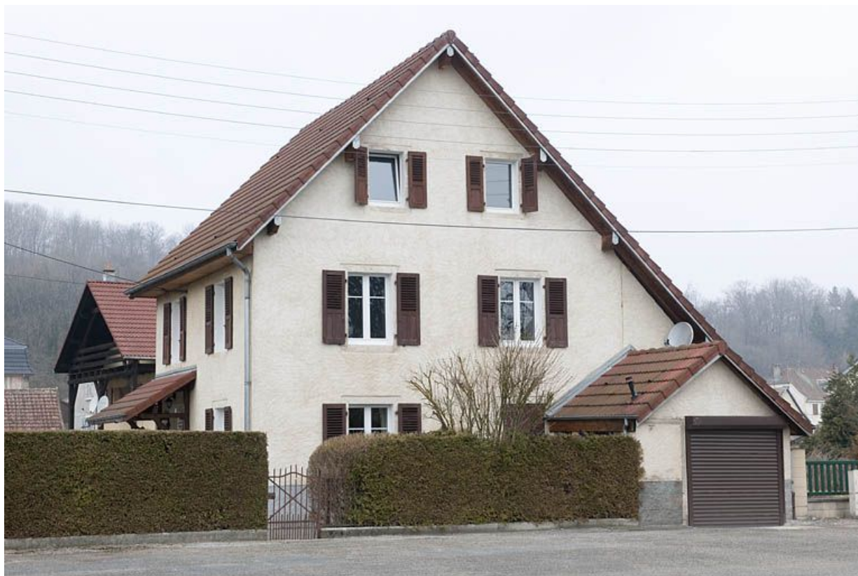
Pignon d'une maison individuelle donnant sur la place publique.
