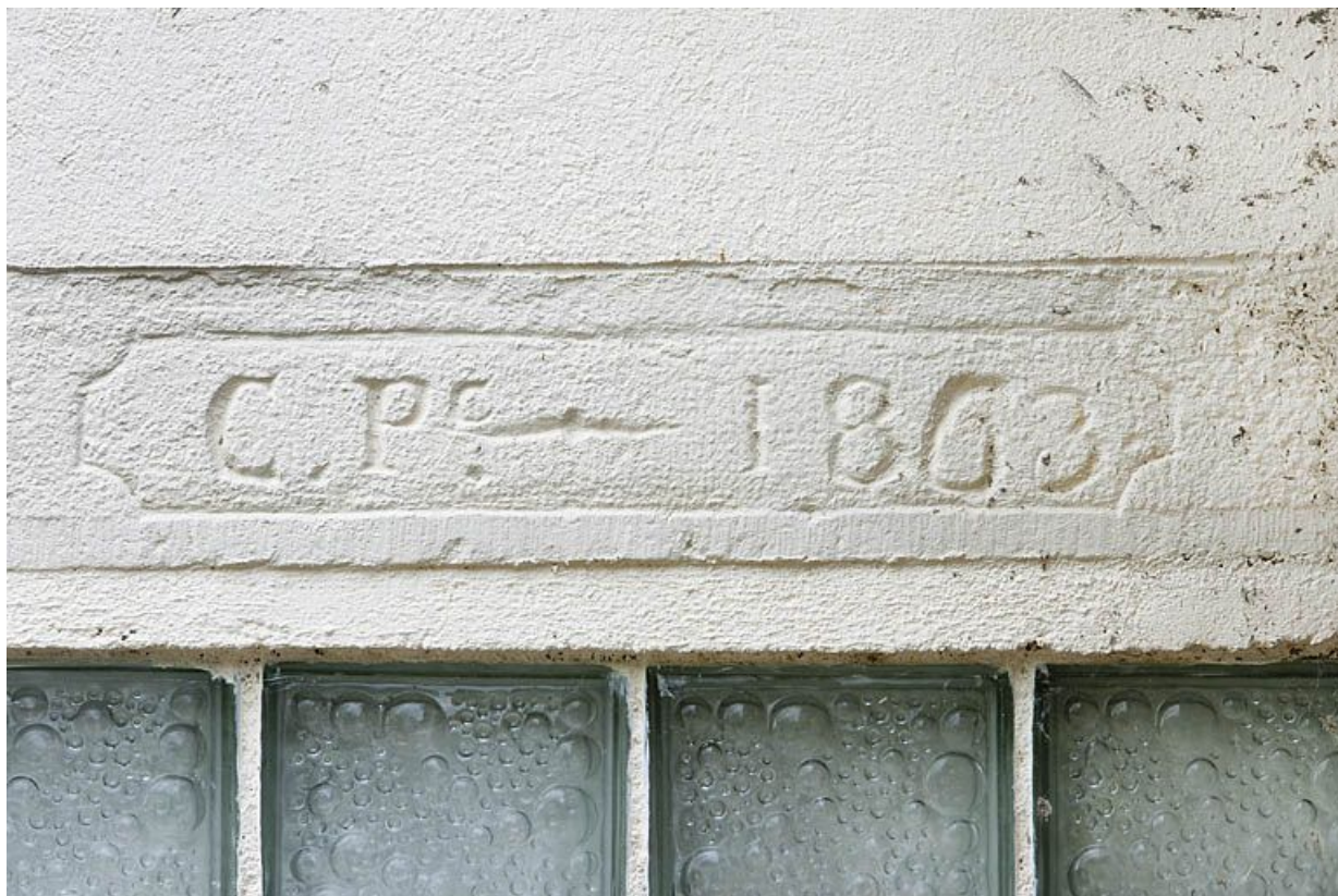
Linteau de porte d'une maison individuelle (rue du Mavuron).
