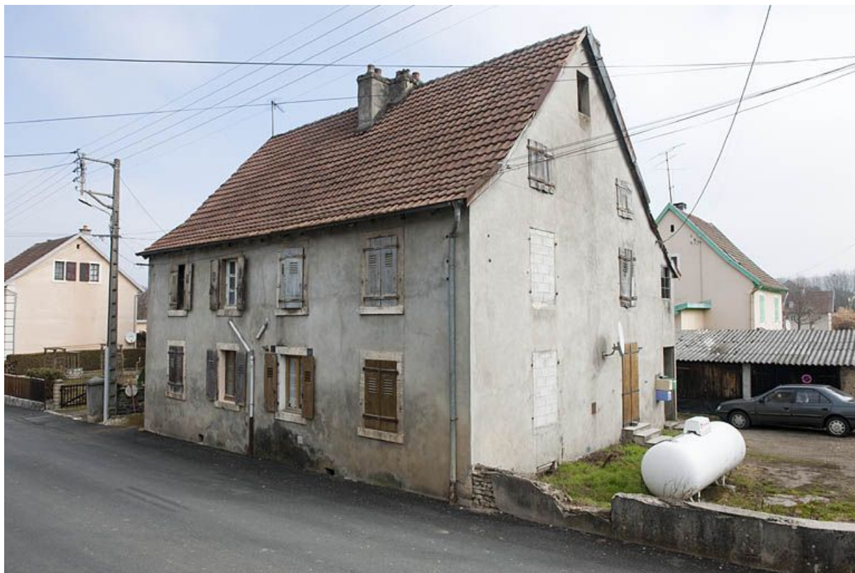
Immeuble à 4 logements dit "la Bastille".
