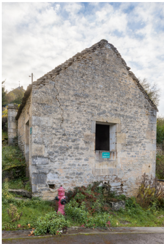
Vue de la façade nord.
