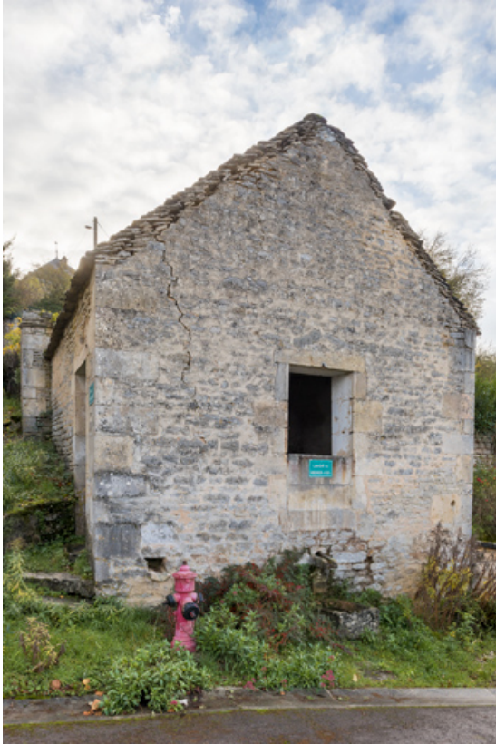
Vue de la façade nord.
