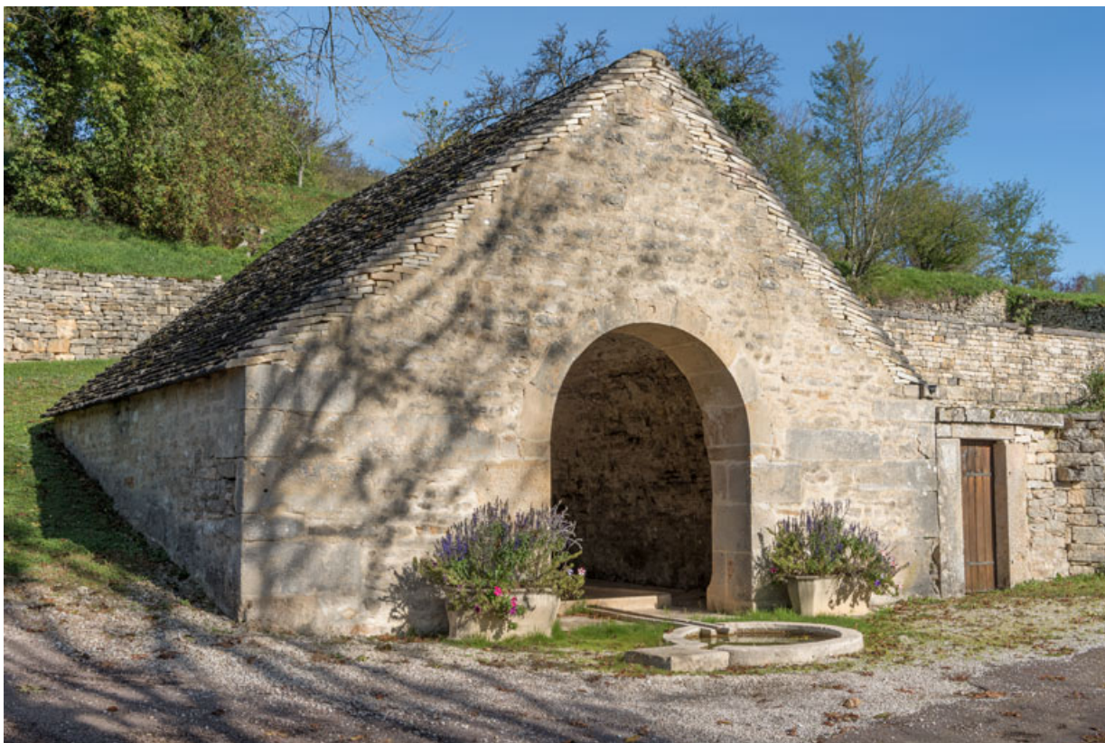
Vue de la façade ouest.
