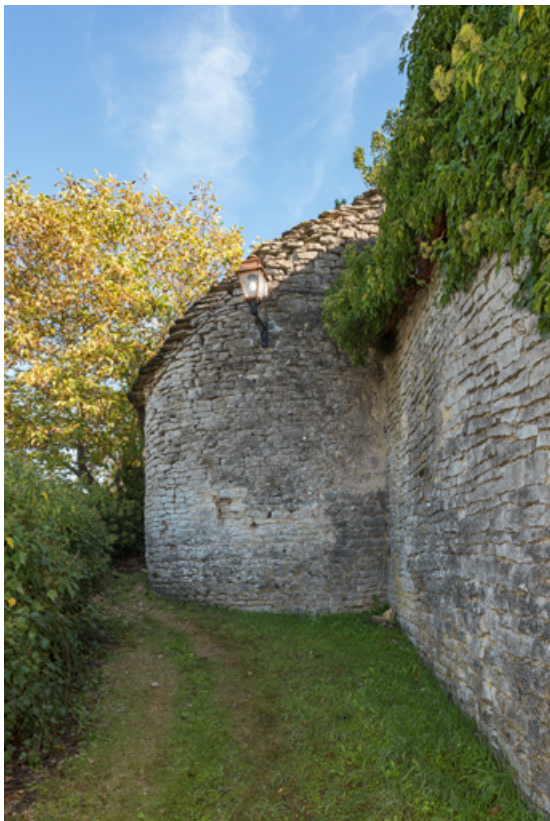
Vue d'ensemble de la deuxième tour côté sud-ouest.
