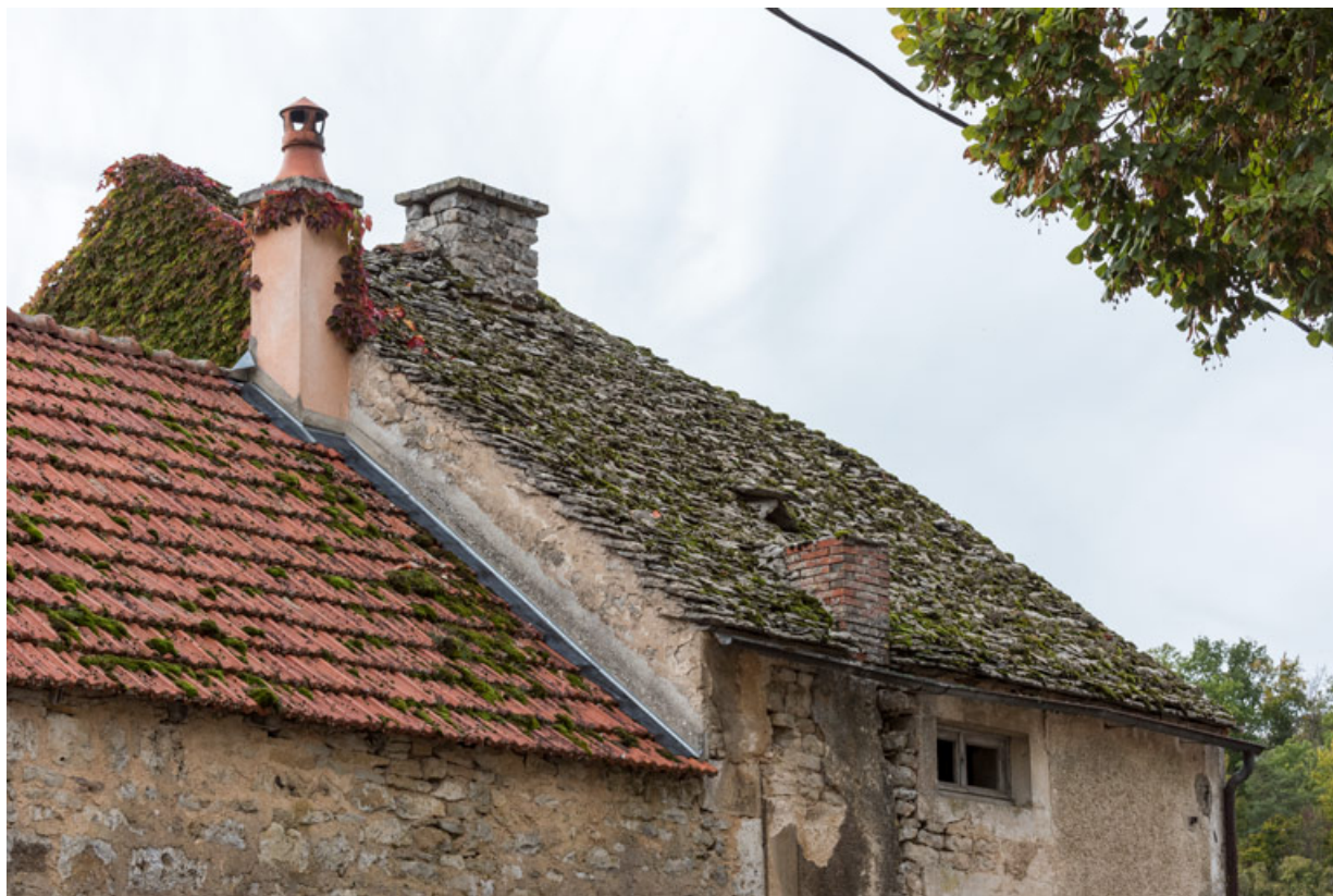
Détail de la toiture depuis le nord-est.
