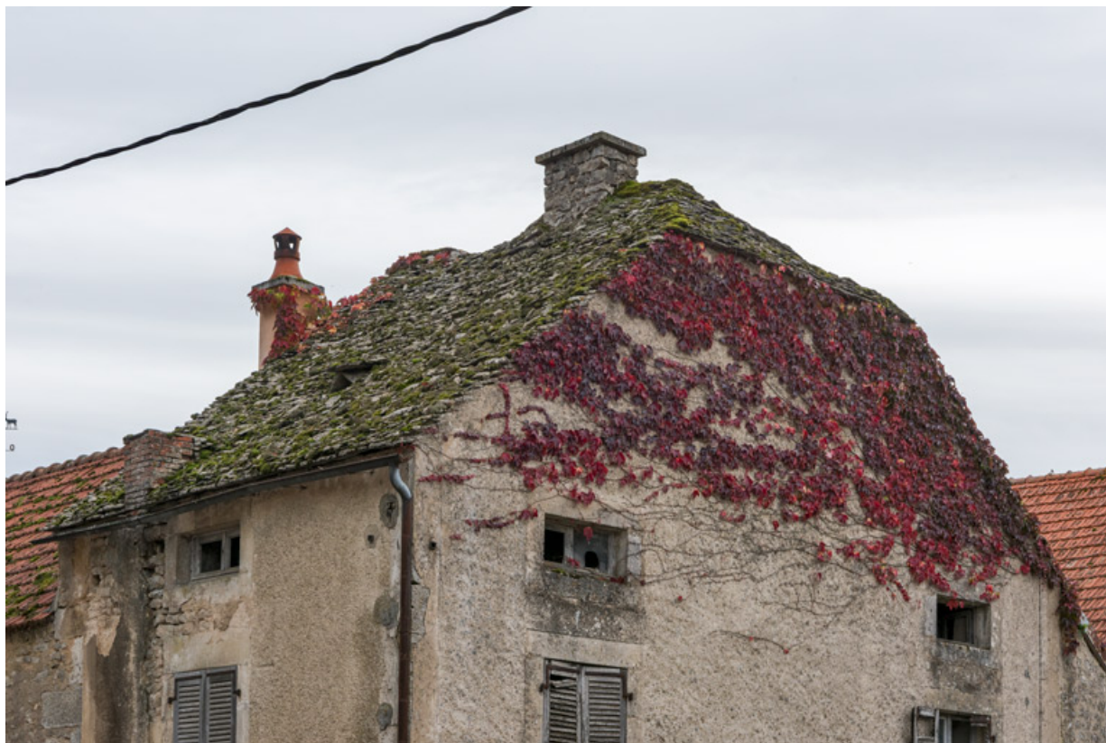
Détail de la toiture depuis le nord-ouest.
