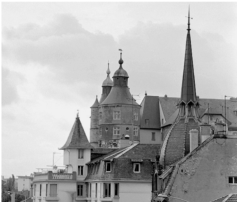
Château Neuf vu du quartier de la gare. 25, Montbéliard
