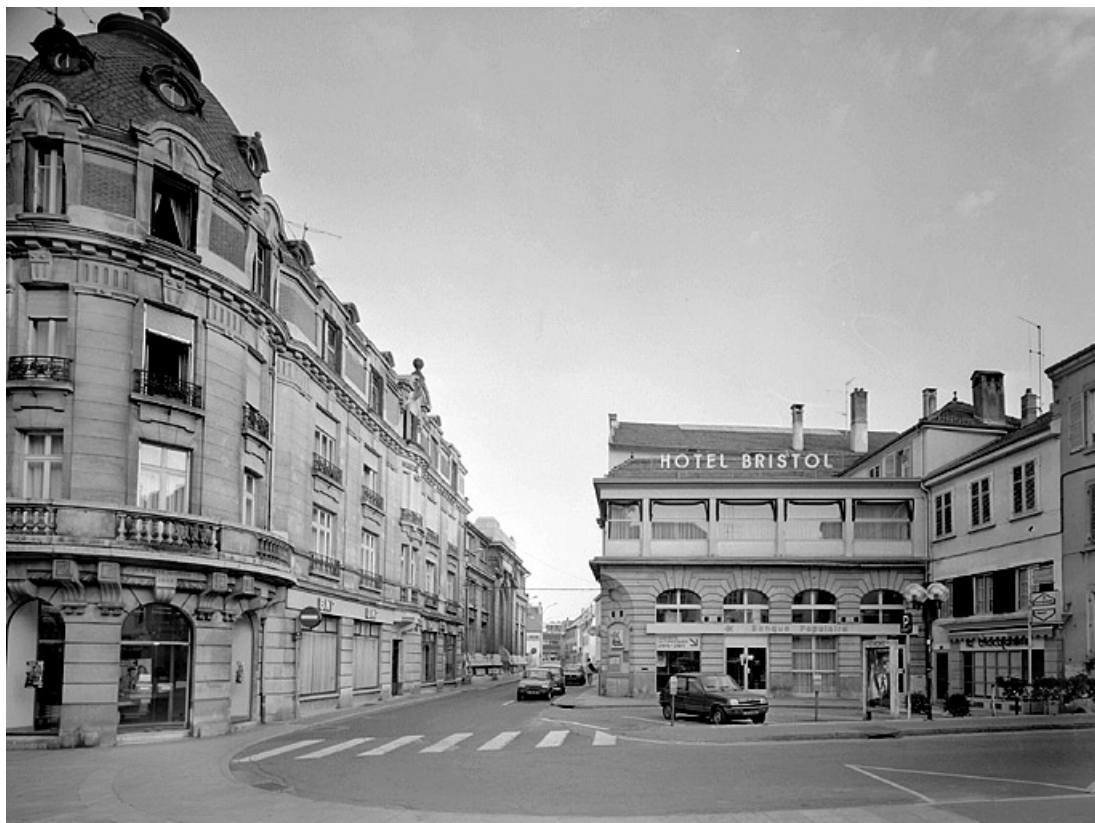
Place Albert-Thomas, côté nord. 25, Montbéliard
