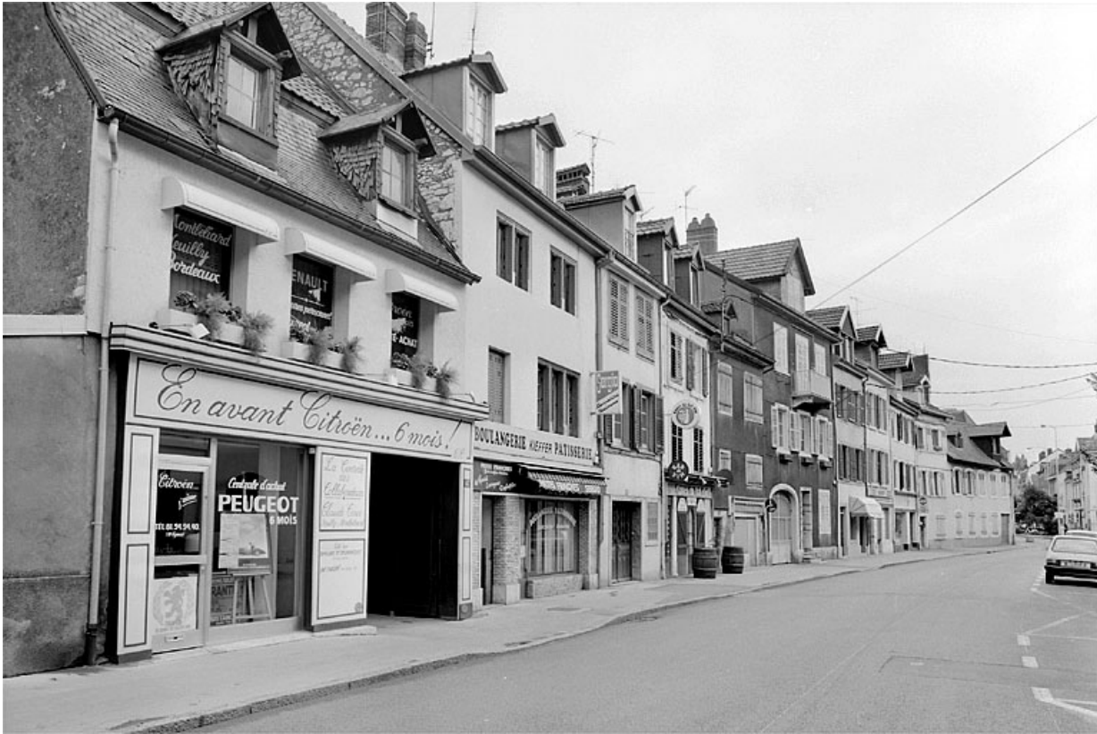
Partie septentrionale de la rue Georges-Clémenceau. 25, Montbéliard
