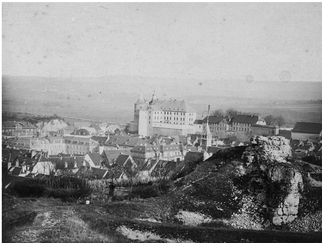
Vue d'ensemble prise du site de la citadelle, dernier tiers 19e siècle. 25, Montbéliard
