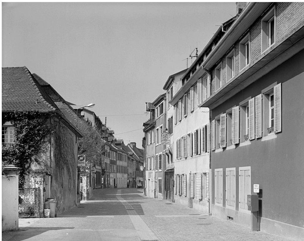
Rue de Belfort. 25, Montbéliard
