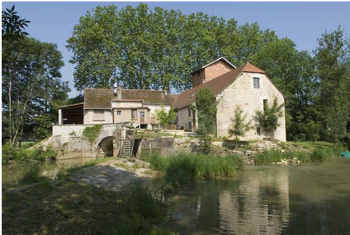
Vue d'ensemble depuis le barrage.
